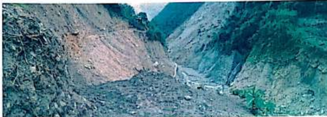
Ilustración 27. Sector de, se pueden observar deslizamientos recientes de grandes dimensiones, que afectaron el talud de ambas márgenes del río Humantay. Margen izquierda camino de herradura que une Soraypampa con Chaulay afectado.
