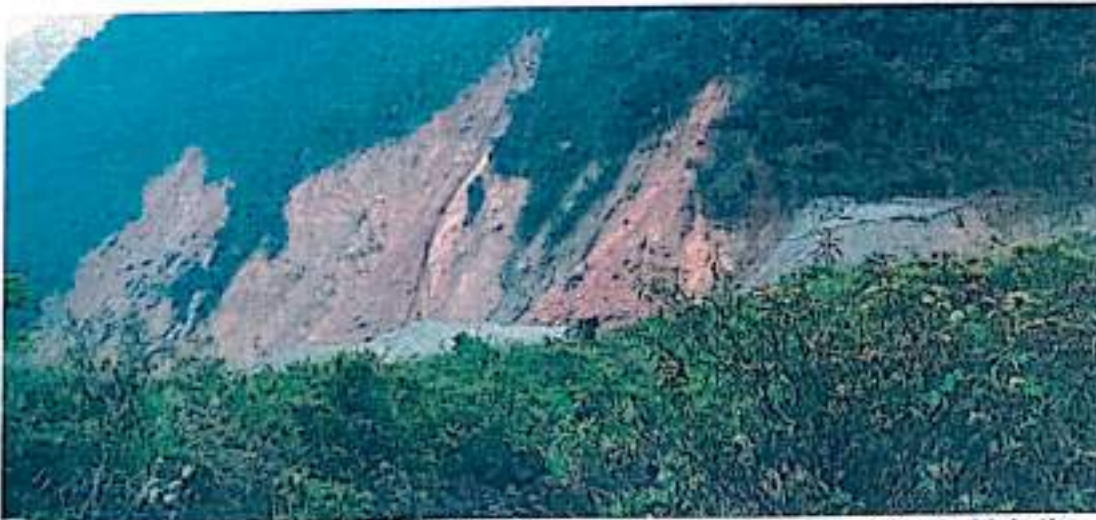
Ilustración 26. Sector Anoen (UTM: 755,107E; 8'526,248N) deslizamientos recientes, a consecuencia del aluvión provocó del 23/02/2020, que a su vez se alimentó de más material, en el transcurso del aluvión hacia las partes bajas.
