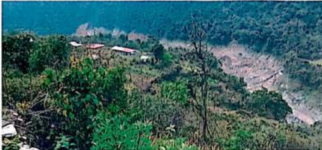
Fotografía 8. Erosión en ambas márgenes del río Humantay en el sector de Rayampata, se observa ambas márgenes del río erosionado por el aluvión 23/02/2020.
