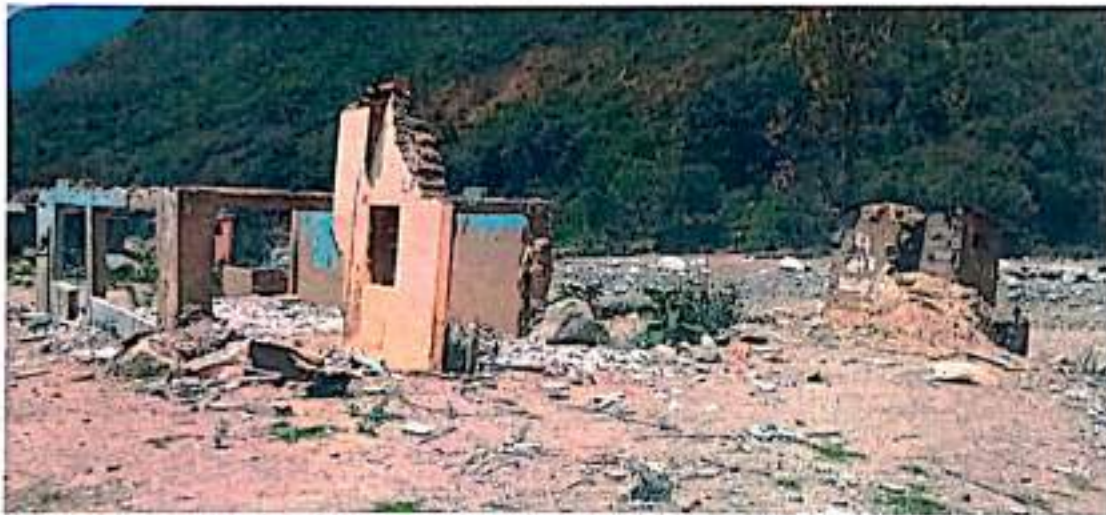
Fotografía 9. Centro poblado Ploya Salmuyaco, impacto del aluvión 23/02/2020.
