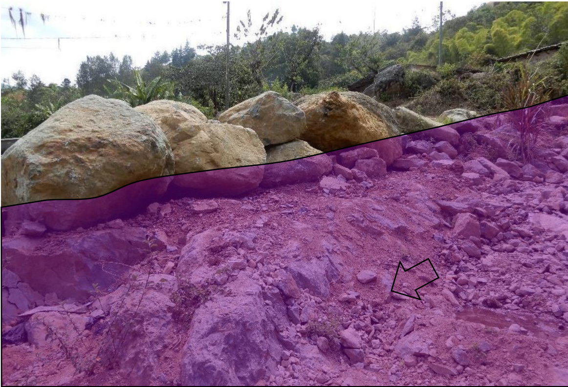
Figura 13. Bloques de gran tamaño en el cauce de la quebrada Sicacate y el abanico. Coordenadas 9486250N y 632404E.
