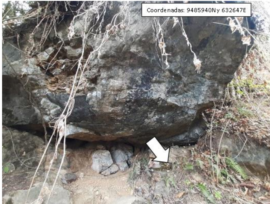
Figura 25. Andesitas fracturadas y dispuestas sobre pendientes fuertes en el sector Sicacate.
