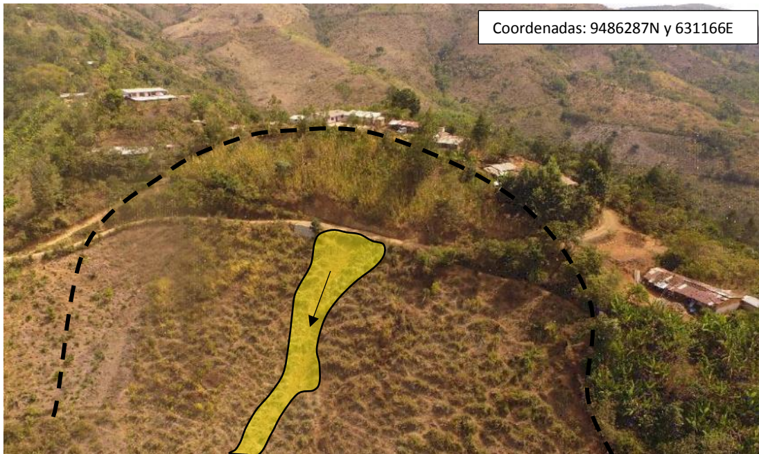
Figura 21. Vista panorámica del deslizamiento reciente en la vía de acceso al caserío Loma de Sicacate.
