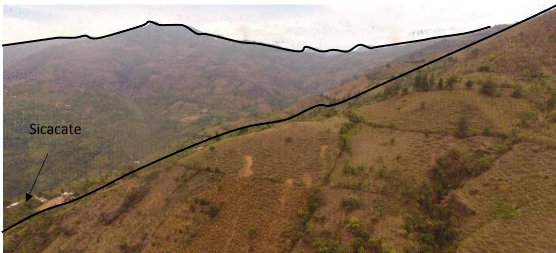
Figura 6. Montañas ubicadas al sur del caserío Sicacate, coordenadas 9485770N y 632761E.
