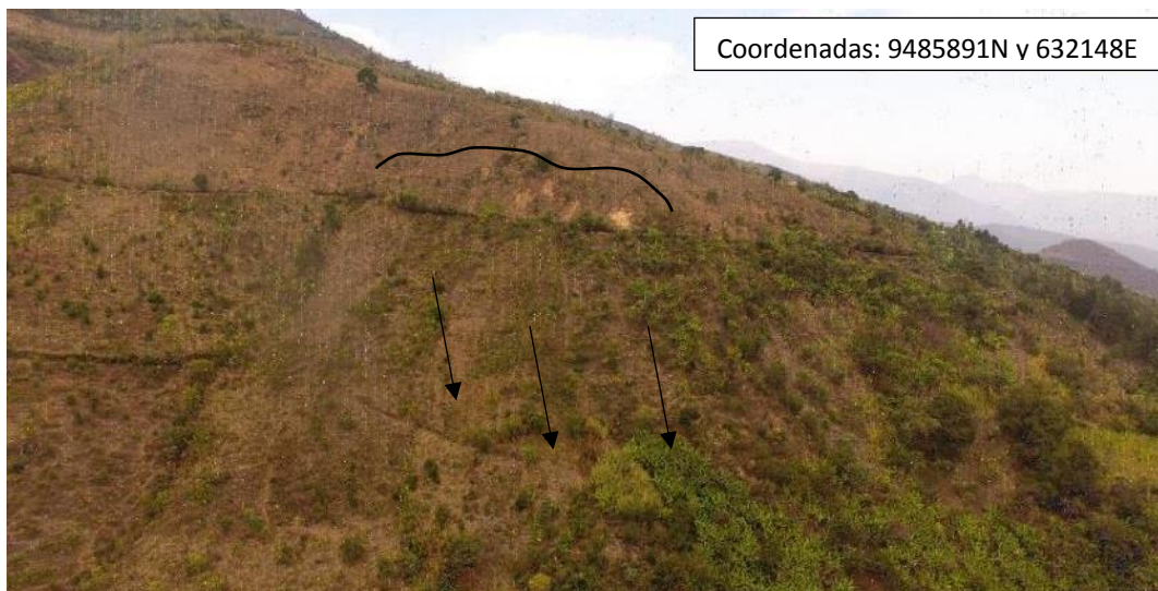
Figura 19. Vista del cerro Sicacate Alto con presencia de deslizamientos.
