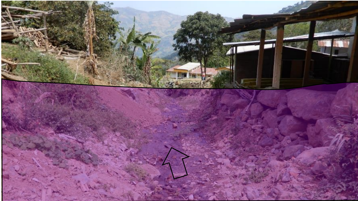
Figura 11. Cauce de la quebrada Sicacate por donde pasó el flujo de detritos el 25 marzo del 2017. Vista en las coordenadas 9486263N y 632391E.
