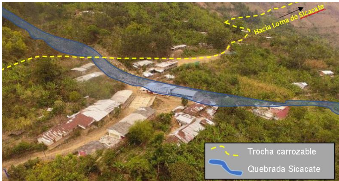
Figura 32. Trocha carrozable Montero – Sicacate en las coordenadas 9486204N y 632396E.
