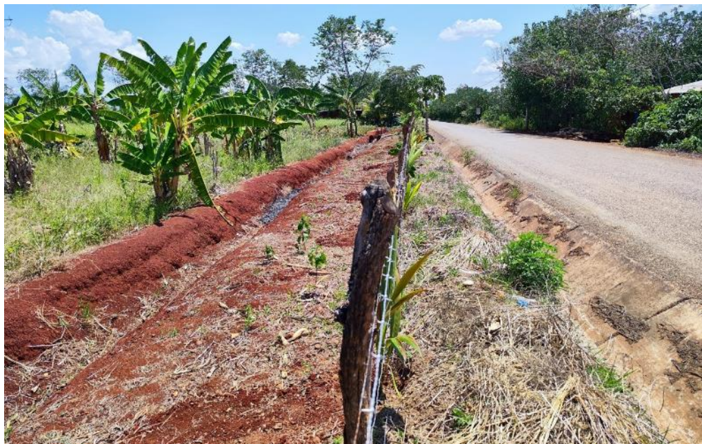
Fotografía 5. Canales sin revestimiento impermeable en la parte alta del caserío Cunía.
