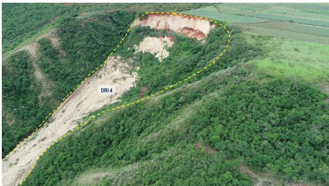
Figura 28. Vista del deslizamiento inactivo DRI 4 el 17/12/2019. Fuente: Gobierno Regional de Cajamarca.
