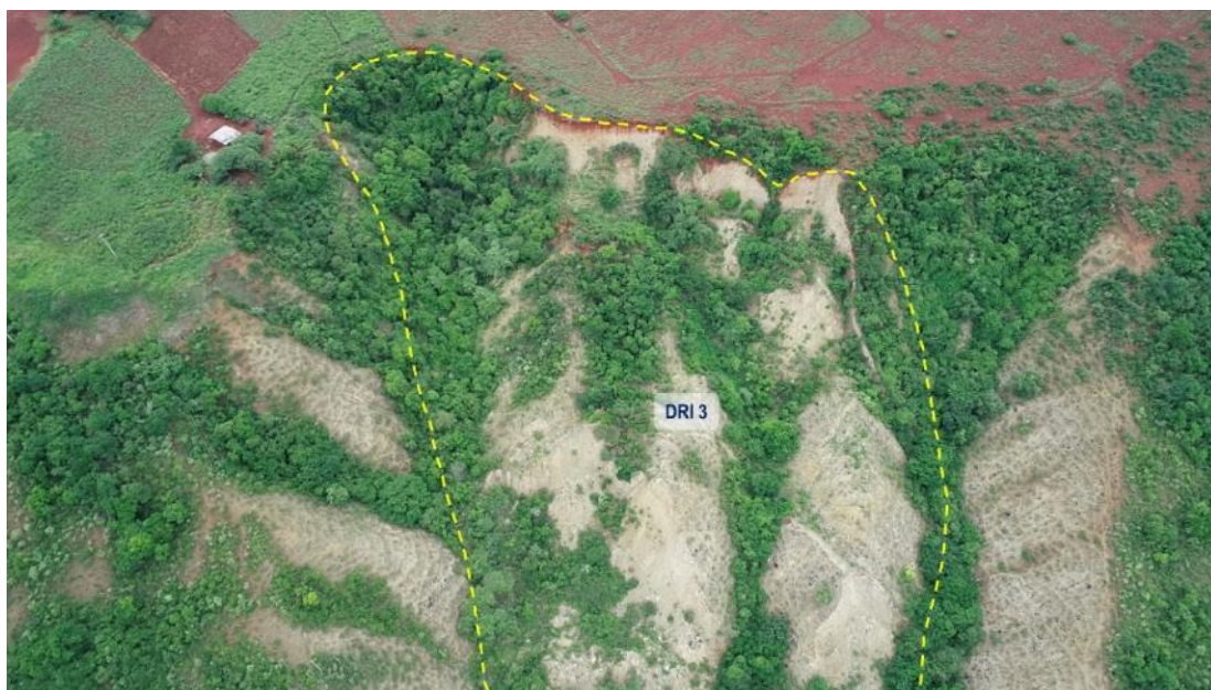
Figura 26. Vista del deslizamiento inactivo DRI 3 el 18/12/2019. Fuente: Gobierno Regional de Cajamarca.
