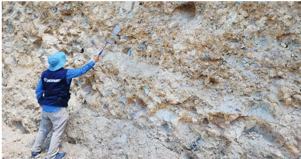
Fotografía 1. Vista de un corte de carretera en la Formación Tamborapa, estando el macizo muy fracturado y completamente meteorizado. Ubicación: E: 741806; N: 9403590; Z: 743.
