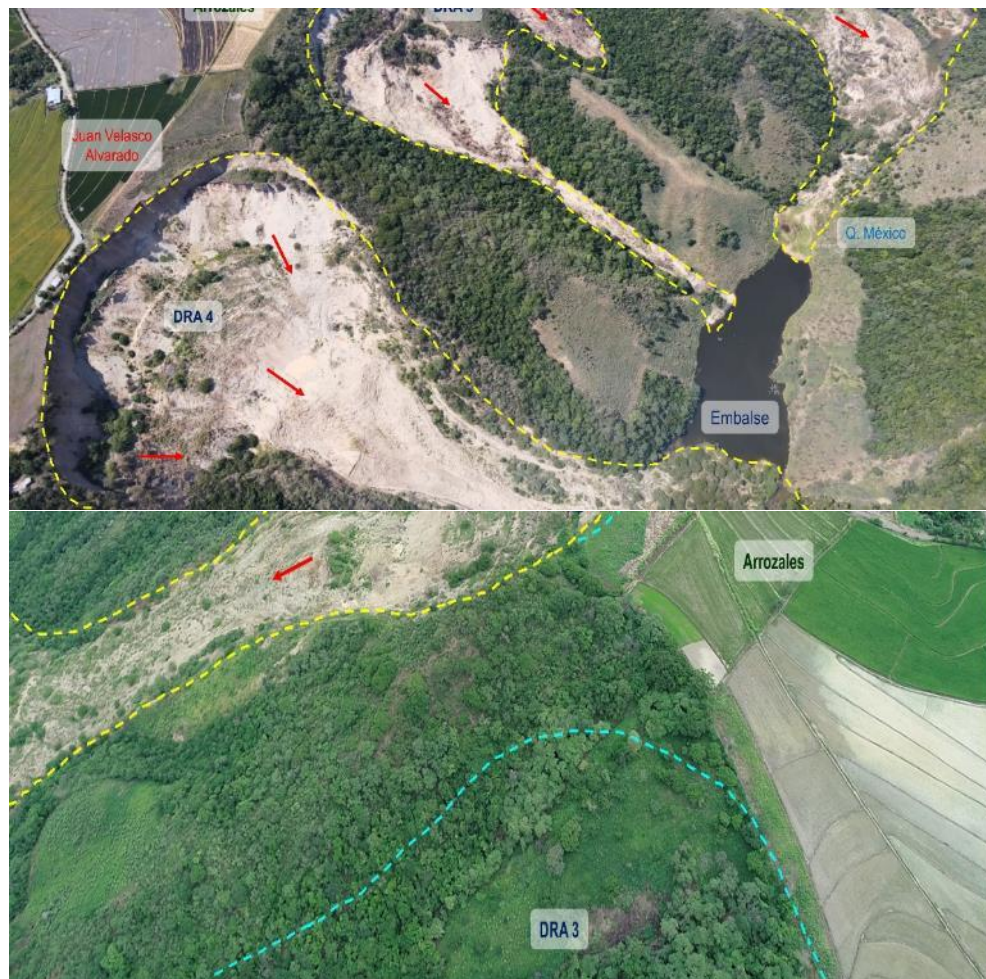
Figura 20. Deslizamiento DRA 3 y DRA 4 en el caserío Juan Velasco Alvarado el 06/12/2022 (arriba) y sus situación el 18/12/2019 (abajo).
