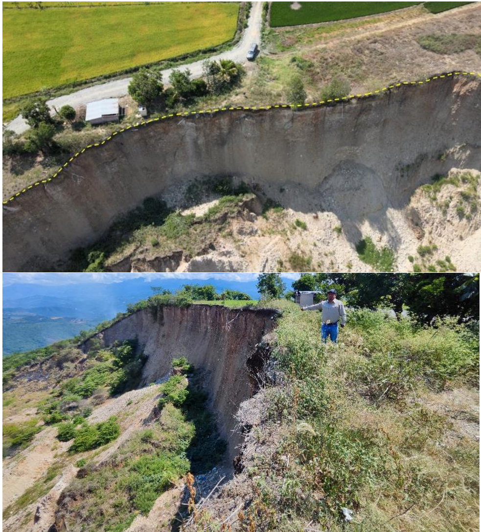
Figura 21. Vista del escarpe del deslizamiento DRA 2 el 08/07/2021 desde un dron (arriba) y en superficie (abajo).
