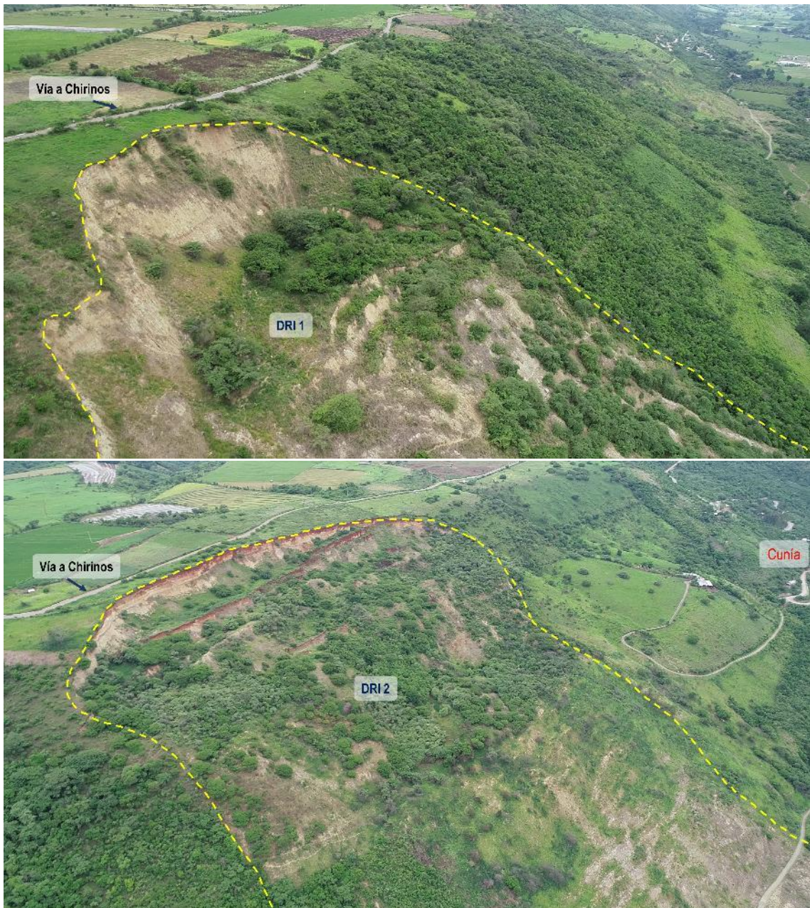
Figura 24. Vista de los deslizamientos inactivos DRI 1 y DRI 2 el 17/12/2019. Fuente: Gobierno Regional de Cajamarca.
