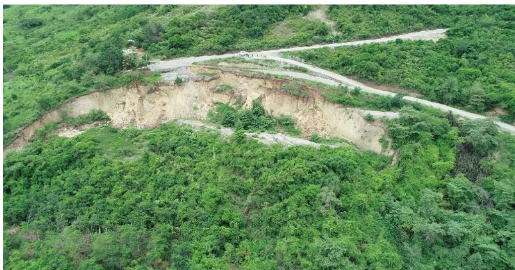
Fotografía 3. Vista del escarpe del deslizamiento Cunía en diciembre del 2019. Fuente: Gobierno Regional de Cajamarca.
