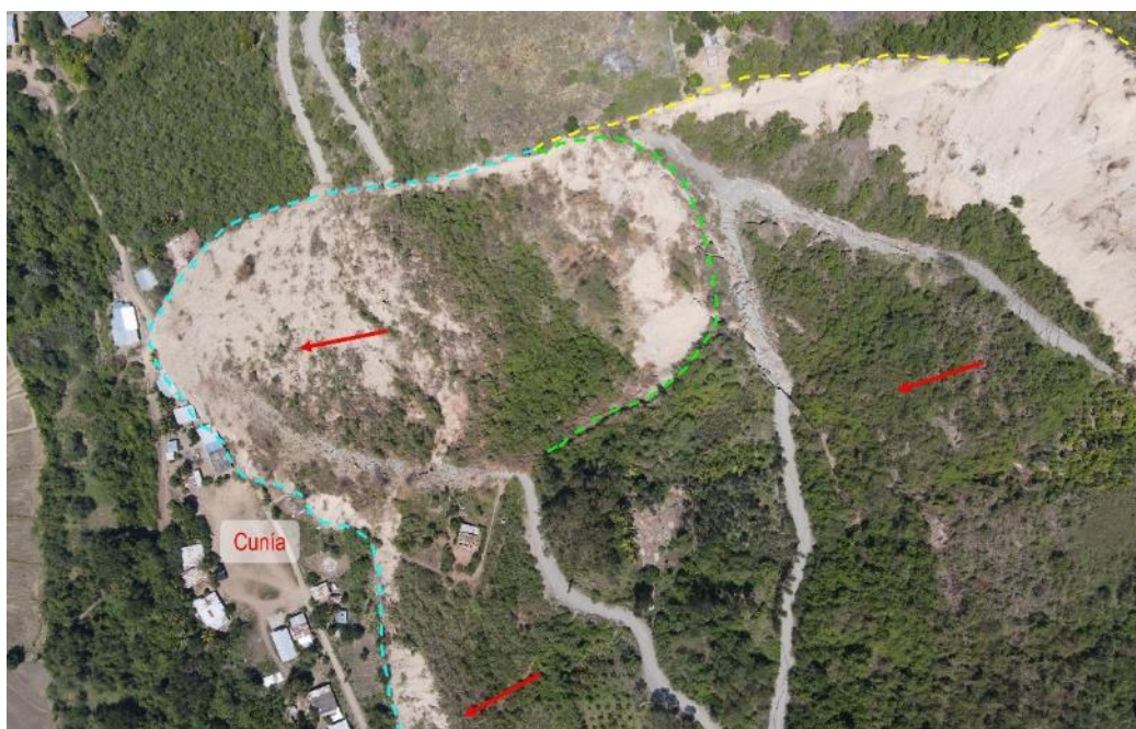
Figura 17. Parte baja del deslizamiento Cunía, donde se aprecia el escarpe reactivado del deslizamiento 2018 (en verde) y el escarpe actual (en amarillo).
