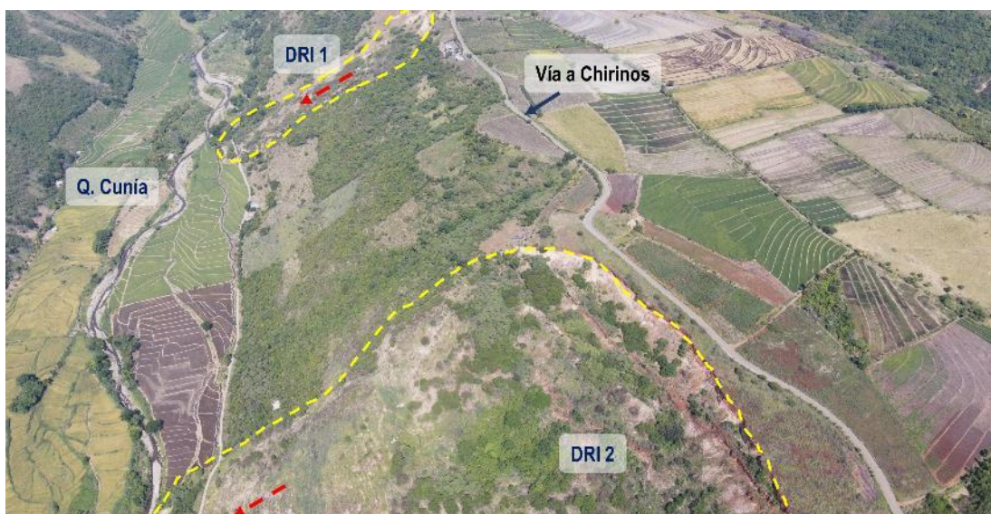
Figura 23. Vista de los deslizamientos inactivos DRI 1 y DRI 2 el 06/12/2022.
