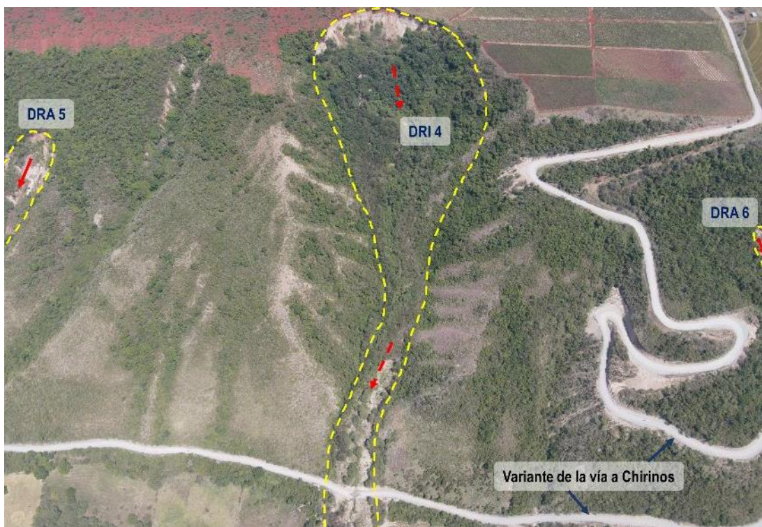
Figura 27. Deslizamiento inactivo DRI 4 ubicado entre los deslizamientos activos DRA 5 y DRA 6 el 06/12/2022.
