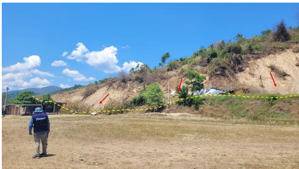
Fotografía 6. Frente del deslizamiento en el caserío Cunía, lugar de acumulación de los suelos en remoción y de mayor afectación, como ambientes de la IE 16755.
