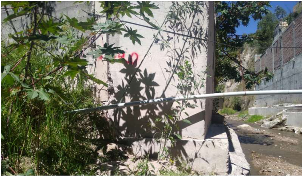
FIGURA N°02: TRAMO CRÍTICO EN LA QUEBRADA HUICHCCANA, DONDE SE APRECIAN VIVIENDAS EN RIESGO
