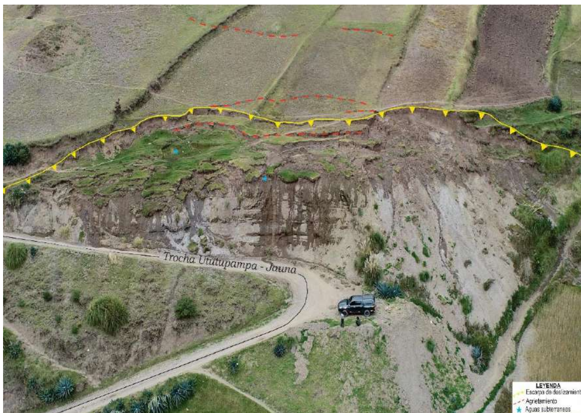
Figura 13. Vista del deslizamiento rotacional del caserío Ututupampa, se observa que en el cuerpo del deslizamiento existen dos puntos por donde emanan aguas subterráneas.
