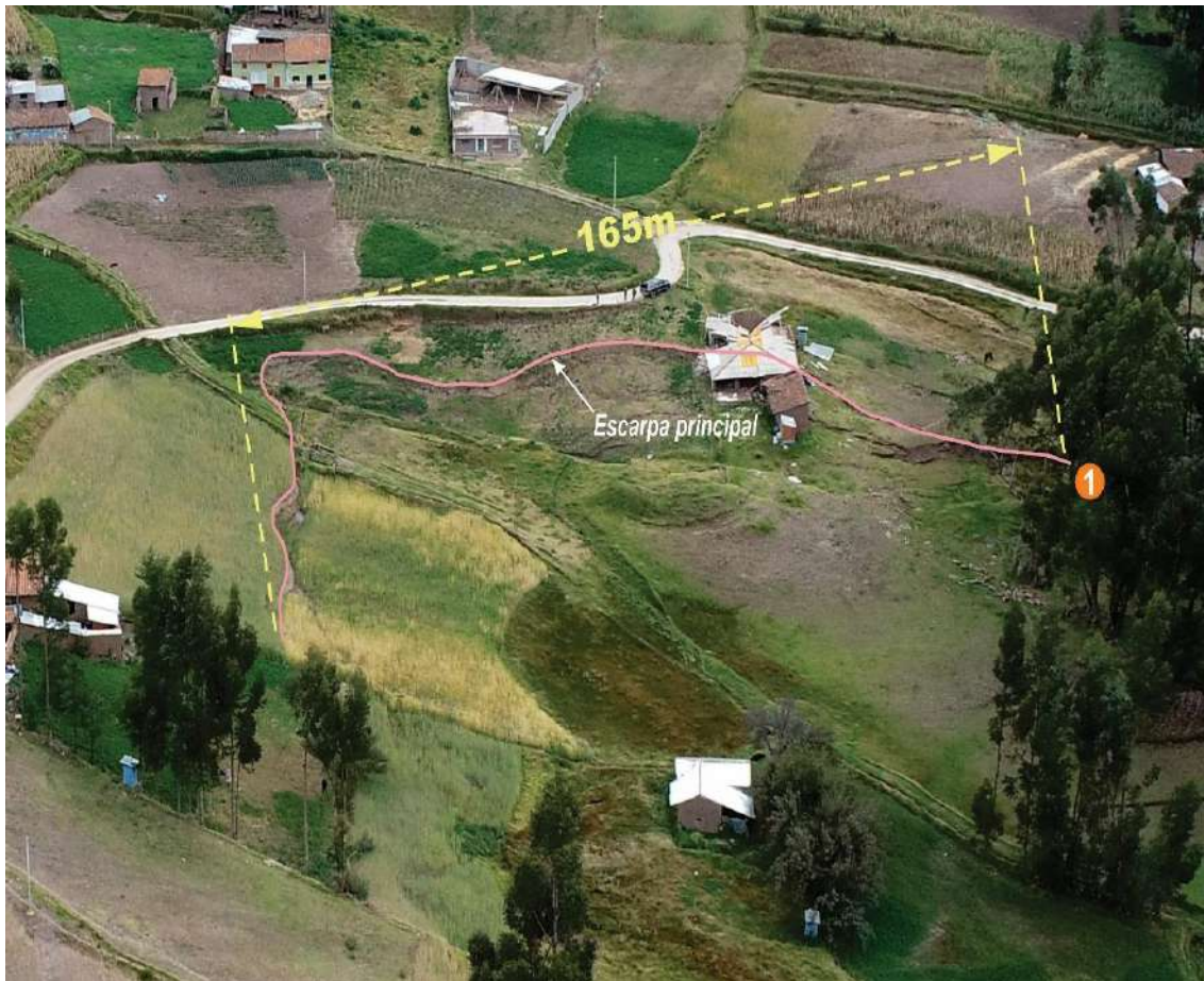
Figura 21. Vista del deslizamiento rotacional del caserío Lloclla, se observa que en el cuerpo del deslizamiento existen agrietamientos transversales; así como presencia de agua subterráneas.
