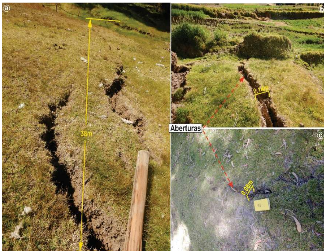
Figura 23. a) Vista de grietas en el terreno de 38 m de longitud, b) aberturas de hasta 0.10 m; y profundidades visibles de hasta 0.25 m y c) abertura de 0.08 m, que afectaron a cultivos y terrenos de pastoreo.
