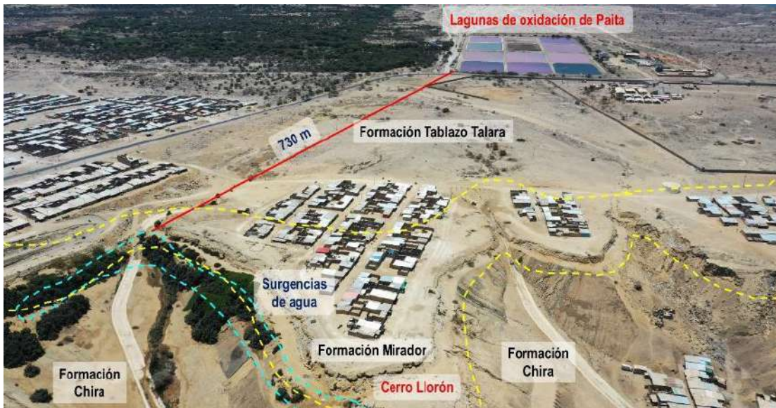
Figura 9. Distancia entre las lagunas de oxidación de Paita y las surgencias de agua en el Cerro Llorón, sector PJ San Martín Central.
