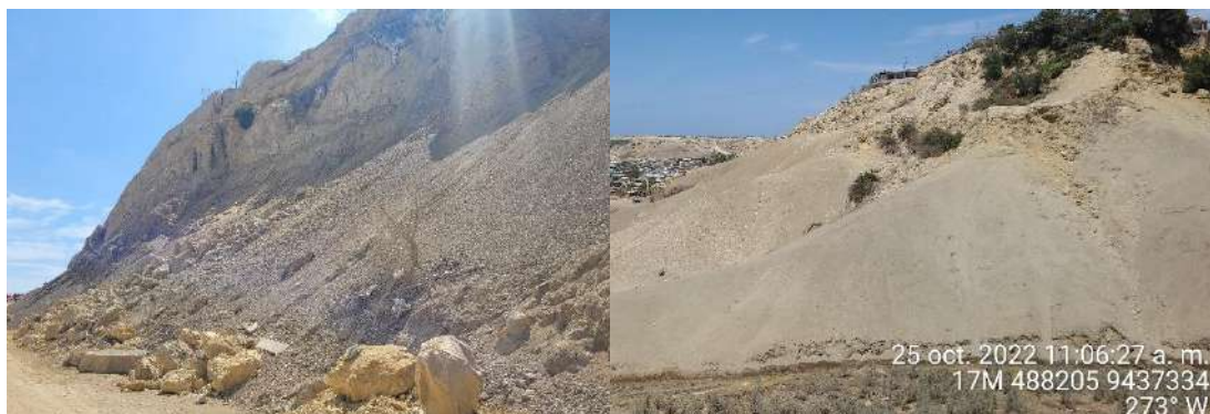
Fotografía 9. Ladera con pendiente muy escarpada ( >45^\circ ) de pendiente en el sector Jr. Junín C9 (izquierda) y con pendiente escarpada ( 25^\circ a 45^\circ ) en el sector PJ Nueva Esperanza (derecha).
