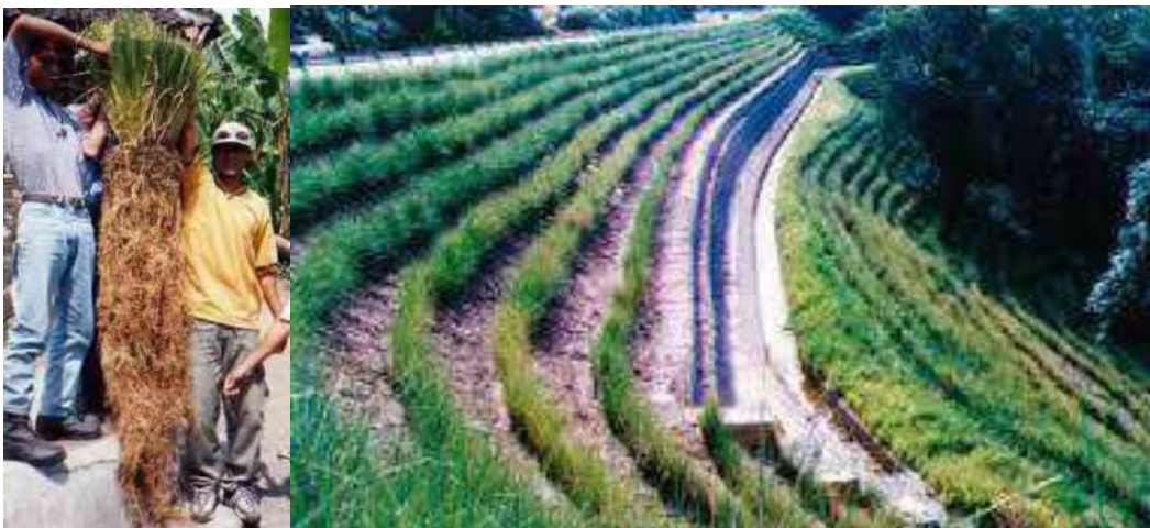
Fotografía 11. Ejemplo de bioingeniería con arbusto (vetiver) en taludes de materiales sueltos.
