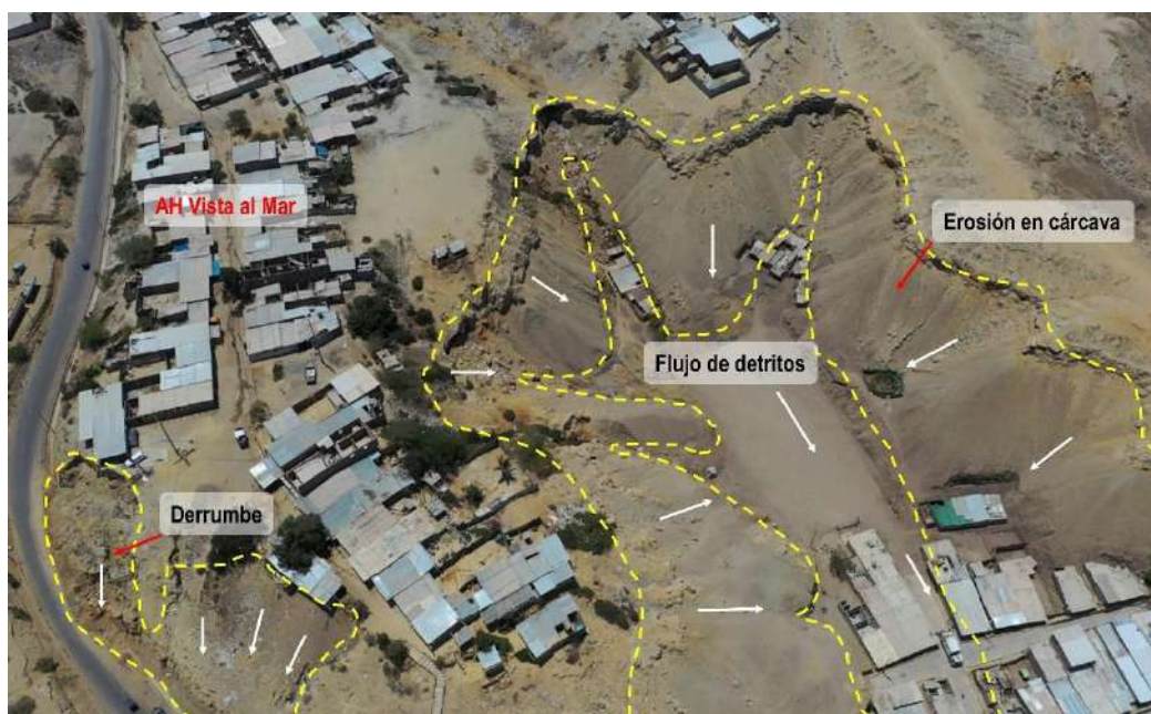
Figura 16. Vista a los diversos movimientos en masa del sector AH Vista al Mar.
