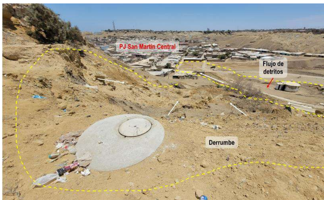
Figura 19. Derrumbes en el Jr. Junín C9, vista hacia el oeste.
