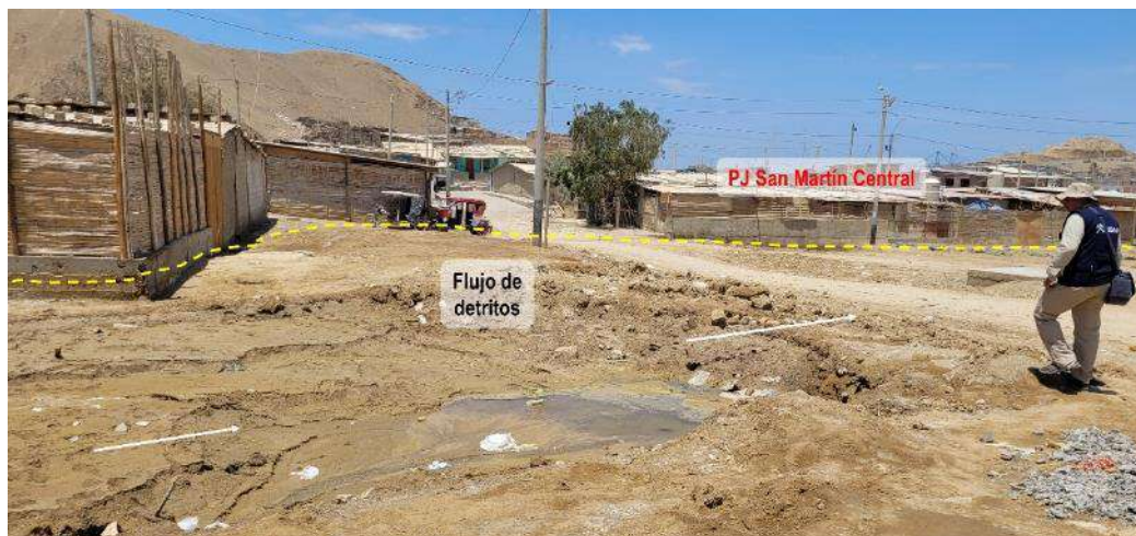
Figura 20. Zona final de la canalización, donde los flujos de detritos del Cerro Llorón desbordan y afectan al PJ San Martín Central.
