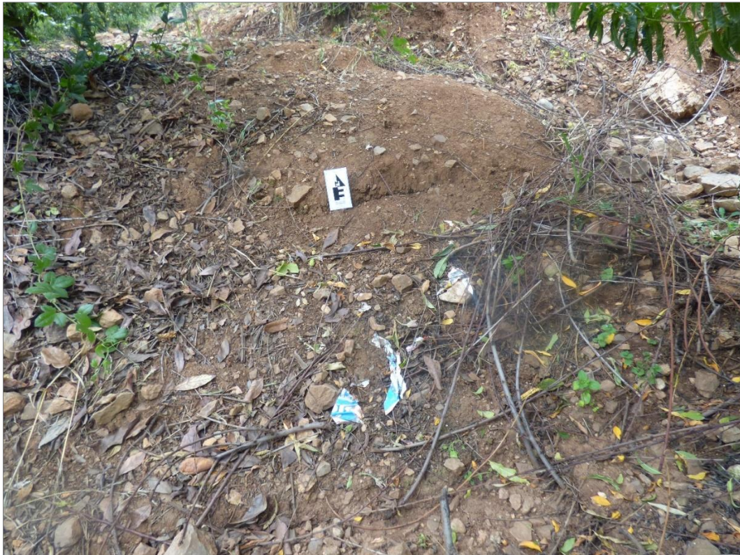
Fotografía 10. Agrietamientos longitudinales, con aperturas milimétricas, en el cuerpo del derrumbe activo.
