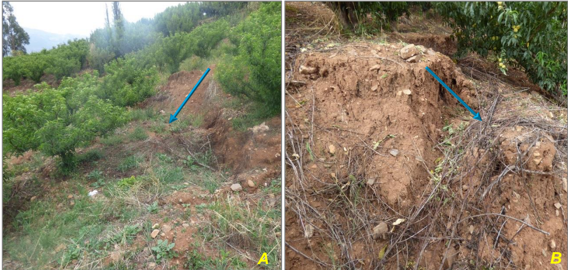
Figura 10. Vista del derrumbe ocurrido en suelos arenos arcillosos, se aprecian terrenos con una inclinación de 28°.
