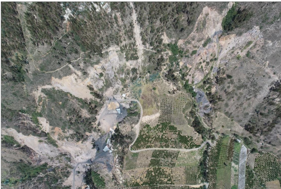
Fotografía 9. Vista de derrumbes continuos en el interior de las cárcavas.
