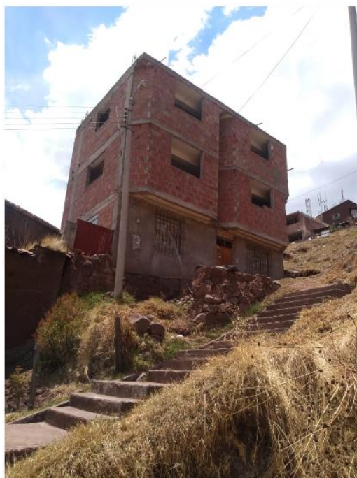
Fotografía 10: Red de Alumbrado público
