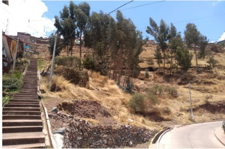
Fotografía 3: Vías peatonales: Escalinatas de concreto, A.HH. El Calvario, Mirador y Tierra Prometidas
