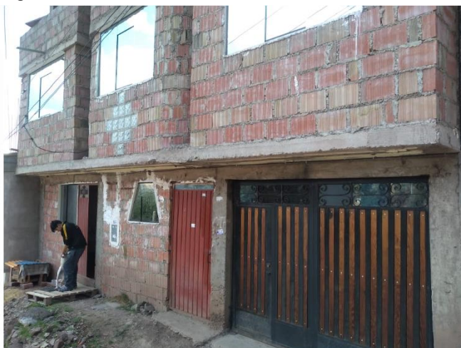
Fotografía 7: Material constructivo de ladrillo y concreto armado
