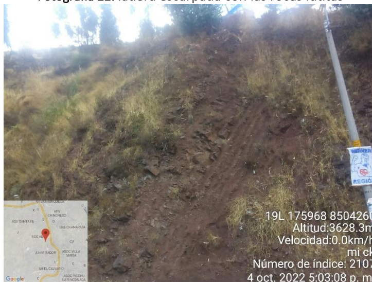
Fotografía 22: ladera escarpada con las rocas lutitas
