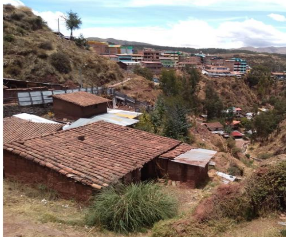
Fotografía 6: Material adobe en edificaciones del sector
