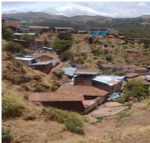
Fotografía 4: Vista de las edificaciones del ámbito de influencia de la quebrada
