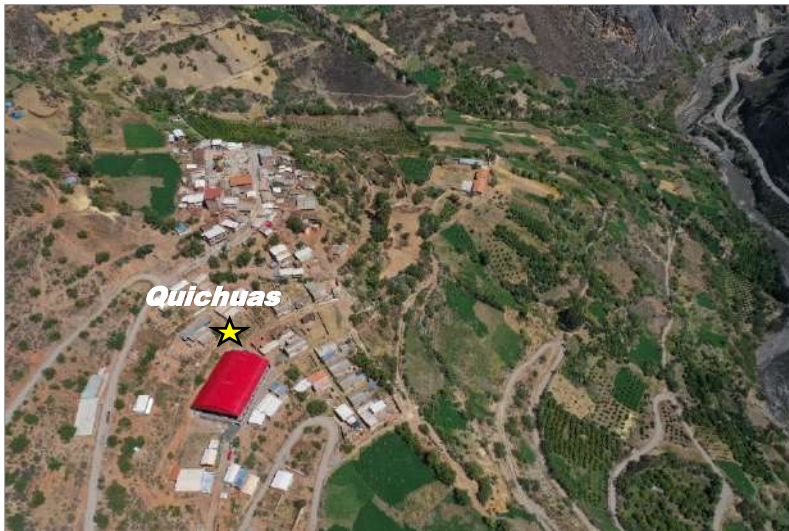
Figura 41. Vista al noreste del deslizamiento donde se sitúa el poblado de Quichuas.
