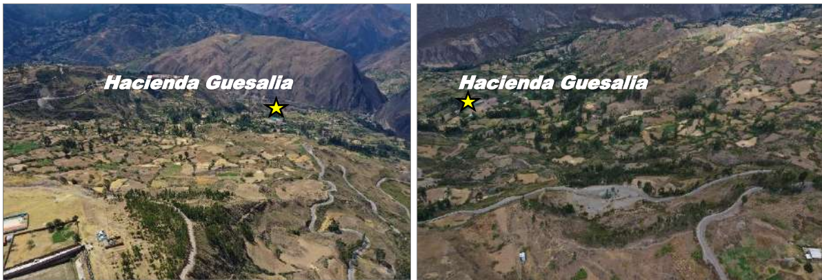
Figura 33. A) Vista panorámica de deslizamientos antiguos, en cuyo pie se encuentran asentados los sectores de Hacienda Guesalia y Uranchacra. B) Vista al sureste de Hacienda Guesalia, muy susceptible a ser afectado por deslizamientos.
