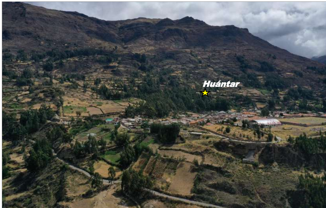
Figura 31. Vista panorámica de los deslizamientos ocurridos en Huántar.
