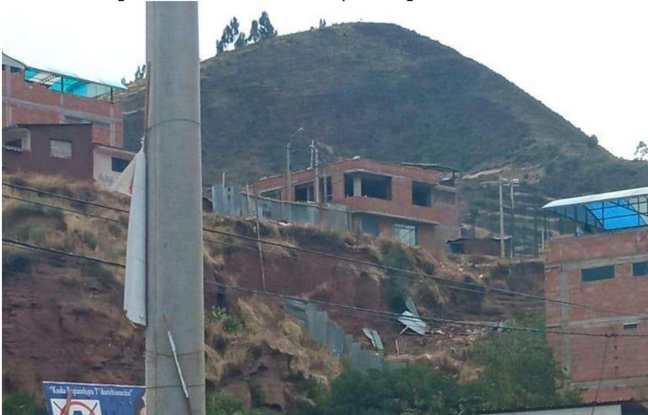
En la zona de estudio se observó que se están generando cortes de terreno generando desestabilización de viviendas afectando a la zona alta y que en un futuro se generen desastres esto debido a la erosión pluvial que lleva consigo material (sedimentos).
