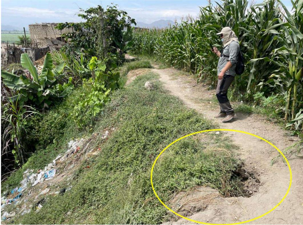
Figura 13. Zona de ladera sometida a proceso erosivo, con incidencia de hundimiento del suelo (círculo amarillo).
