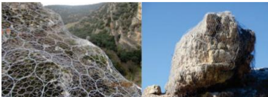
Figura 4. Ejemplos de estabilización con red de anillos.
