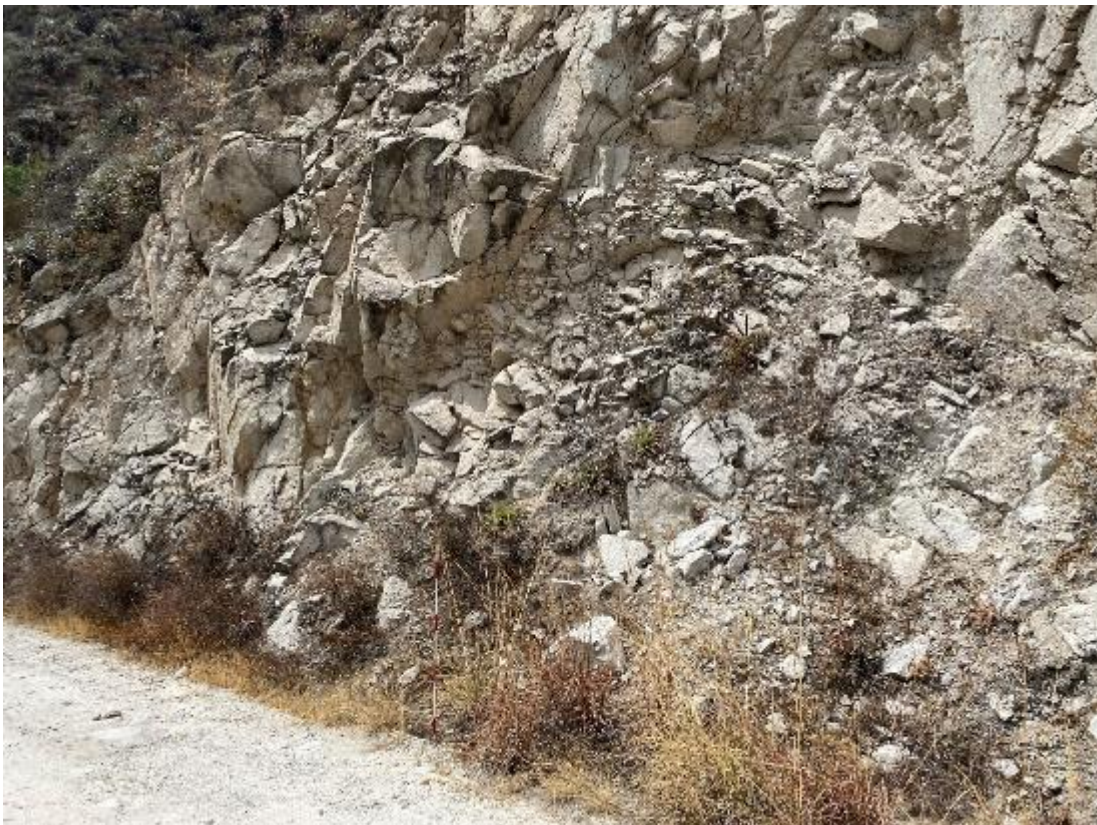
Fotografía 2. Tobas blanquecinas de la Fm. Yungay, ubicadas sobre los 2565 m s.n.m., altamente meteorizadas, las fracturas tienen una dirección principal S23E. Coordenadas referenciales: UTM WGS84 Zona 18S 192040 E, 8999856 N.
