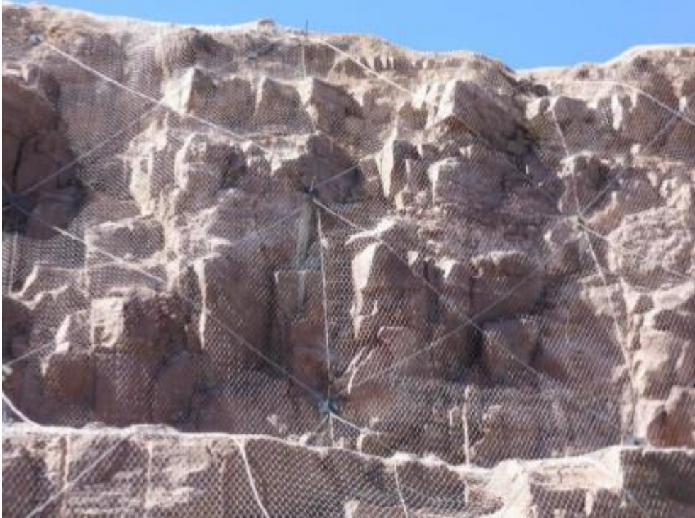
Figura 2. Control de caída de rocas utilizando mallas ancladas.
