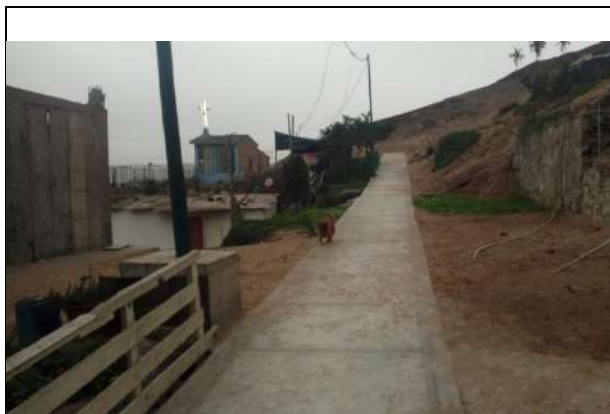
Foto N° 01 y N° 02: Vista de material constructivo de las veredas de concreto ciclópeo que sirve de conexión hacia las viviendas
