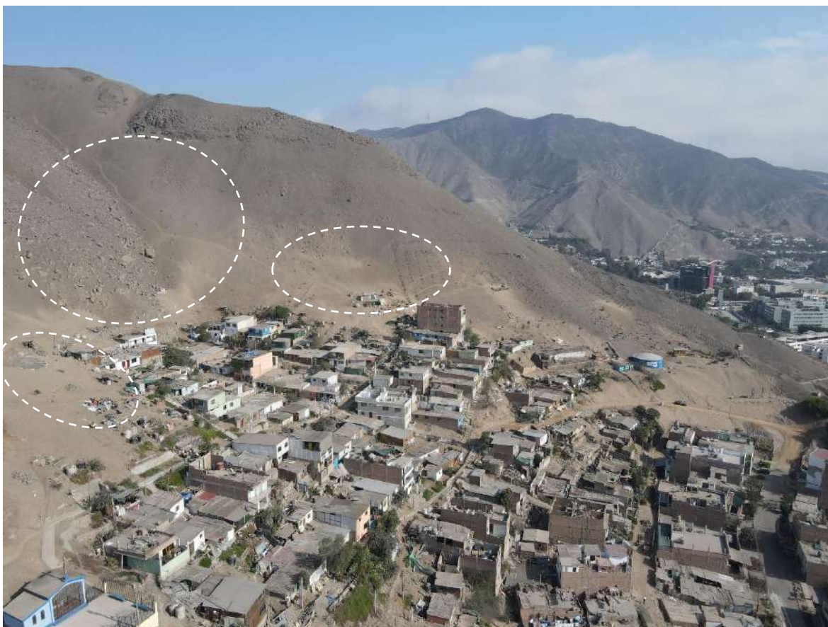
Figura N° 1: Vista panorámica del AAHH Diente de Oro
