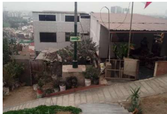
Foto N° 01 y N° 02: Vista de material constructivo de las veredas de concreto ciclópeo que sirve de conexión hacia las viviendas
