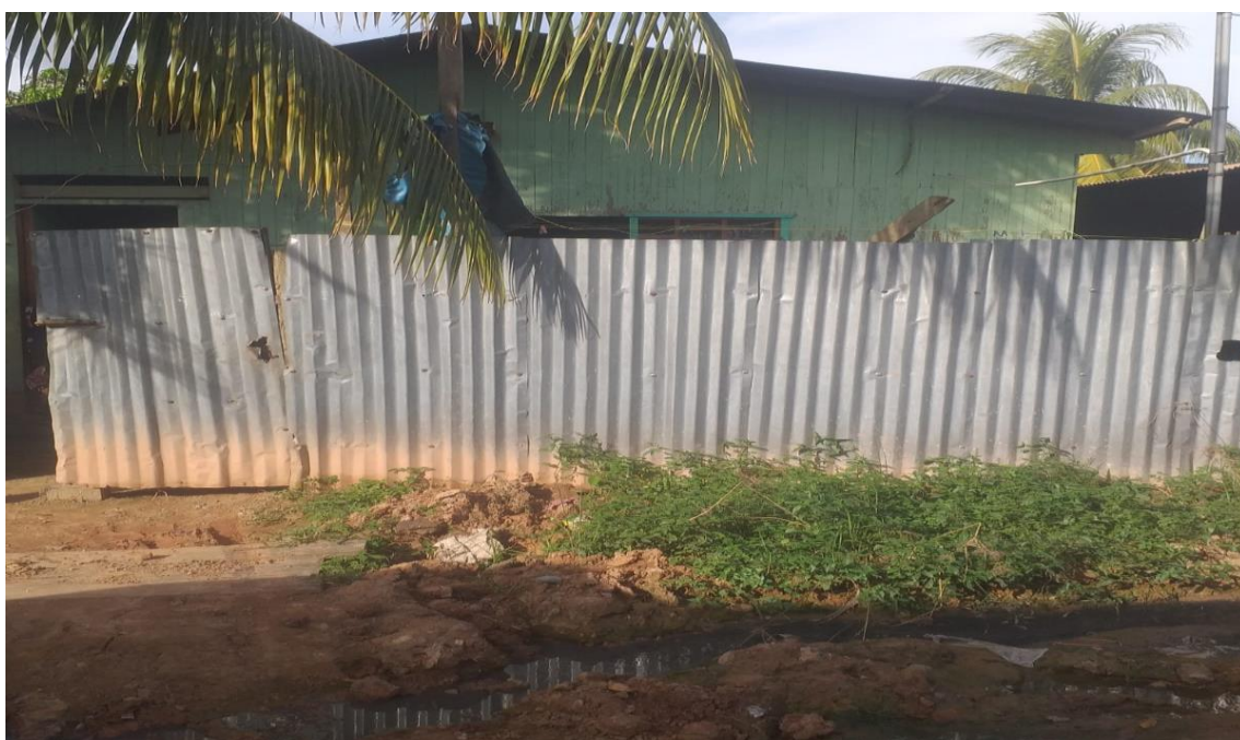
Foto N° 28: casa de un piso con techo de calamina, paredes de madera y cercado de calamina.
