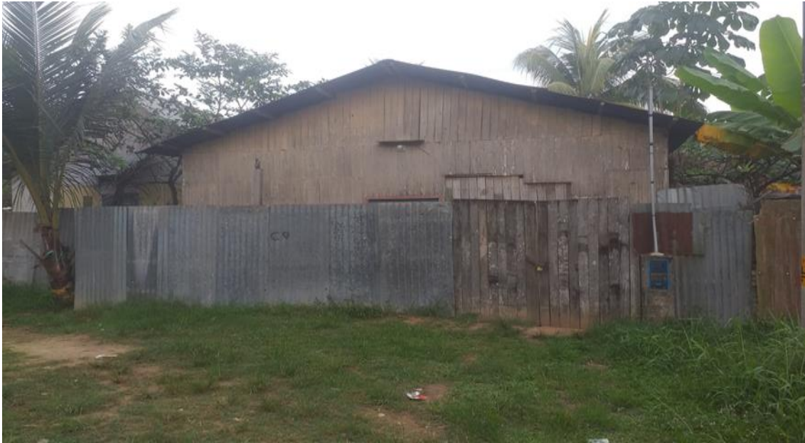
Foto N°13: casa de un piso con techo de calamina, paredes de madera y cerco de calamina.
