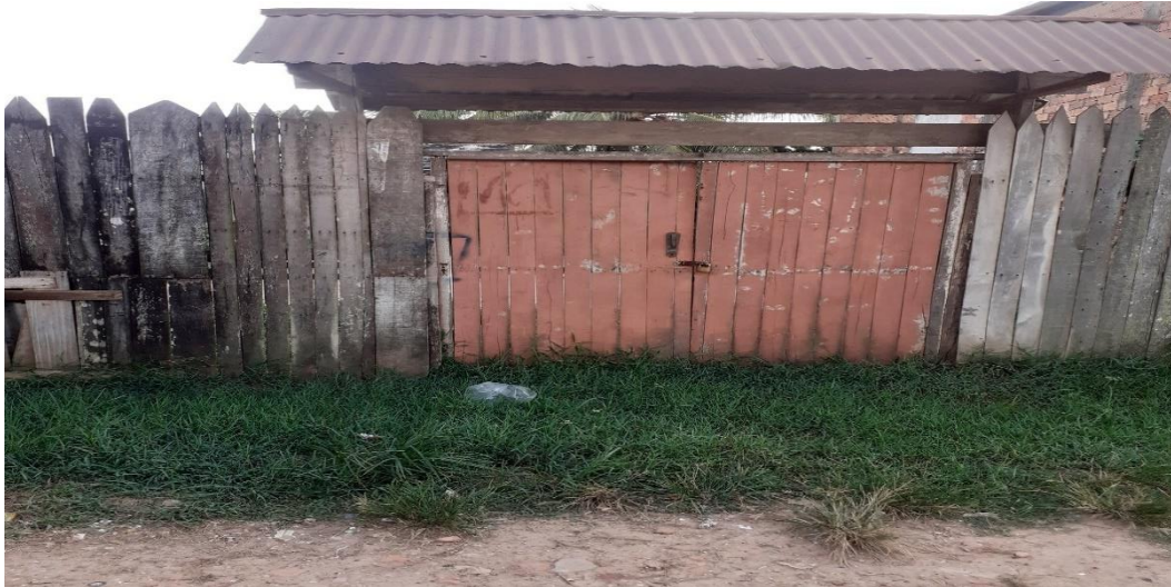
Foto N° 6: casa de un piso con techo de calamina y paredes de madera.
