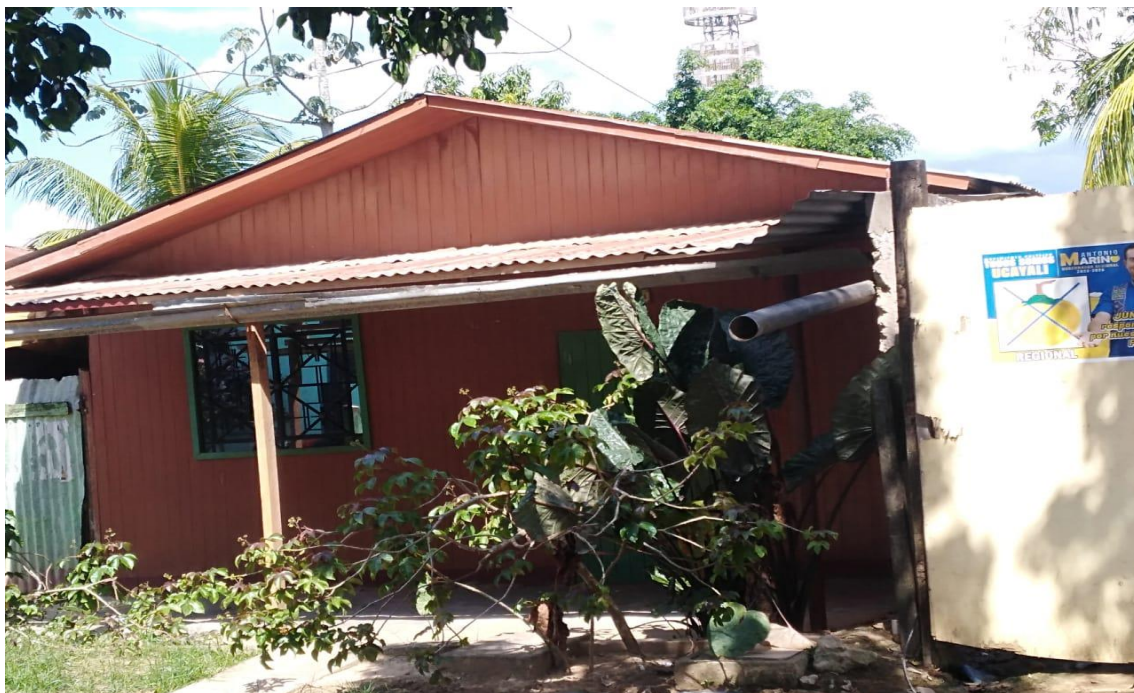
Foto N° 29: casa de un piso con techo de calamina y paredes de madera.
