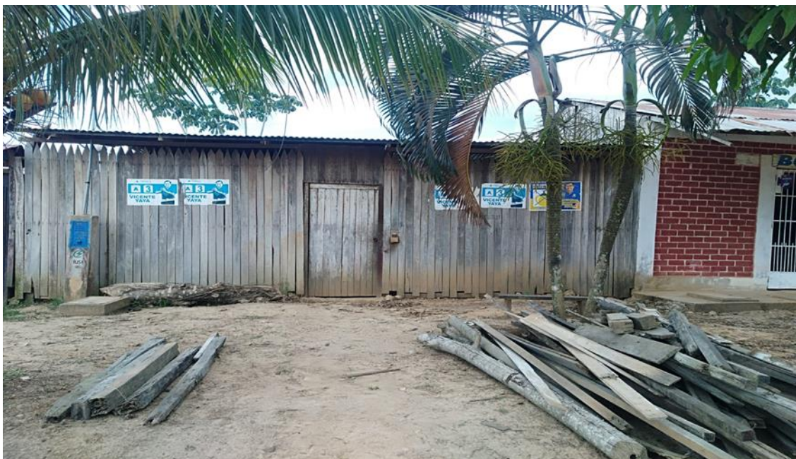
Foto N° 35: casa de un piso con techo de calamina y paredes de madera.
