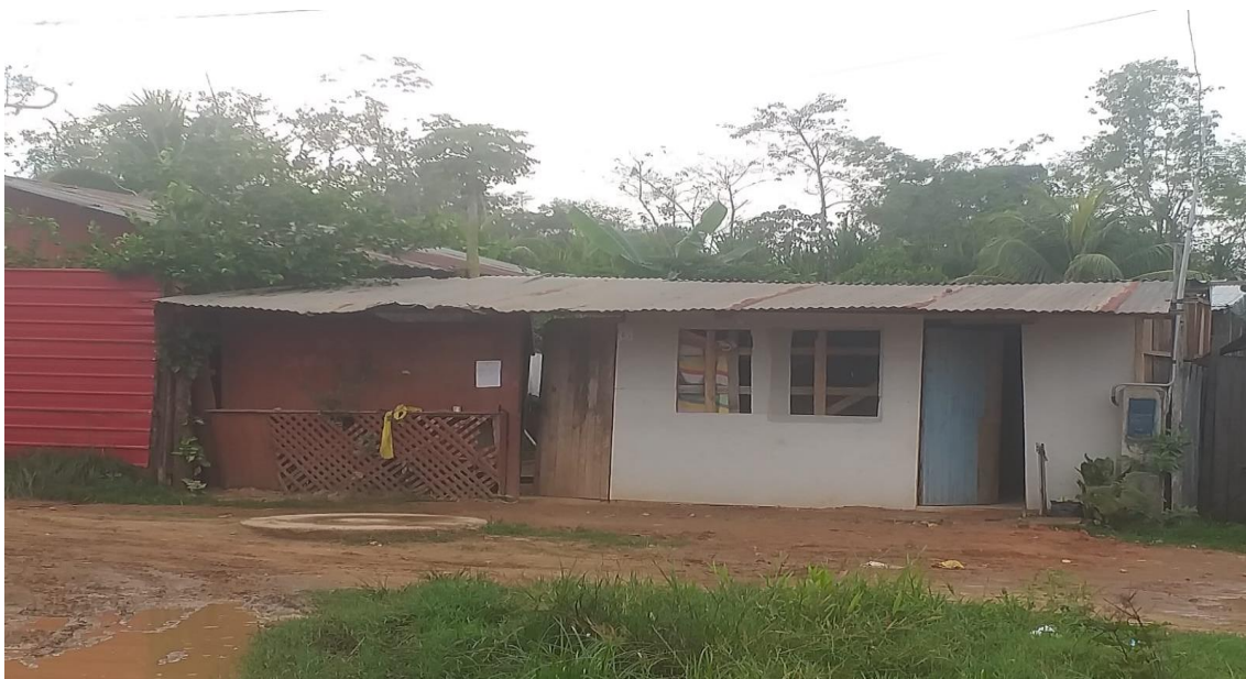
Foto N° 14: casa de un piso con techo de calamina y paredes de madera.
