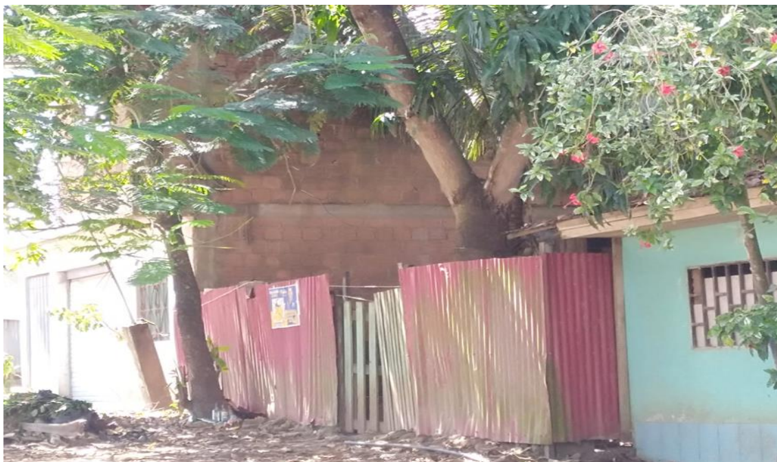
Foto N° 31: cerco de calamina con puerta de madera.
