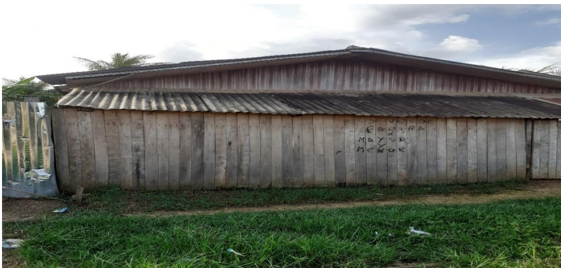
Foto N° 8: casa de un piso con techo de calamina y paredes de madera.
