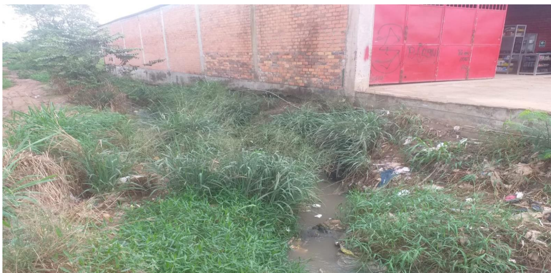
Foto N° 19: casa de material noble de un piso con potron de madera al lado del desagüe.
