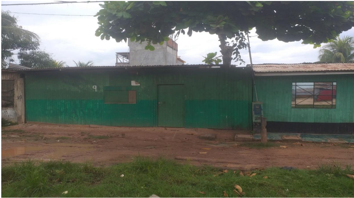
Foto N° 21: casa de un piso con techo de calamina y paredes de madera.
