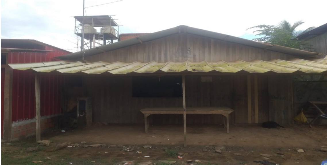
Foto N° 17: casa de un piso con techo de calamina y paredes de madera.
