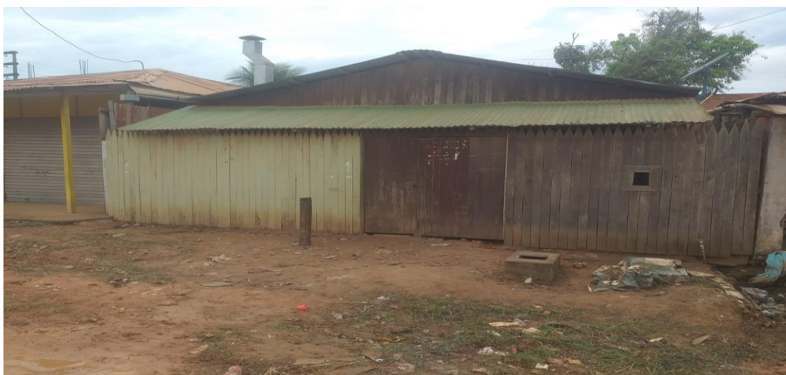
Foto N° 20: casa de un piso con techo de calamina y paredes de madera.
