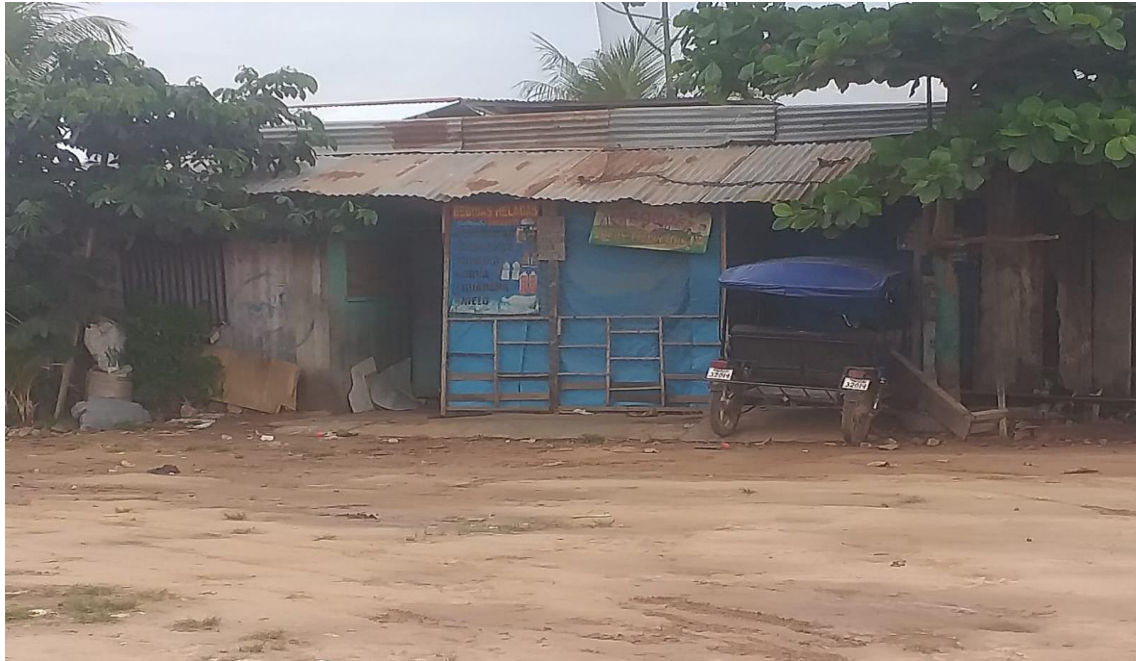
Foto N° 25: casa de un piso con techo de calamina y paredes de madera.
