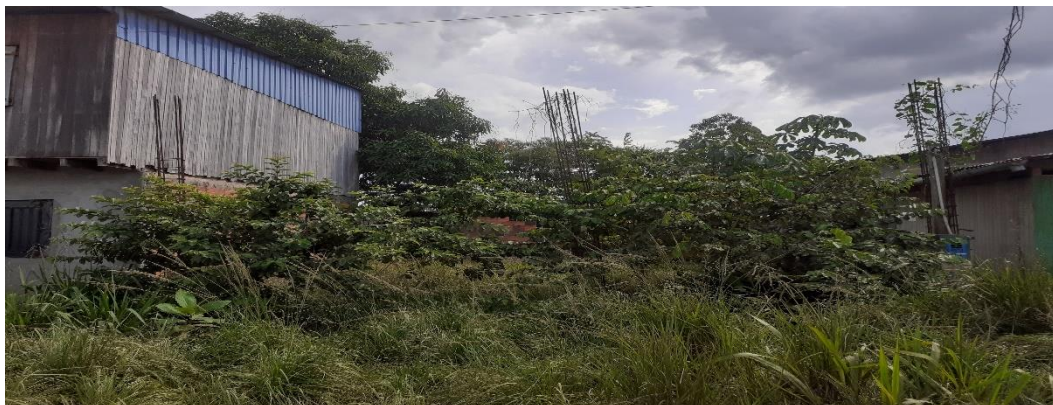
Foto N° 5: Casa abandonada de paredes de madera y cerco de calamina.
