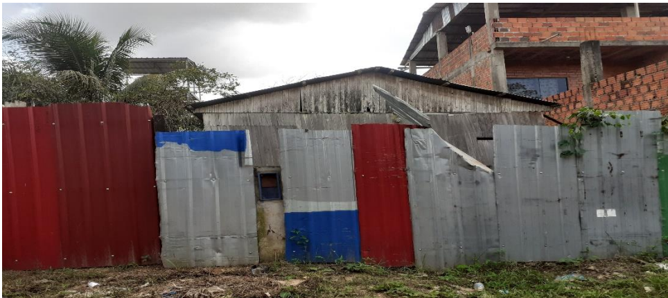
Foto N° 2: casa de un piso con techo de calamina y paredes de madera.
