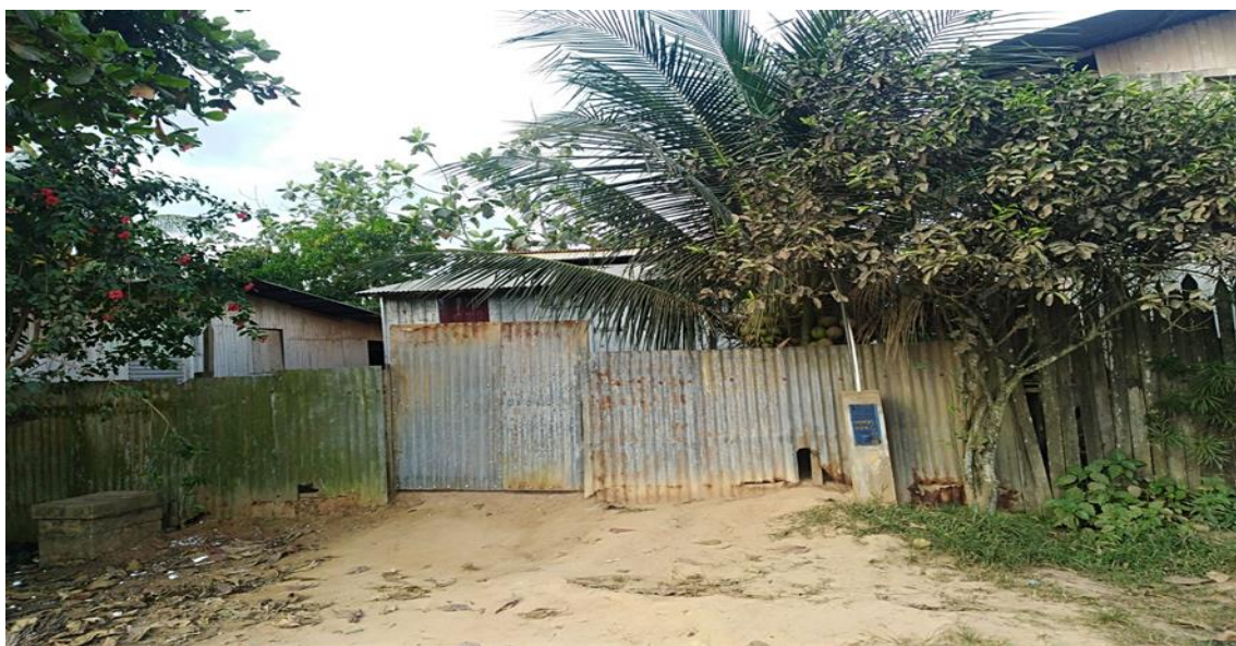
Foto N° 40: casa de un piso con techo de calamina, paredes de madera y cerco de calamina.
