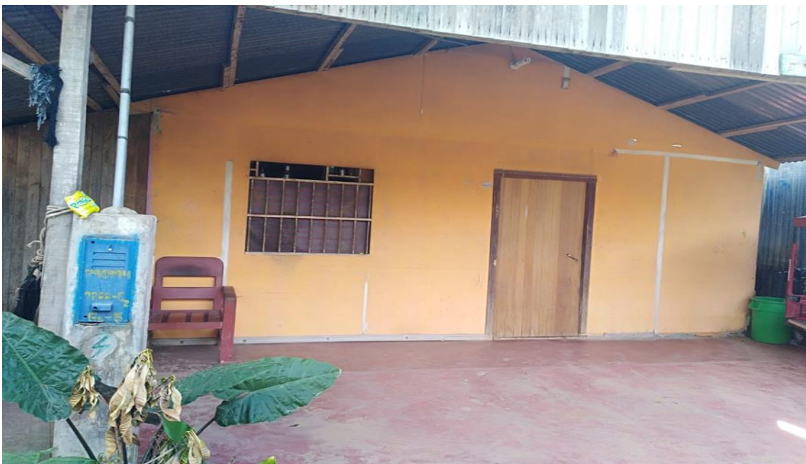
Foto N° 38: casa de un piso con techo de calamina y paredes de madera.
