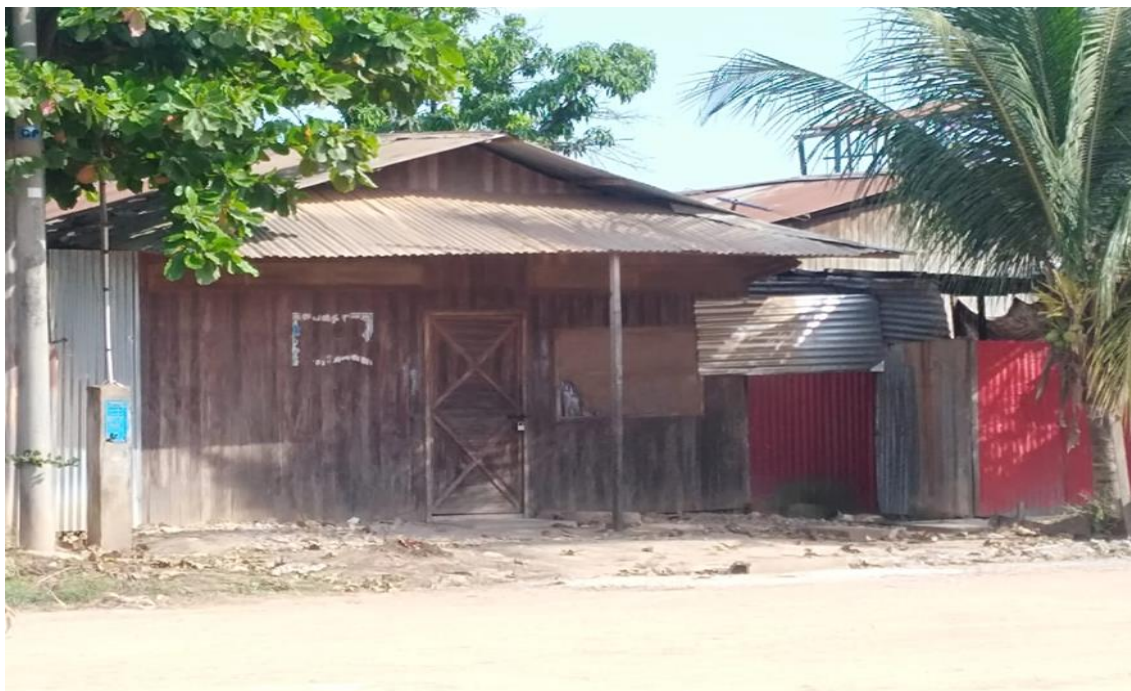
Foto N° 41: casa de un piso con techo de calamina y paredes de madera
