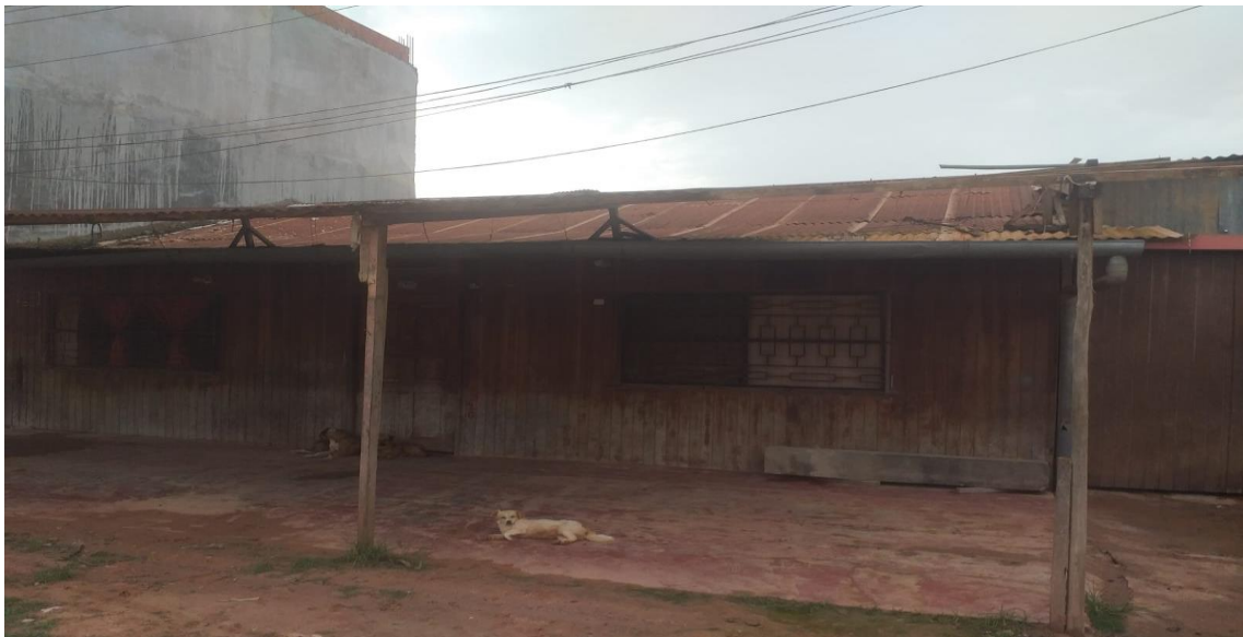
Foto N° 18: casa de un piso con techo de calamina y paredes de madera.
