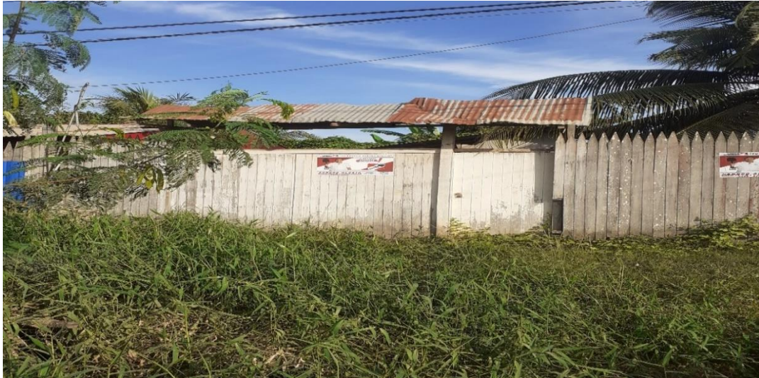
Foto N° 9: casa de un piso con techo de calamina y paredes de madera.
