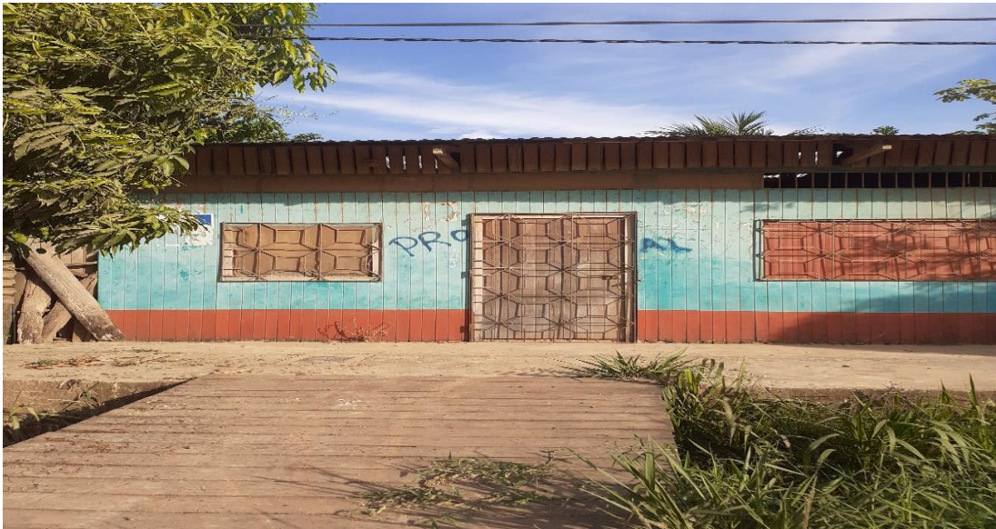
Foto N° 10: casa de un piso con techo de calamina y paredes de madera.
