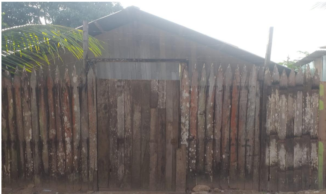
Foto N° 27: casa de un piso con techo de calamina y paredes de madera.
