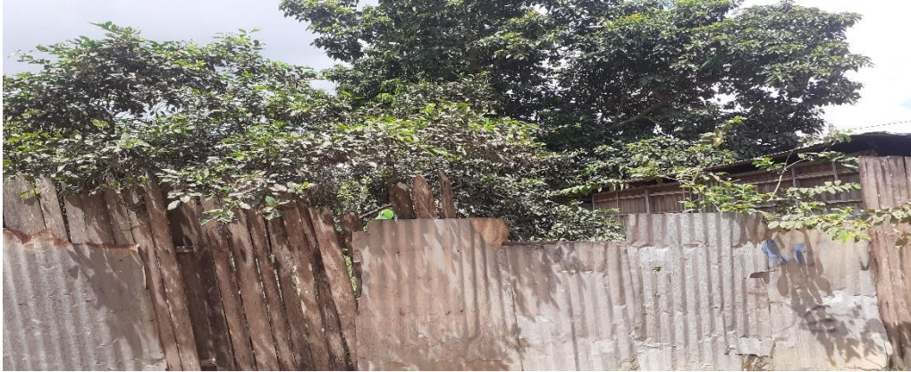
Foto N° 3: Casa abandonada de paredes de madera y cerco de calamina.
