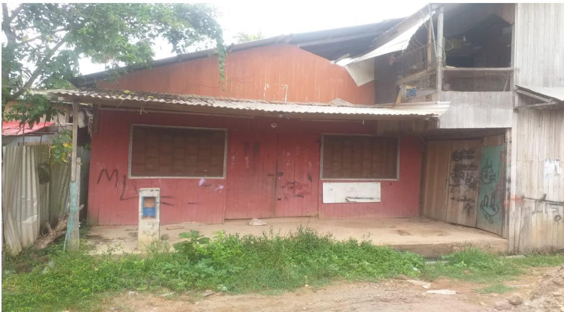
Foto N° 24: casa de un piso con techo de calamina y paredes de madera.
