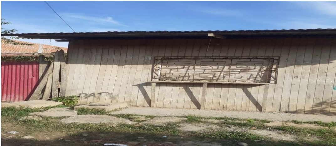
Foto N° 7: casa de un piso con techo de calamina y paredes de madera.
