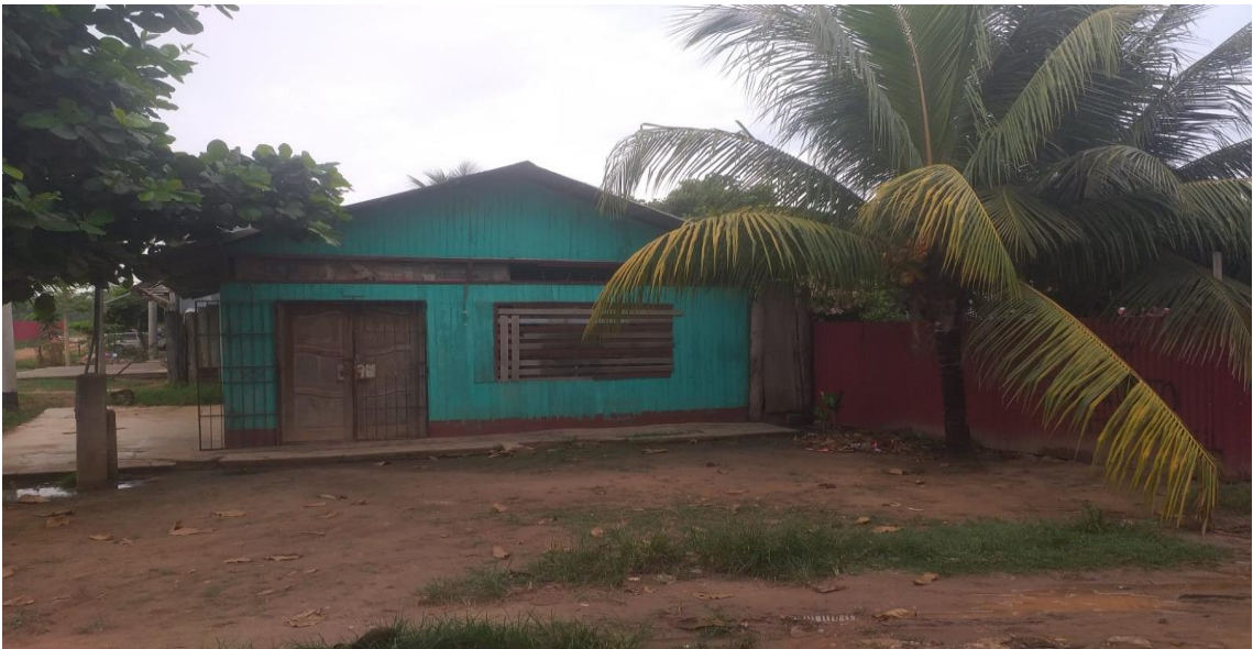
Foto N° 16: casa de un piso con techo de calamina y paredes de madera.
