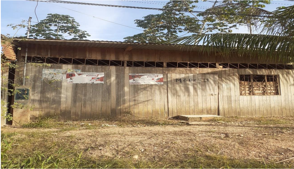
Foto N° 11: casa de un piso con techo de calamina y paredes de madera.
