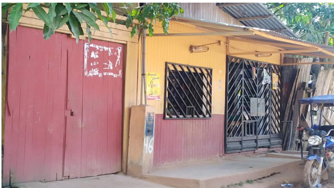
Foto N° 32: casa de un piso con techo de calamina y paredes de madera.
