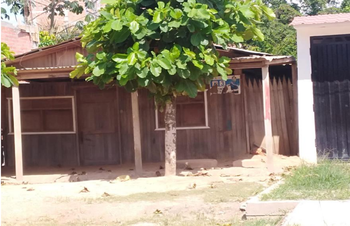
Foto N° 33: casa de un piso con techo de calamina y paredes de madera.
