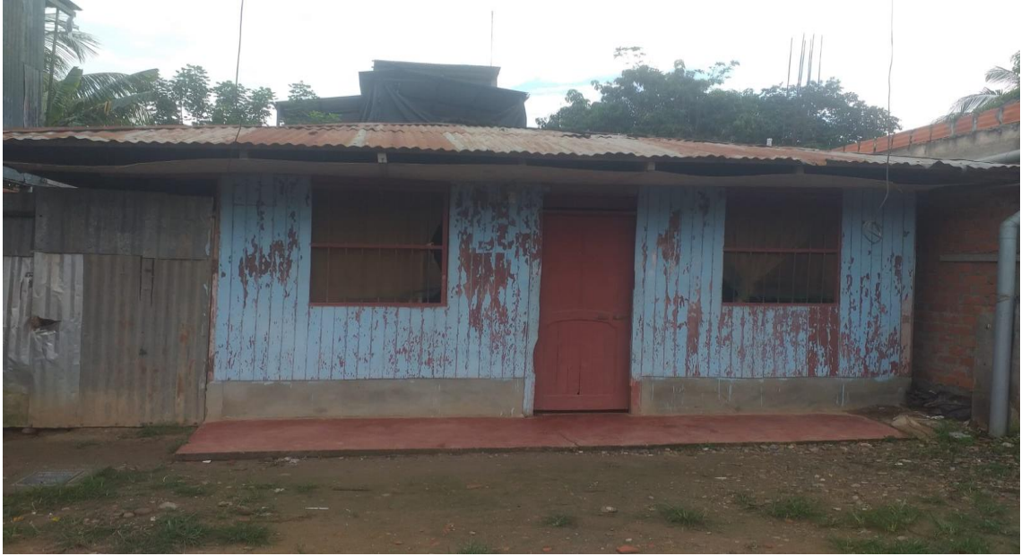
Foto N° 15: casa de un piso con techo de calamina y paredes de madera.
