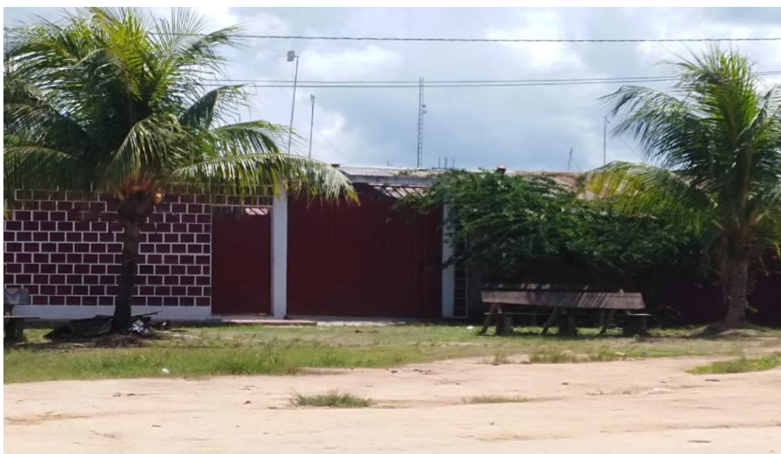
Foto N° 30: casa de material noble con portón de calamina.
