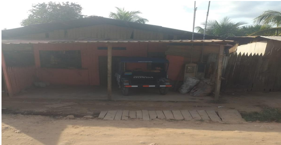
Foto N° 22: casa de un piso con techo de calamina y paredes de madera.
