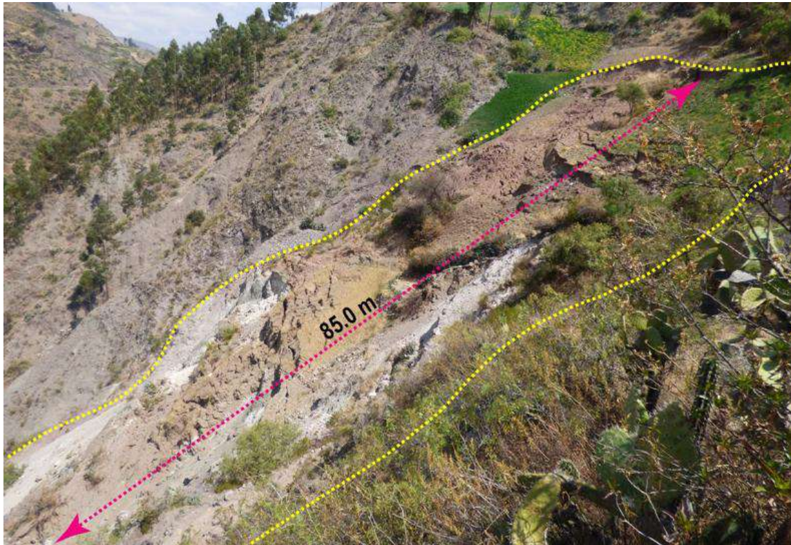
Figura 16. La masa deslizada presenta una longitud de 85 m, la cual se moviliza sobre una superficie de falla rotacional, con dirección preferente de este a sureste.
