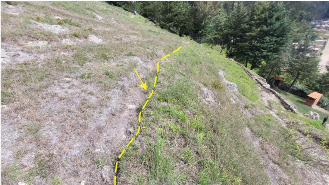
Figura 10. Agrietamientos (líneas amarillas discontinuas), con longitudes de 1m a 5 m, ubicados en la parte superior del macizo rocoso.
