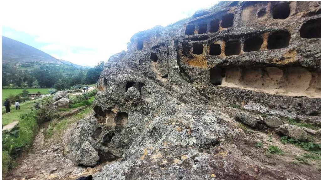
Fotografía 9. Detalle de la zona del Perfil E-E', donde se aprecian nichos funerarios colapsados debido a la meteorización y erosión misma del talud, por procesos pluviales y eólicos.
