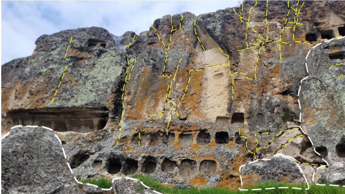
Figura 15. Delimitada con líneas blancas discontinuas se muestra los bloques caídos y con líneas amarillas discontinuas las fracturas en el macizo rocoso. Se ubica en el lado derecho del frontis de las Ventanillas de Otuzco.
