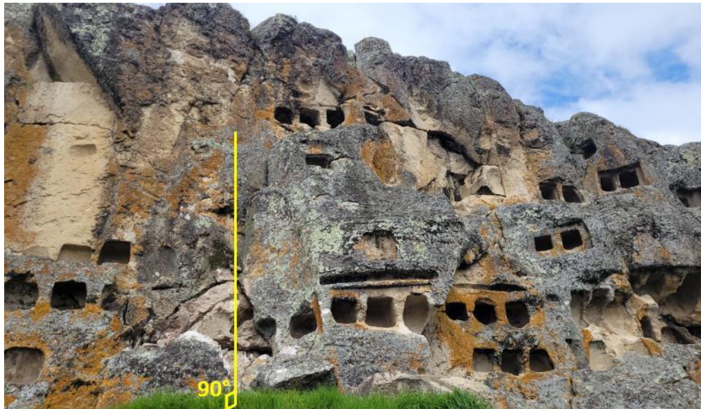
Figura 22. Los nichos funerarios están contruidos sobre un macizo rocoso con una pendiente < 45^\circ , en donde se origina la caída de rocas.
