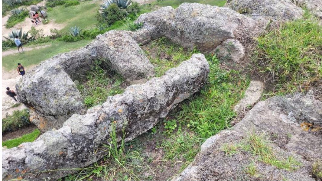
Fotografía 7. En las depresiones originadas por los nichos deteriorados, se observa el crecimiento de abundante vegetación, donde se produce anegamiento de agua cuando llueve.
