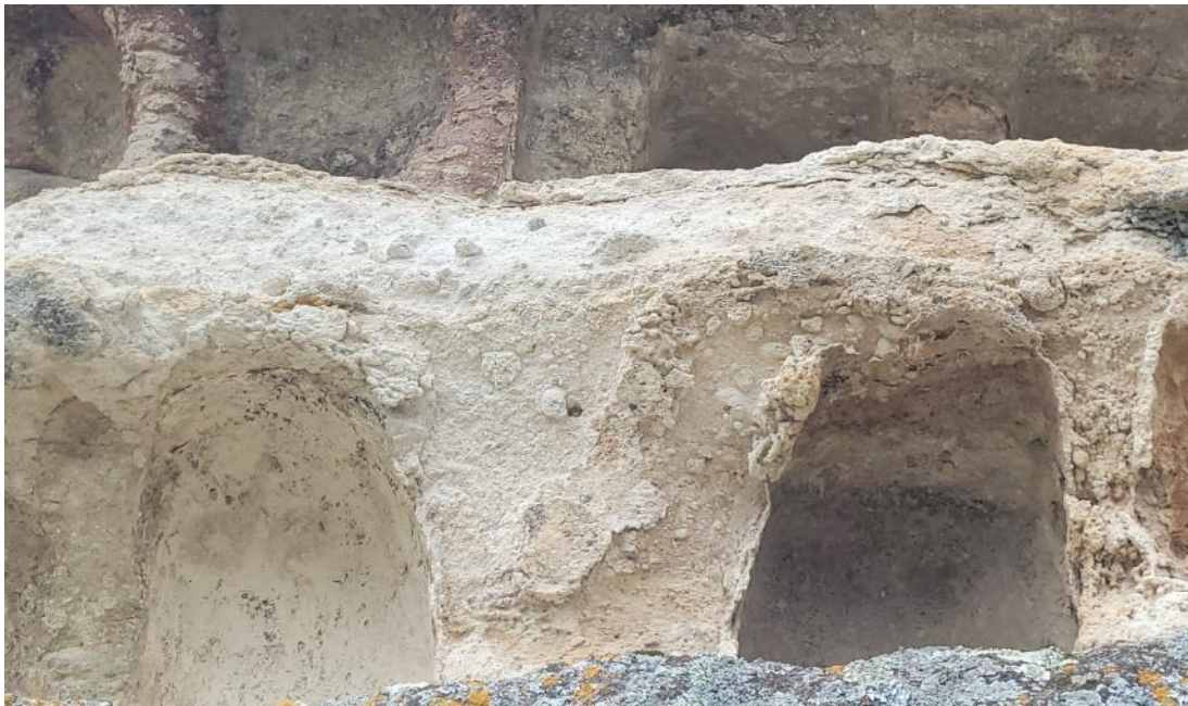
Fotografía 6. Nichos fúnebres, deteriorados por la erosión pluvial y eólica, del macizo rocoso.
