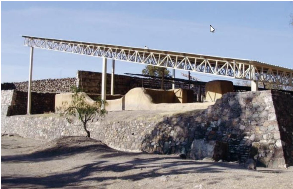
Figura A2. Ejemplo de monumento arqueológico, protegido por una cubierta, sobre una estructura metálica.
