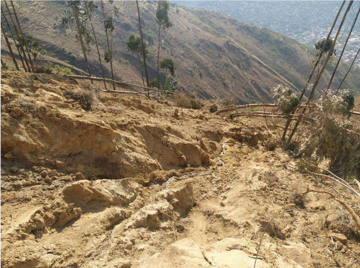
Fotografía 1 Obsérvese una corriente de agua en el cuerpo del deslizamiento de Quispata Baja.
