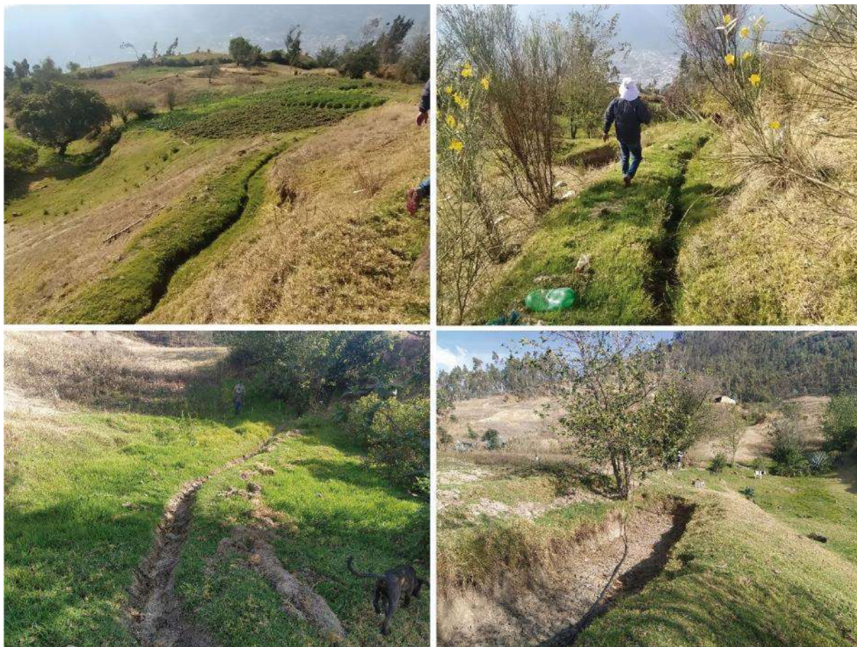
Figura 16. Canales de agua no revestidos, ubicados en el sector de Quisipata Baja, inmediatamente superior al área de deslizamiento.
