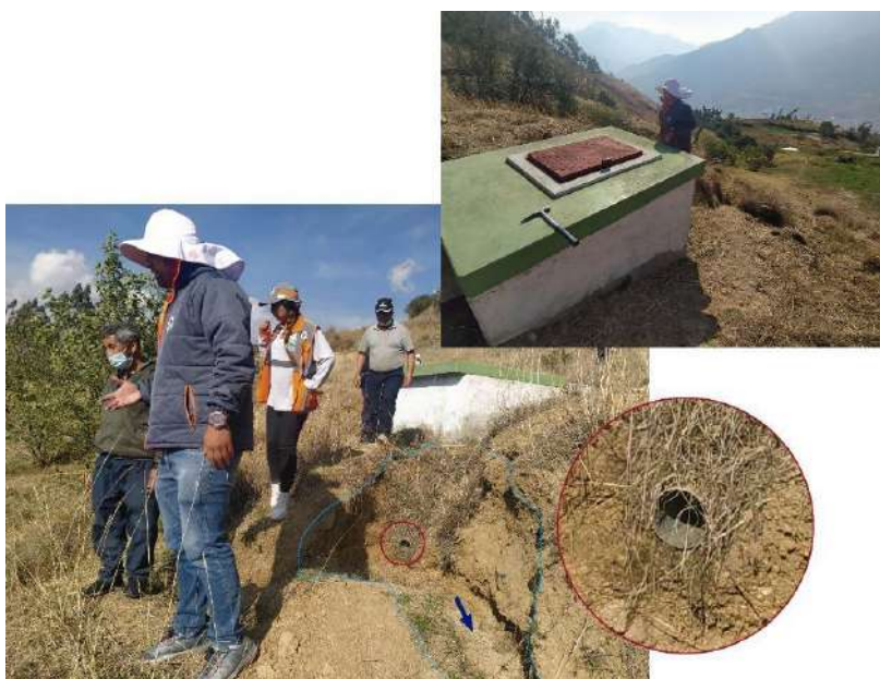
Figura 14. Captación de agua y rebalse de este.
