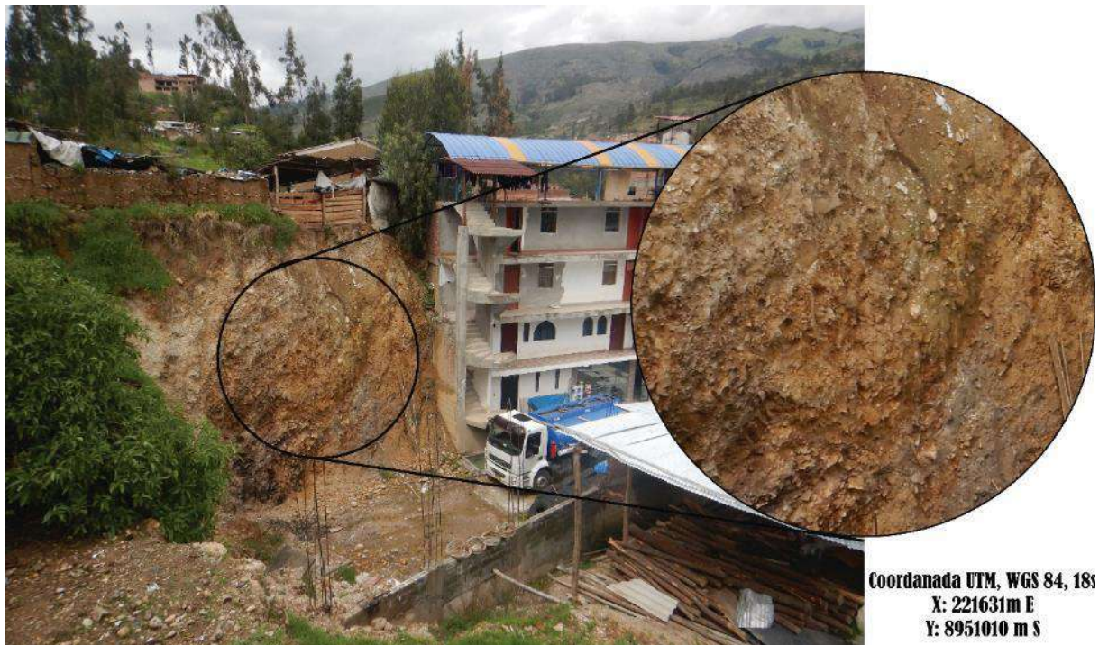
Figura 10. Suelos residuales, producto de la meteorización y fracturamiento de las rocas (areniscas cuarzosas) de la Formación Chimú.
