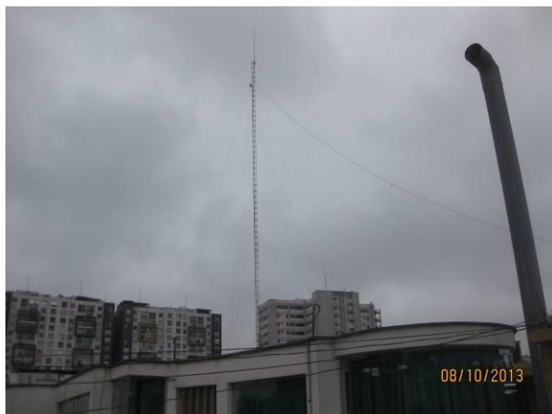
13. Antena de comunicaciones en regular estado
