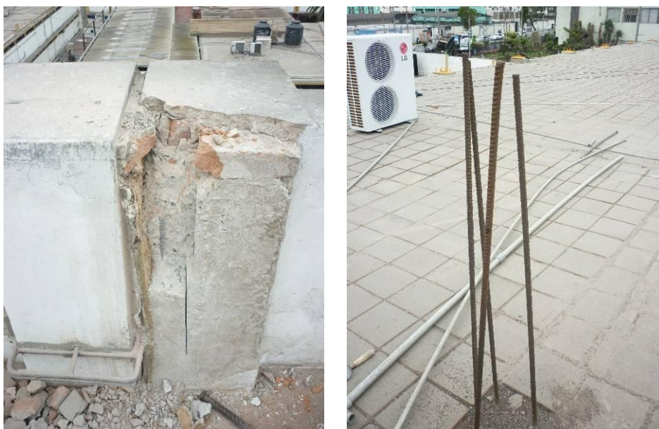
Foto 25. Puntos de extracción de muestras de acero
