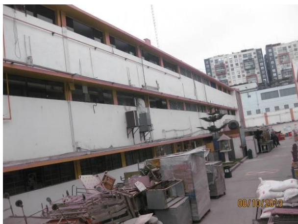
16. Materiales en desuso en el pasadizo de acceso al grupo electrógeno
