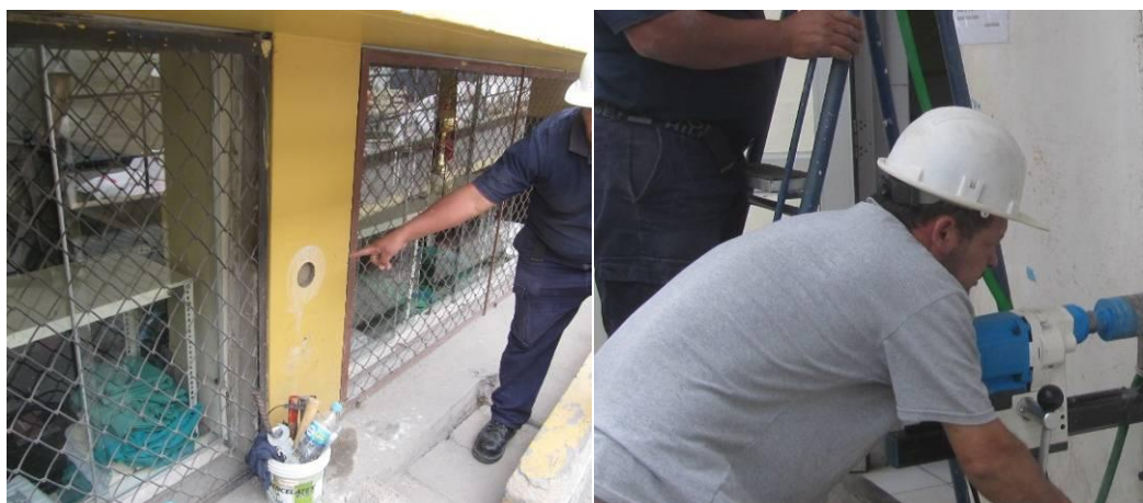
Foto 24. Extracción de núcleos de concreto
