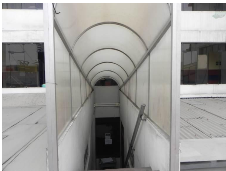
Foto 21. Escalera de acceso a la azotea de Pabellón D, en donde se ubican varios ambientes, entre ellos el COE.
