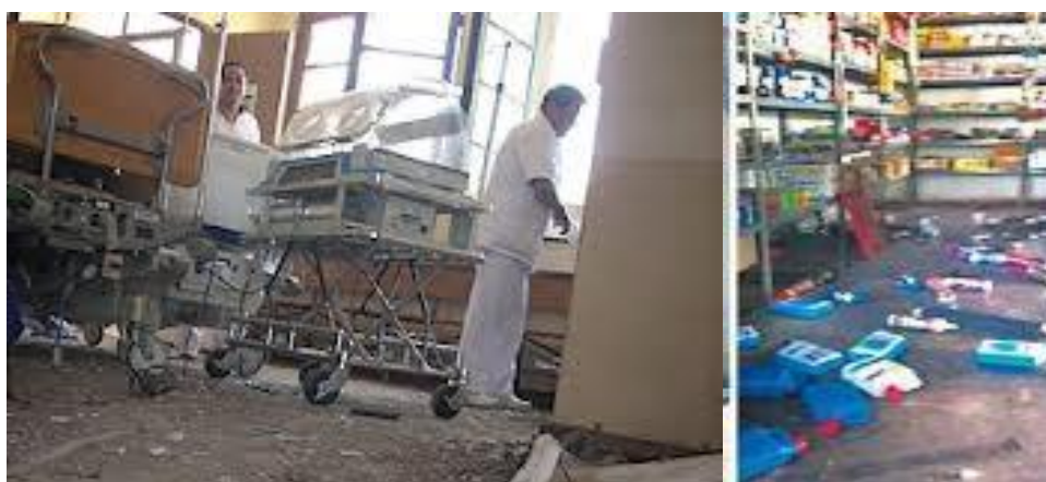
Figura 6. Desplazamiento de equipos que pueden ocasionar la inoperatividad de los mismos.
