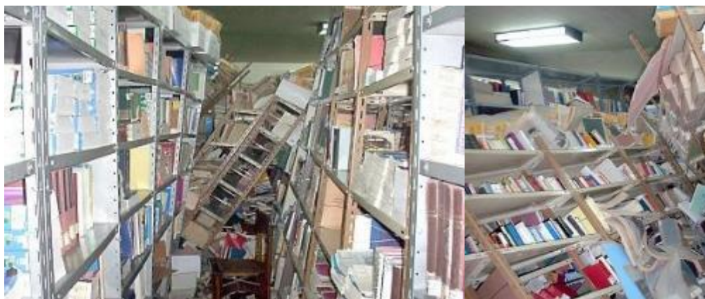
Figura 7. Caída y volcamientos de estanterías que no están adecuadamente sujetos.
