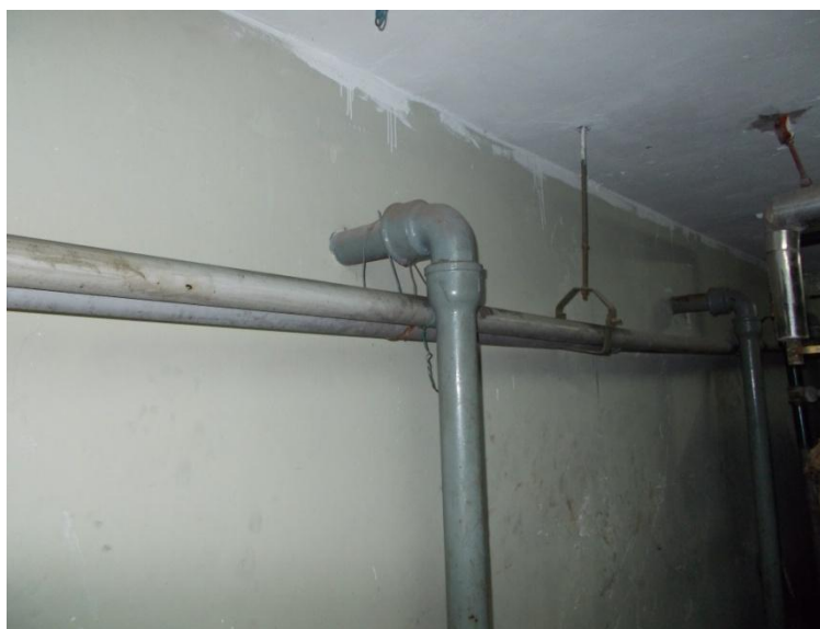
Figura 74. Empalme rígido en cisterna.
