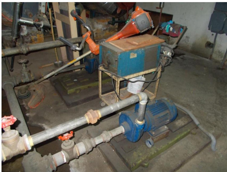
Figura 75. Árbol de descarga sin uniones flexibles.
