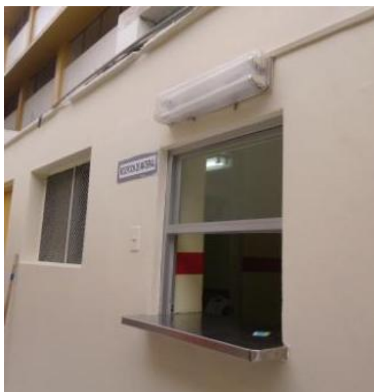
Foto 36: Izquierda: En el pabellón A en la parte exterior de la Central de Esterilización se tienen luminarias que no cuentan con elementos de
