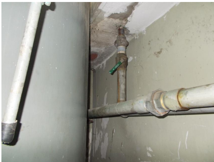
Figura 77. Empalmes rígidos de tuberías a muros.
