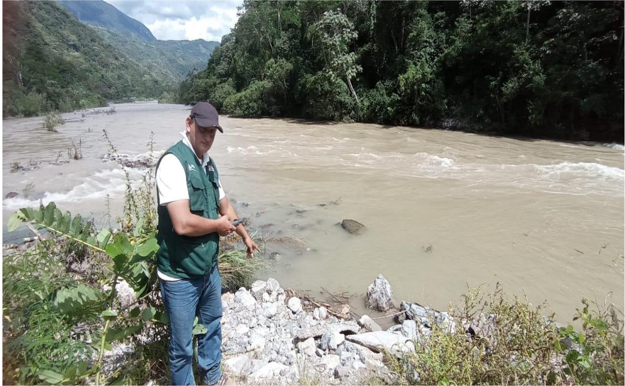
FIGURA N°02: TRAMO CRÍTICO EN EL RIO HUALLAGA, SE OBSERVA LA EROSION DEL TALUD DE LA MARGEN DERECHA
