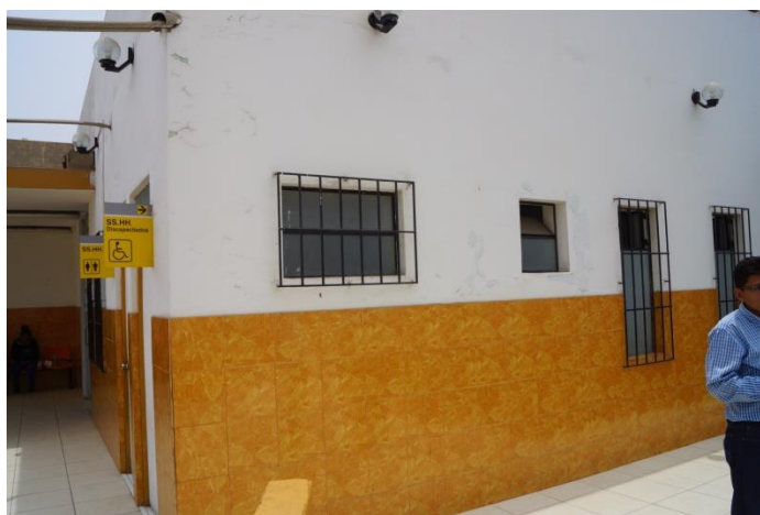
Foto 1. Detalle del Edificio del Servicio de Emergencia
