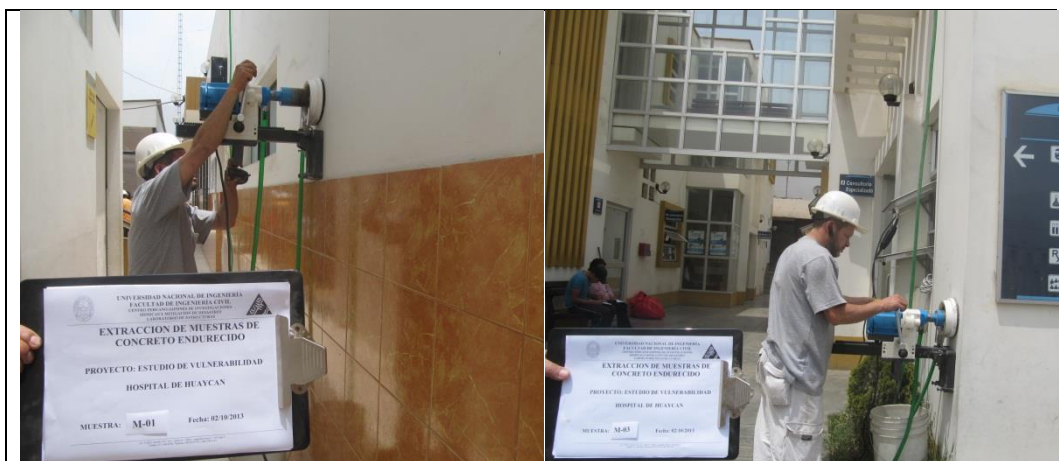
Foto EE1. Extracción de núcleos de concreto
