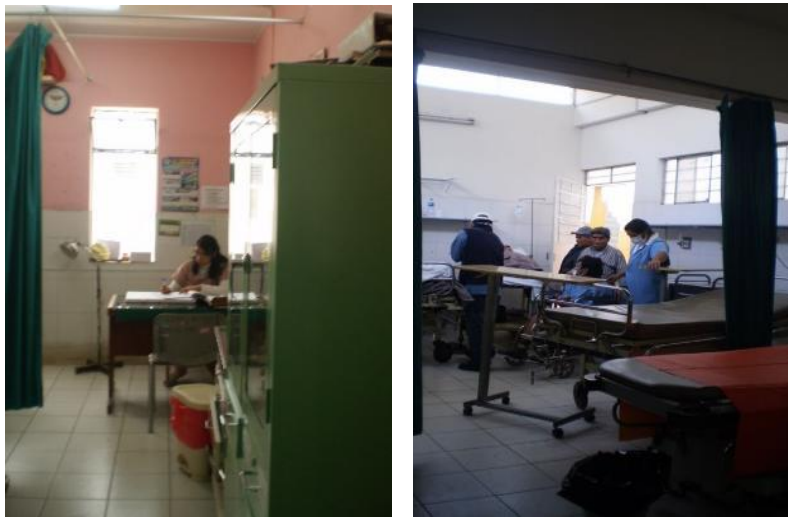
Fotos 32 y 33. Condición y seguridad del equipo médico en el servicio de Emergencia, obstruye rutas de evacuación, existe riesgo de volcamiento de armario.
