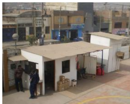
Foto 7. Techos ligeros que deben estar sujetos adecuadamente a fin evitar caídas o desprendimientos
