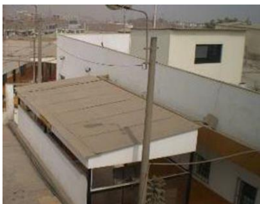
Foto 7. Techos ligeros que deben estar sujetos adecuadamente a fin evitar caídas o desprendimientos
