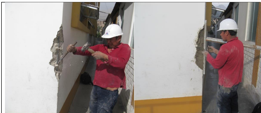
Foto EE2. Extracción de muestras de acero y resane del concreto
