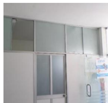
Fotos 44, 45 y 46. Condición y seguridad de particiones o divisiones internas. Sujeción inadecuada
