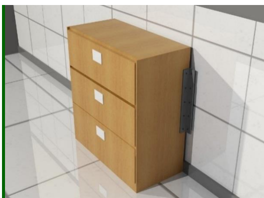
Figura 16. Archiveros deben estar asegurados y evitar caídas que obstruyan salidas o corredores de evacuación. .
