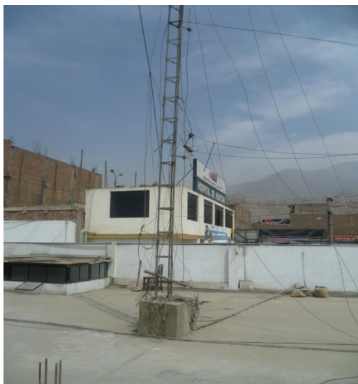
Foto 28. Antena requieren mantenimiento y limpieza a su alrededor
