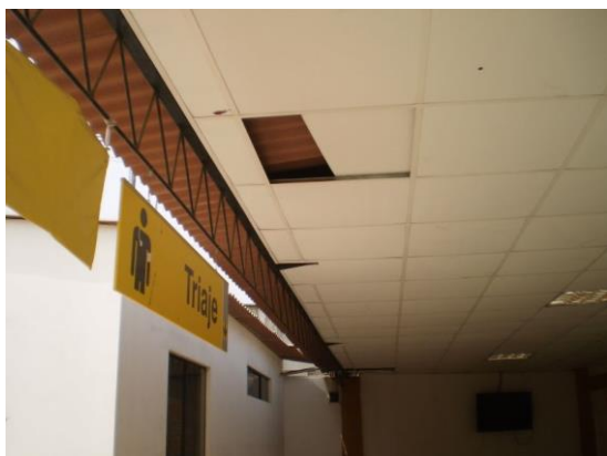
Foto 58. Existen ambientes con falso cielo raso. Algunos de estos se encuentran pandeados por la humedad o falta de mantenimiento.
