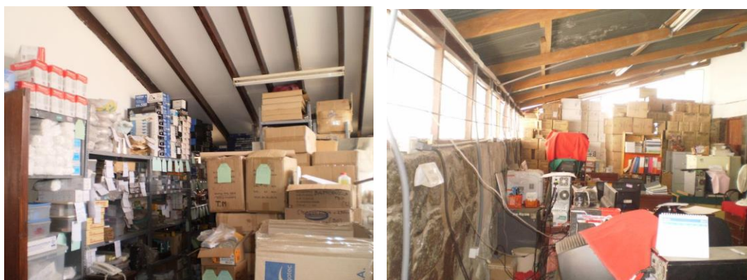
Foto 54. En el interior de los almacenes las estanterías no se encuentran fijadas a la pared, piso o techo, por lo que tienden al volcamiento de los elementos médicos en casos eventuales (Bloque E). Otro factor, es el desplazamiento de los contenidos por no estar asegurados y puestos uno encima de otros de forma insegura. Se aprecia sobrecarga adicional de objetos o cargas que sobrepasan a la capacidad máxima del elemento. Así como. Circulación mínima de recorrido
