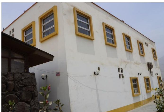
Foto 4. Detalle de las edificaciones de dos pisos del hospital
