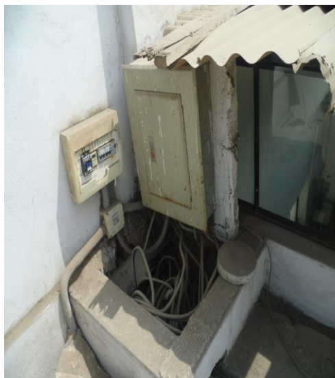
Foto 29. Cambio de llaves de corte no adecuadas y asegurar instalaciones
