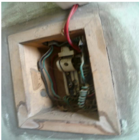
Foto 29. Cambio de llaves de corte no adecuadas y asegurar instalaciones
