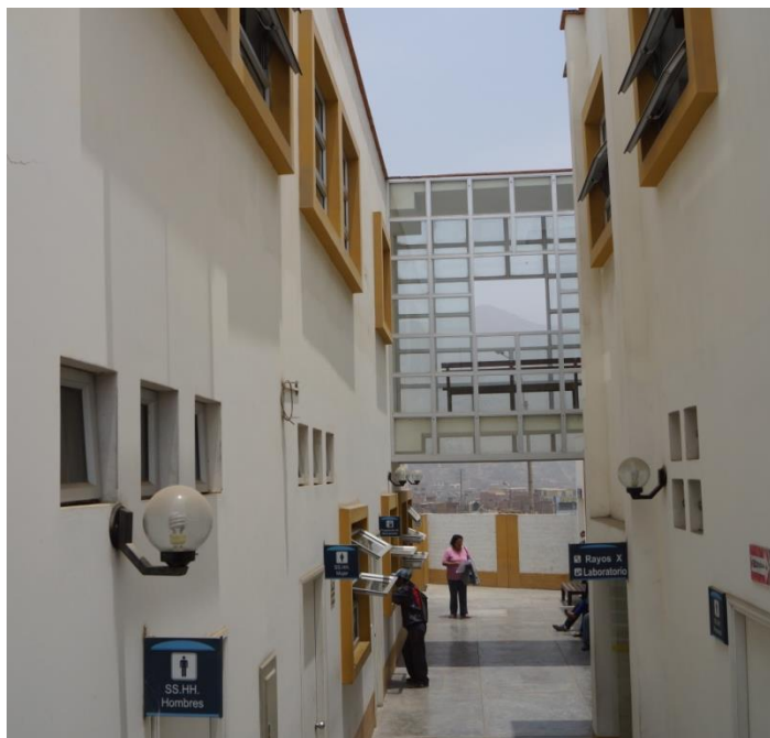
Foto 3. Puente existente en Centro de Excelencia TB
