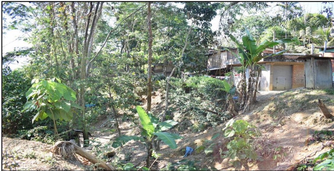
FIGURA N°01: VISTA DE VIVIENDAS A ORILLAS DE LA QUEBRADA CANALHUAYCCO EN PELIGRO DE DESLIZAMIENTO.
