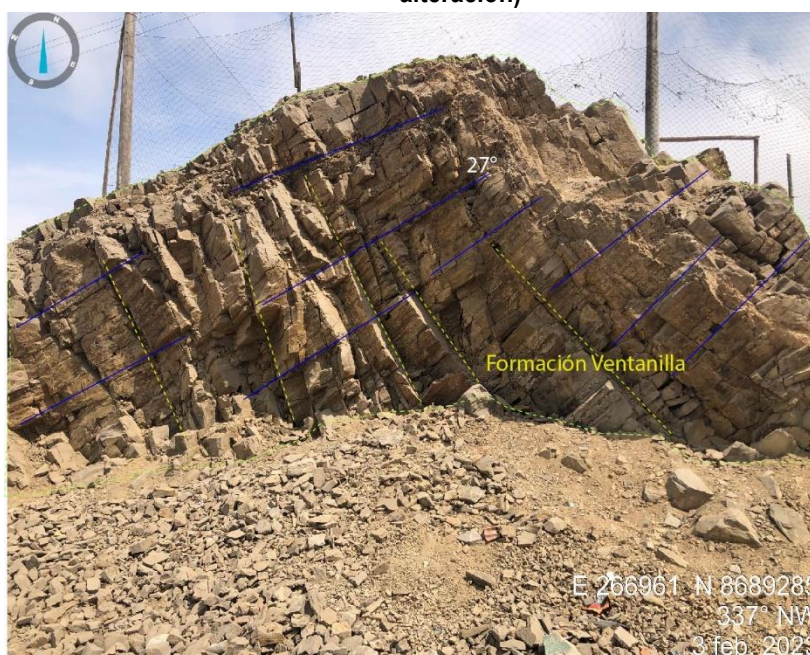
Figura N° 09. Afloramiento de la Formación Ventanilla (Arenisca con gran grado de alteración)
