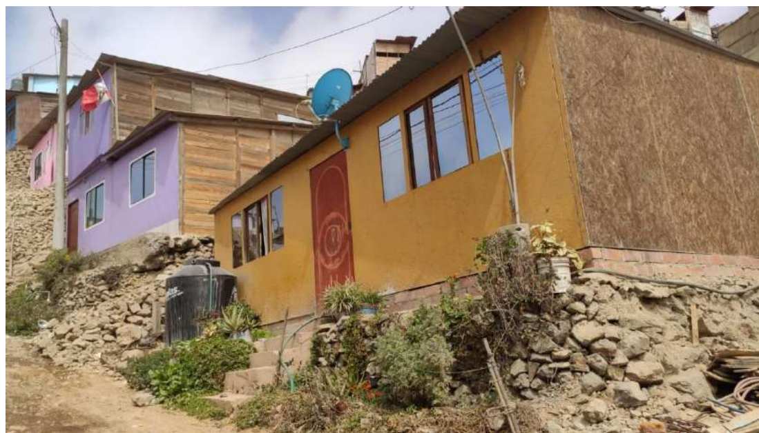
MANZANA H- LOTE 1 AA. HH RESIDENCIAL CRUZ DE MOTUPE - Construcción de madera con techo de calamina.
