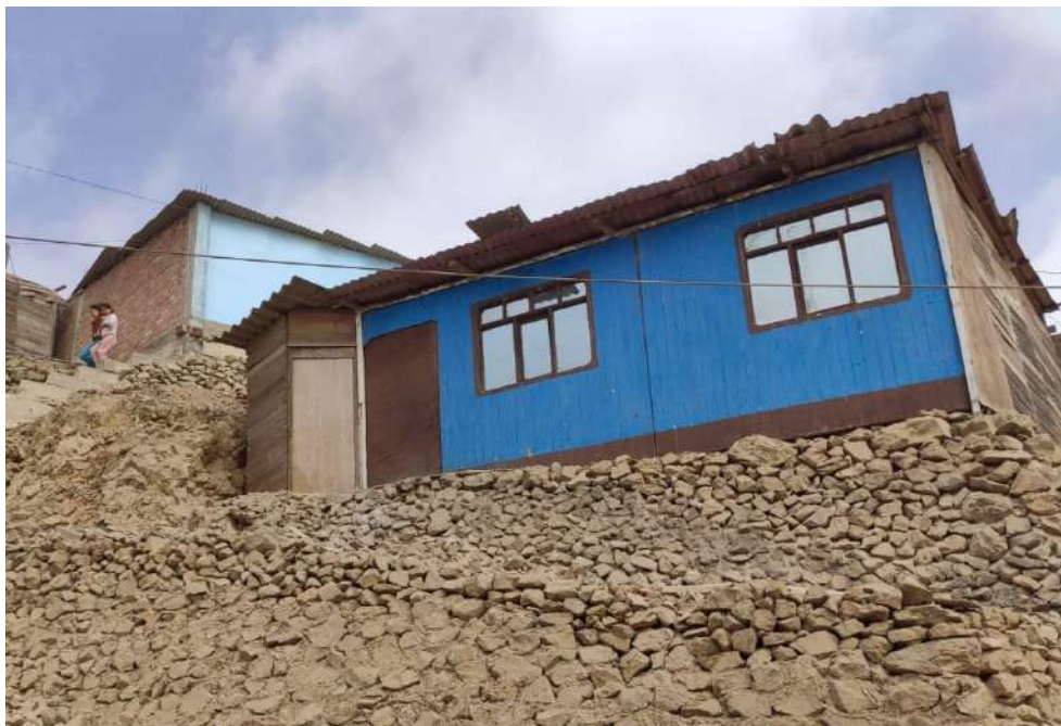
MANZANA H'- LOTE 1 AA. HH RESIDENCIAL CRUZ DE MOTUPE - Construcción de madera con techo de calamina.
