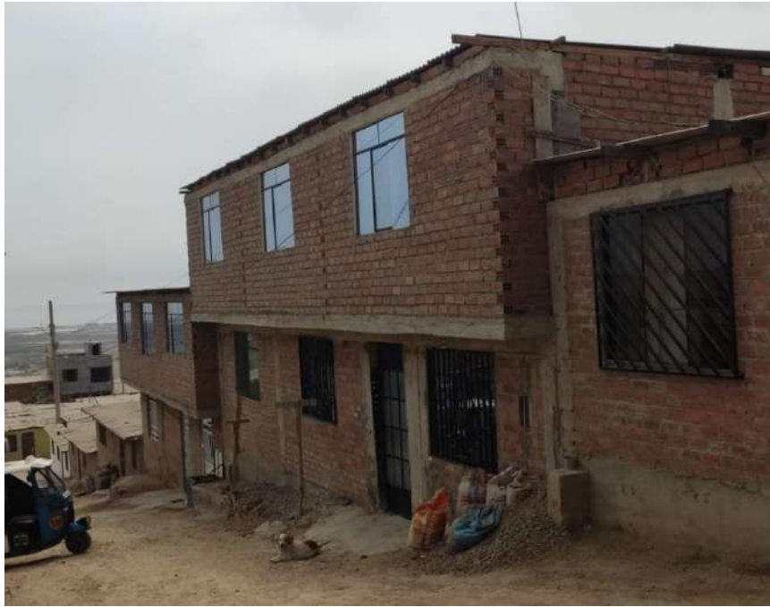
MANZANA L1- LOTE 2 AA. HH RESIDENCIAL CRUZ DE MOTUPE - Construcción de ladrillo con techo de losa aligerado.
