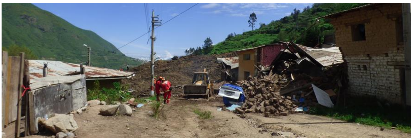
Fotografía 4. Se aprecia parte de los daños causados por la avalancha de detritos.
