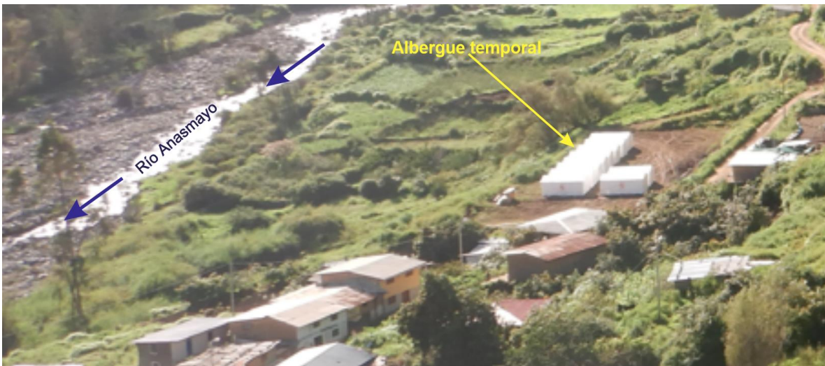
Figura 4: Se aprecia el albergue temporal, ubicado en la margen izquierda del río Anasmayo.
