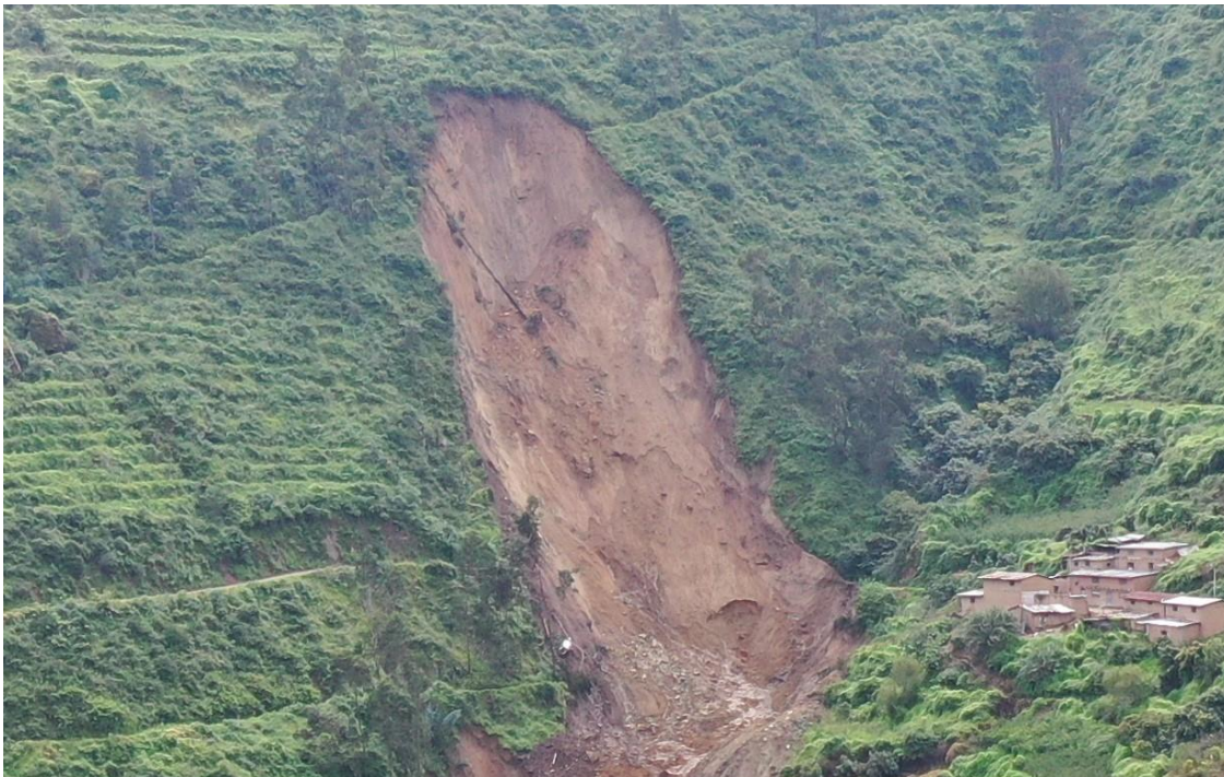
Fotografía 3. Vista del material colgado ubicado dentro de la zona de arranque de la avalancha de detritos.
