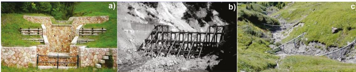
**Figura 33.** Presas de sedimentación escalonada para controlar la fuerza destructiva de los huaicos, tipo SABO (a); tipo rejilla (b); barras flexibles (c).
