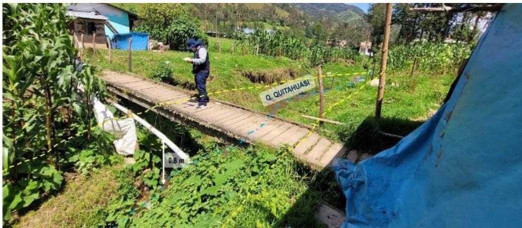
**Figura 10.** Puente peatonal susceptible a erosión fluvial, probable altura de inundación de 0.8 m.
