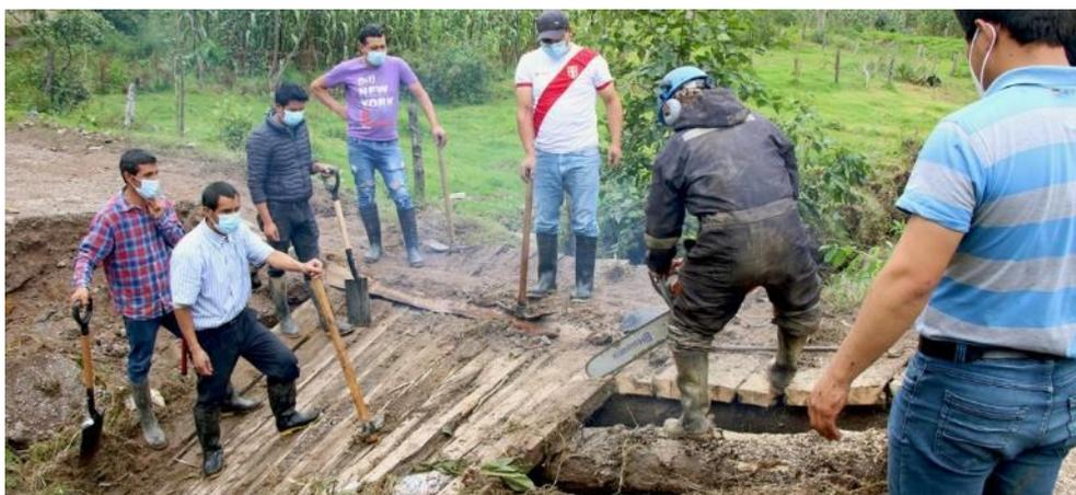
**Fotografía 3.** Trabajos de rehabilitación en un puente carrozable colapsado en la quebrada Quitahuasi, en abril del 2021. **Fuente:** Municipalidad Distrital de Tongod.
