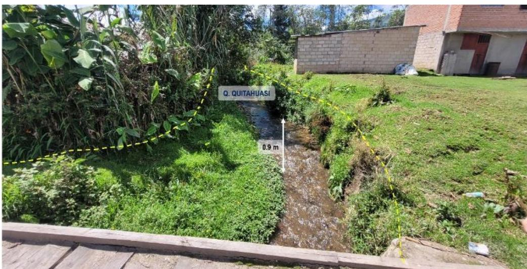
**Figura 15.** Puente carrozable susceptible a erosión por la quebrada Quitahuasi, probable altura de inundación de 0.9 m. **Ubicación:** E: 740267, N: 9252703, Z: 2608.
