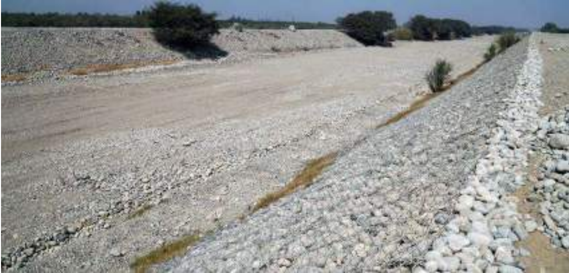
Fotografía 4. Ejemplo de una defensa ribereña con un pedraplén y geomallas.
