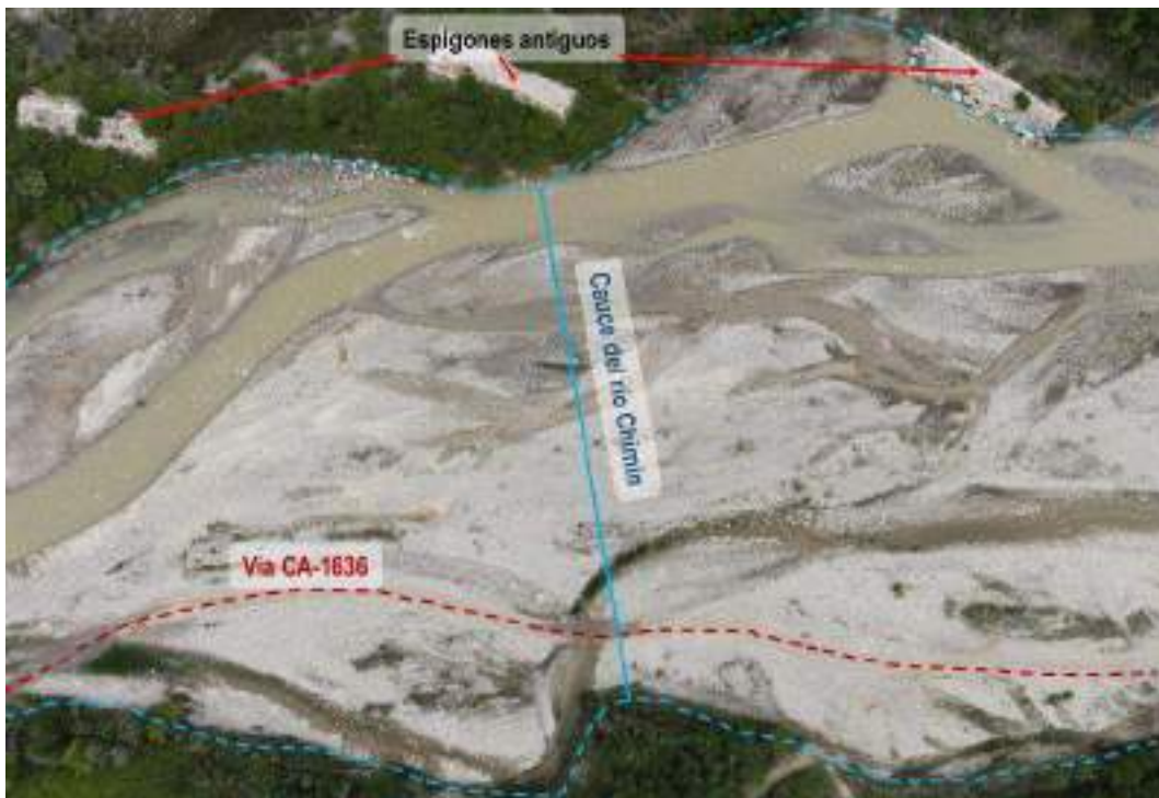
Figura 7. Vista del cauce del río Chimín por donde cruza un tramo de la vía vecinal CA-1636.
