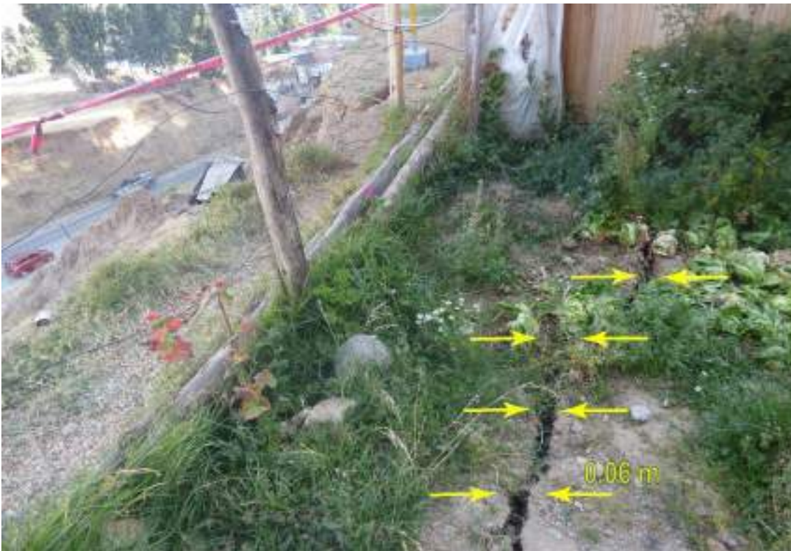
Figura 5: Grietas de tracción ubicadas por encima del escarpe principal y con aberturas de 0.06m.
