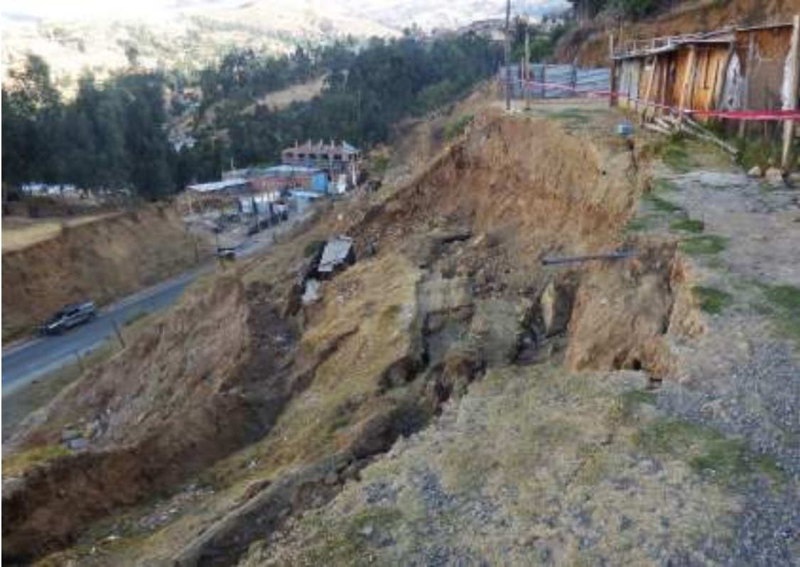
Fotografía 4: Vista del escarpe principal, de forma irregular y continua con una longitud de 45m y saltos verticales que varían de 1 a 2.5 m, así mismo se muestra la superficie del terreno bastante agrietada.
