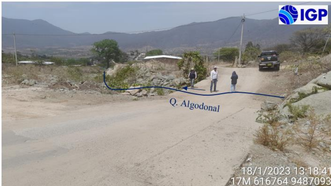
Figura 26.- Cauce de la quebrada Algodonal donde se ha implementado un badén en la prolongación de la Av. Miguel Grau (situada a 210 m al norte de Algodonal)
