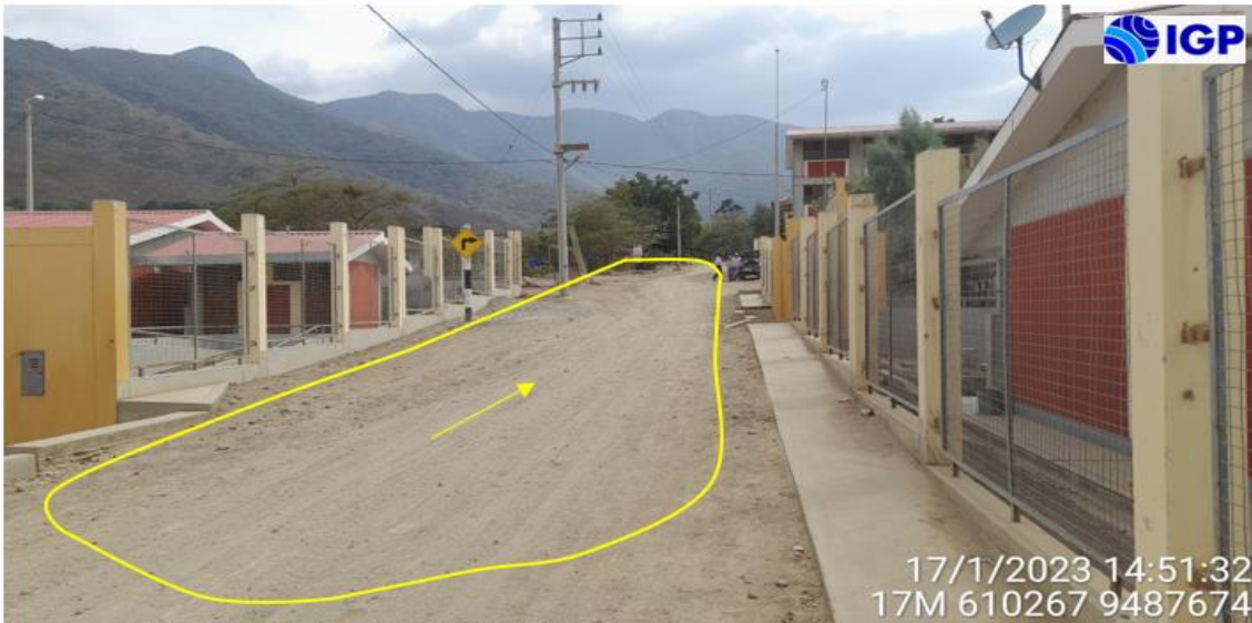
Figura 32.- Vía adyacente a la institución educativa denominada colegio Nacional de Culqui por donde discurre agua (polígono amarillo) en dirección suroeste – sureste, además se evidencia desnivel topográfico inferior (1-2 m) en algunas aulas
