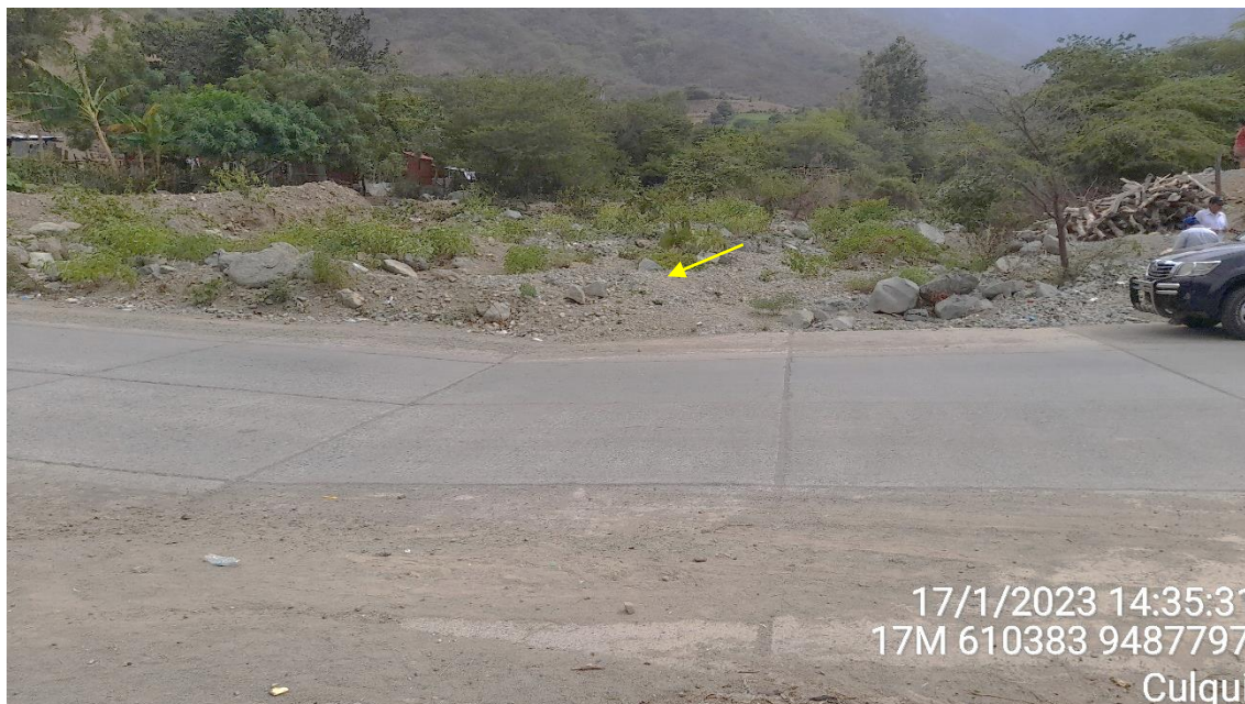
Figura 16.- Unidad geomorfológica cauce aluvial que pertenece a la quebrada Culqui, cuyas aguas en épocas de lluvias intensas atraviesan el badén ubicado en la vía de acceso principal
