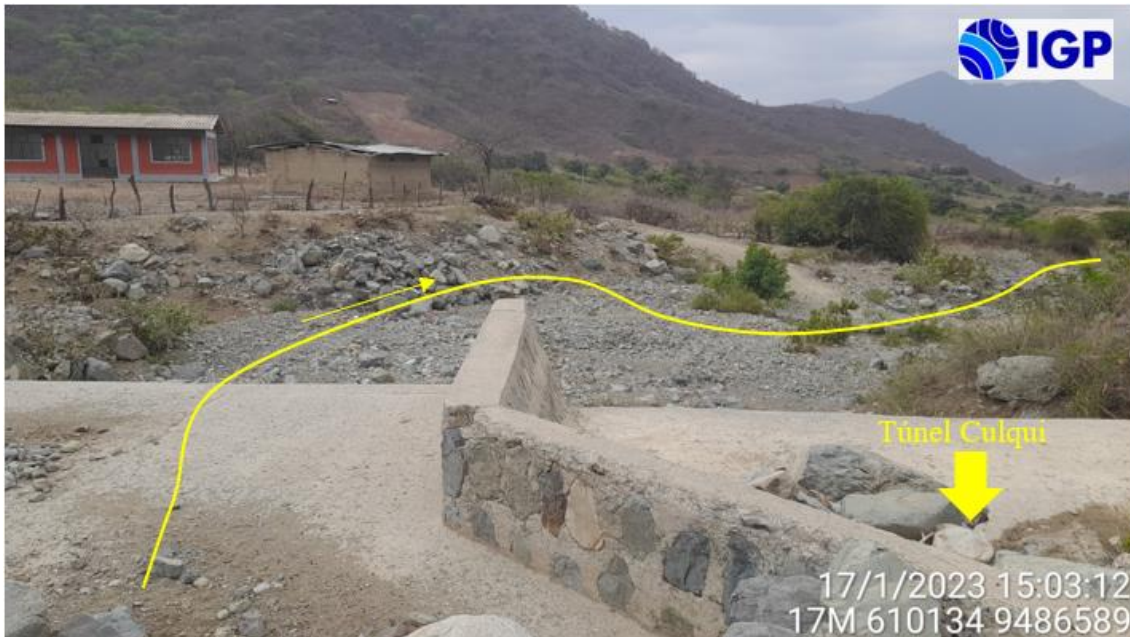
Figura 31.- Cauce de la quebrada Culqui por donde discurren los flujos de detritos y atraviesan el canal y alcantarilla.
