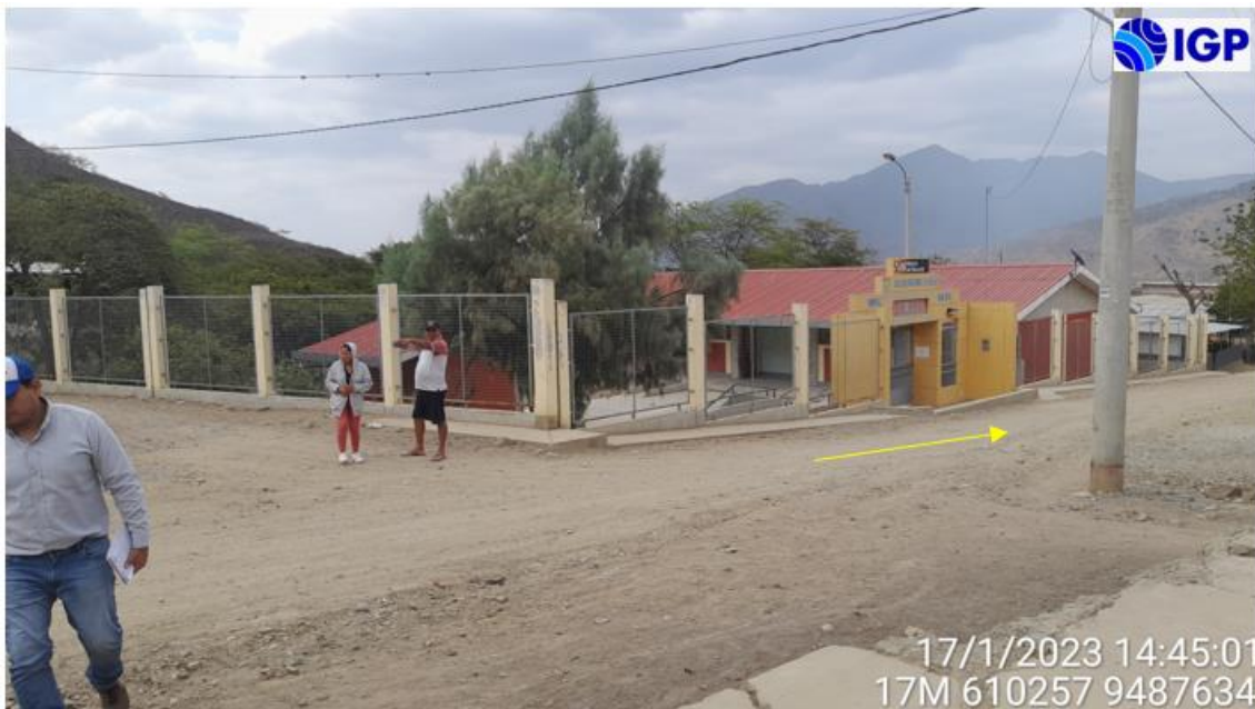
Figura 33.- Vía susceptible a la ocurrencia de inundaciones pluviales (flecha amarilla)
