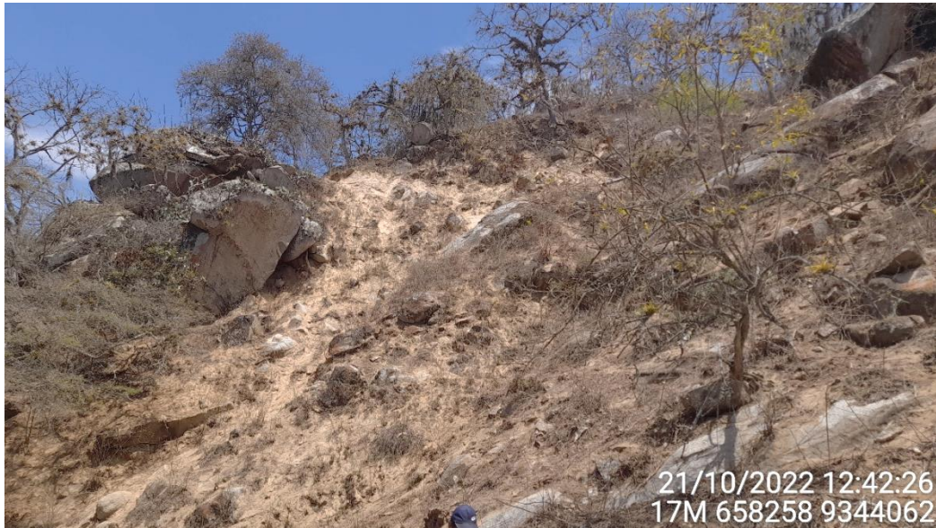
Figura 14.- Rocas fracturadas e inestables sobre la ladera del sector Cueva de Gallinazos donde se produjo el evento del tipo caída de rocas como consecuencia del sismo ocurrido el día 26 de septiembre, los bloques movilizados no afectaron población o infraestructura debido a que se encuentra fuera del área donde se asientan las viviendas de este centro poblado.
