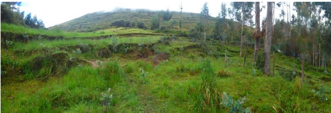
Fotografía 7. Se aprecia una lomada, parte del cuerpo del deslizamiento antiguo, escalonada, la cual se encuentra con procesos de agrietamientos, y escarpas en proceso de formación.
