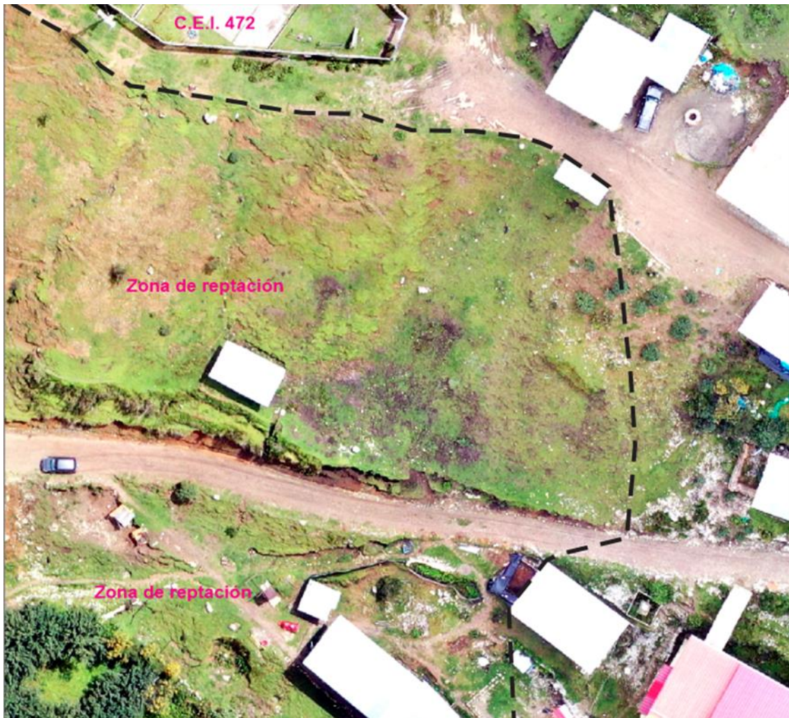
Figura 19. Parte media-inferior central-derecha, del cuerpo del deslizamiento antiguo, se aprecia procesos de reptaciones.
