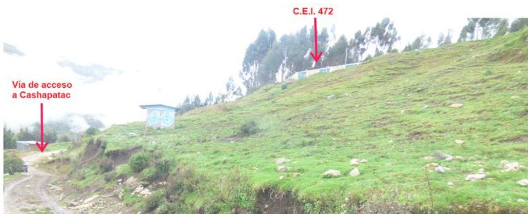
Figura 20. En la ladera se observa proceso de reptación. (Coordenadas 278401E, 8952646N Zona 18).
