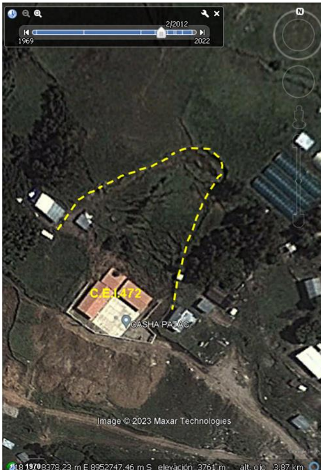
Figura 13 Imagen satelital del Google Earth (2012), muestra el deslizamiento que afectó y sigue afectando al centro educativo inicial N°472 del caserío de Cashapatac.
