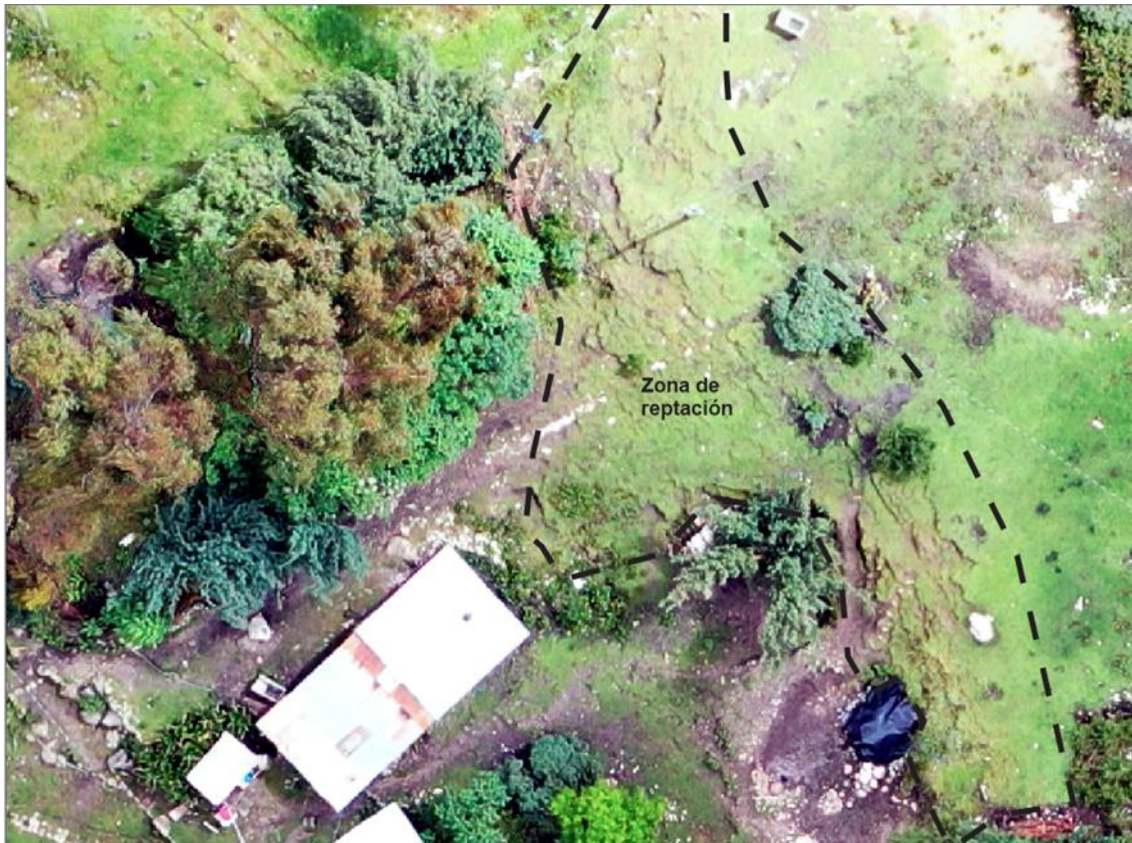
Figura 18. Muestra procesos de reptación de suelos, en la parte media derecha del deslizamiento
