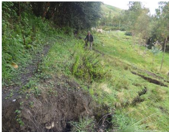
Fotografía 13. Se aprecia un escarpe, con altura de 1m, además se observa el agrietamiento del terreno.
