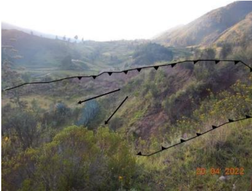
Figura 7: Se aprecia la escarpa principal del deslizamiento de Retamachayoc.
