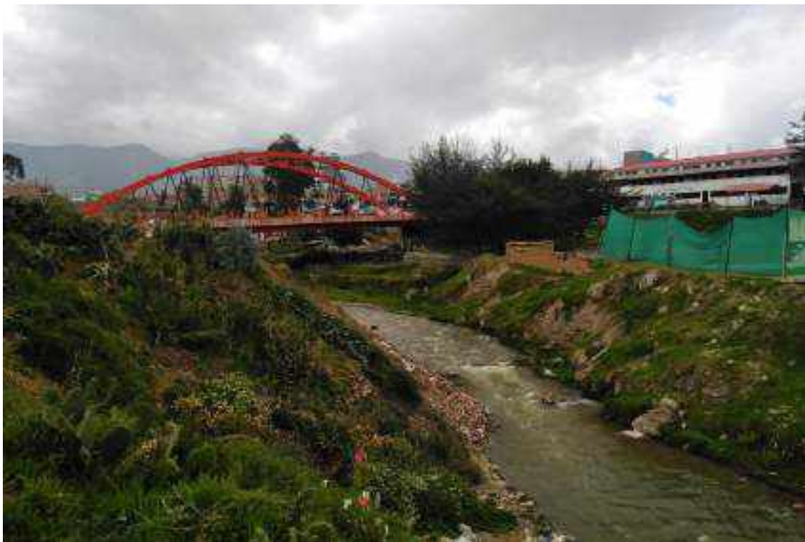
FOTO N°01: SE OBSERVA EL RIO SHULLCAS A LA ALTURA DEL PUENTE CARRION
