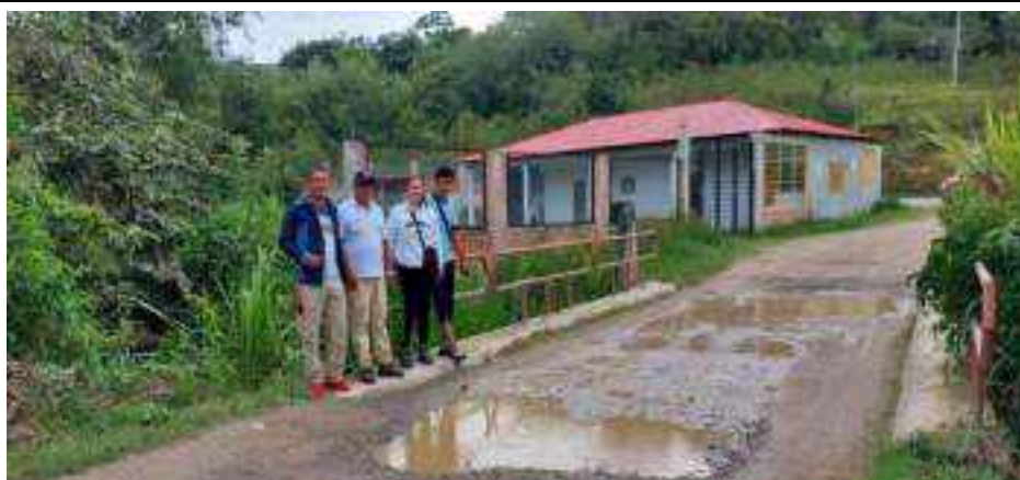
Foto 1. Puente principal hacia el distrito
