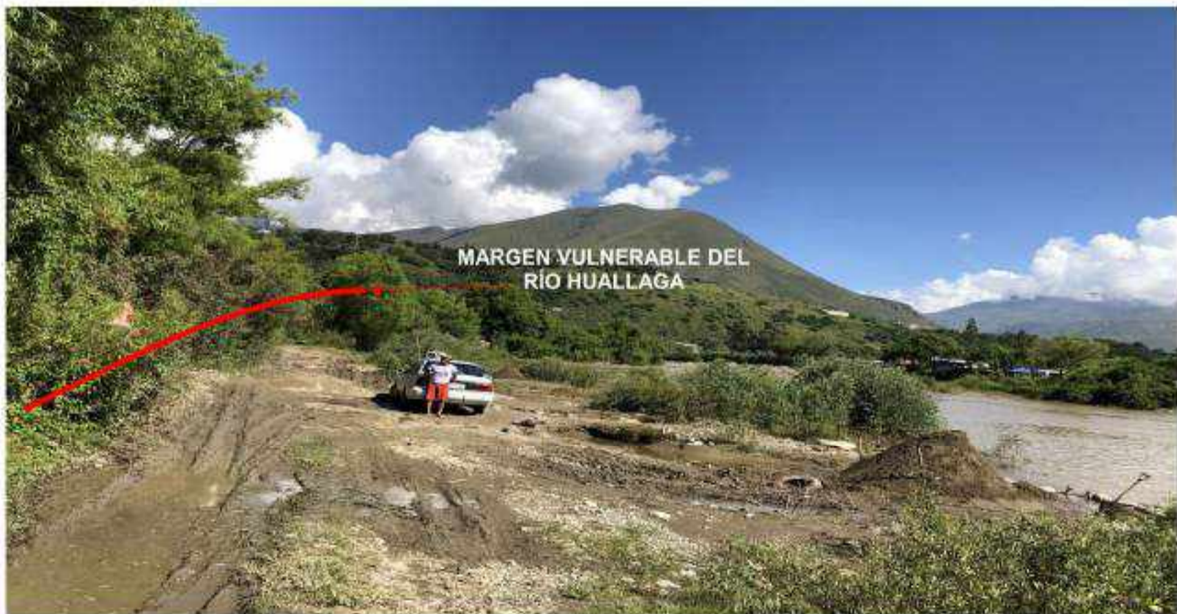
FIGURA N°01: TRAMO CRÍTICO EN EL RIO HUALLAGA, EN EL SECTOR PITUMAMA, DISTRITO DE PILLCO MARCA, PROVINCIA DE HUANUCO - HUANUCO
