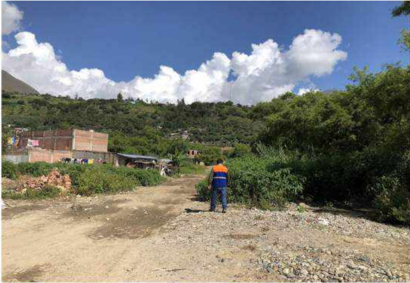
FIGURA N°02: VIVIENDAS, CALLES EXPUESTOS ANTE UNA CRECIDA DEL RÍO HUALLAGA EN LA MARGEN IZQUIERDA
