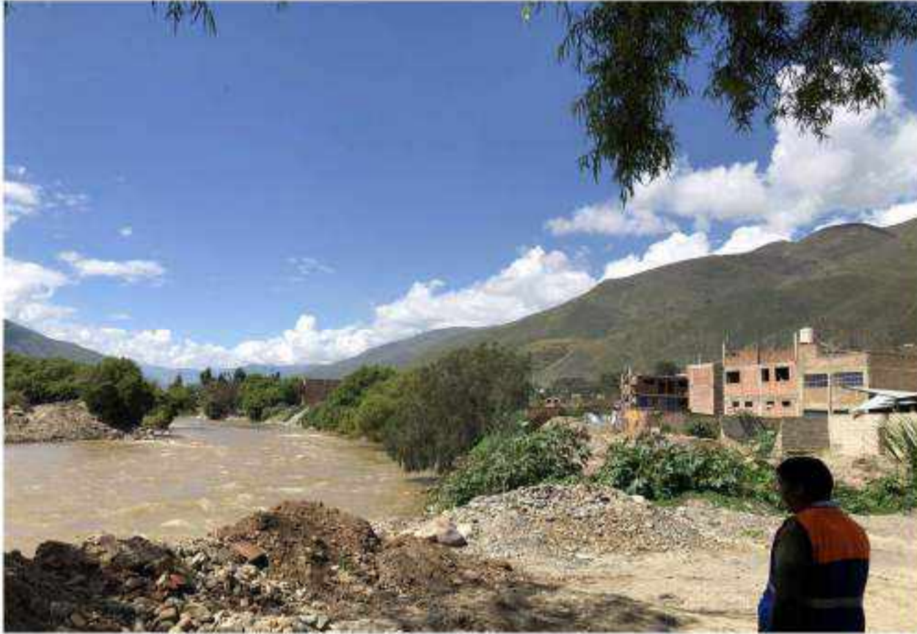
FIGURA N°02: VIVIENDAS, CALLES EXPUESTOS ANTE UNA CRECIDA DEL RÍO HUALLAGA EN LA MARGEN
