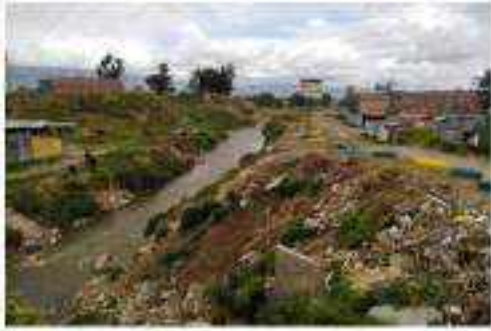
FOTOS N°02, 03, 04, 05: SE OBSERVA EL ANGOSTAMIENTO DEL CAUCE DEL RIO SHULLCAS CON MATERIAL DESMONTE Y VIVIENDAS EN AMBAS MARGENES
