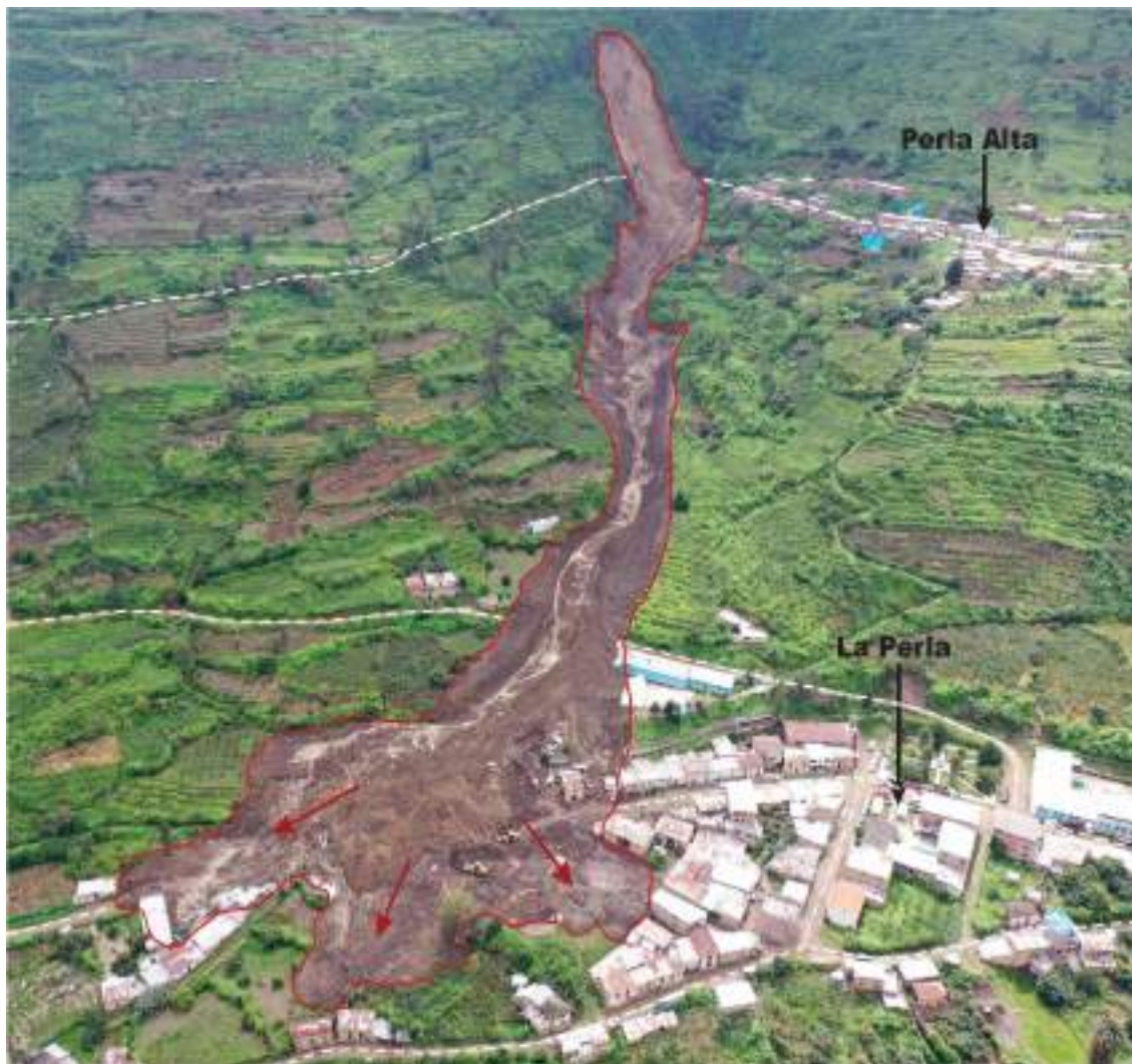
Figura 16. Vista con dirección noreste, donde se observa la avalancha de detritos (delimitado con línea de color rojo), que afectó parte del poblado La Perla, así como las trochas carrozables de acceso hacia La Perla y Perla Alta (líneas separadas de color blanco).
