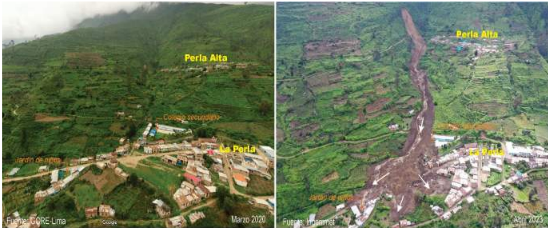
Figura 19. Comparación de una imagen obtenida del Google Earth del año 2020 y la fotografía tomada con drone (2023). En la primera se observa viviendas asentadas varias en el cauce de la quebrada. La segunda corresponde a la tomada post evento, se observa la avalancha de detritos, el cual afectó severamente viviendas, tramos de carretera, así como terrenos de cultivos.
