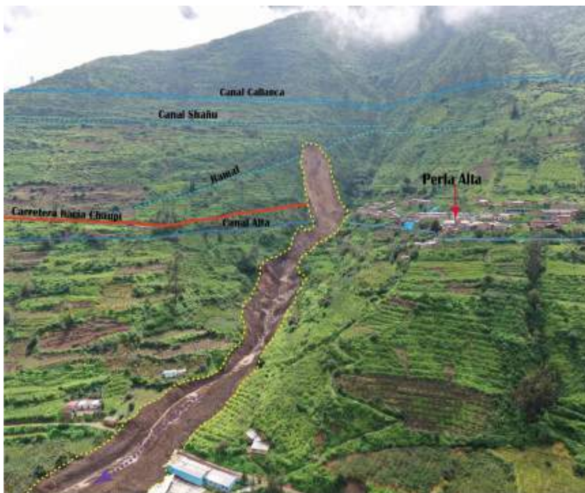
Figura 20. Vista de los canales próximos a la avalancha de detritos.
