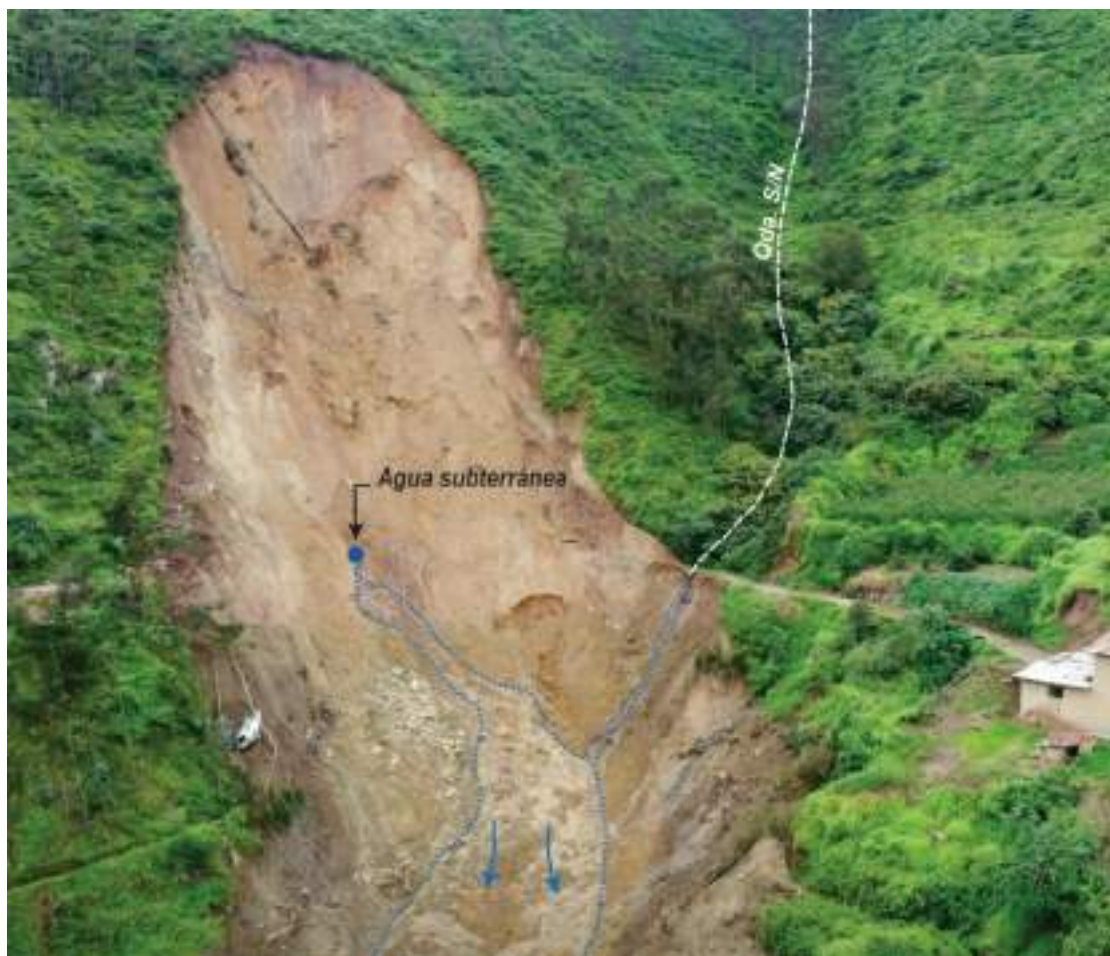
Figura 18. Vista tomada con el dron donde se observa que en medio del cuerpo de la avalancha de detritos existe afloramiento de agua (puquial), que aportó con la saturación de suelo, así como también el discurrir de agua sobre la quebrada.
