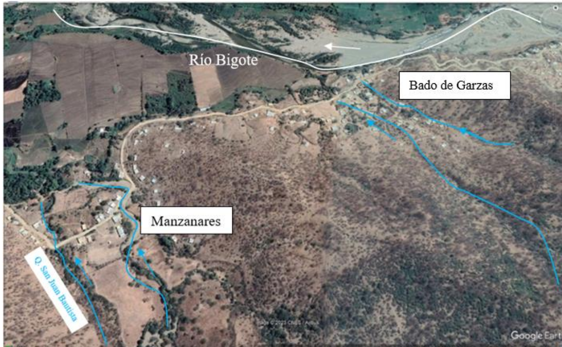
Figura 16.- Vista de quebradas susceptibles a flujo de detritos (líneas celestes) en las inmediaciones de los poblados Manzanares y Bado de Garzas
