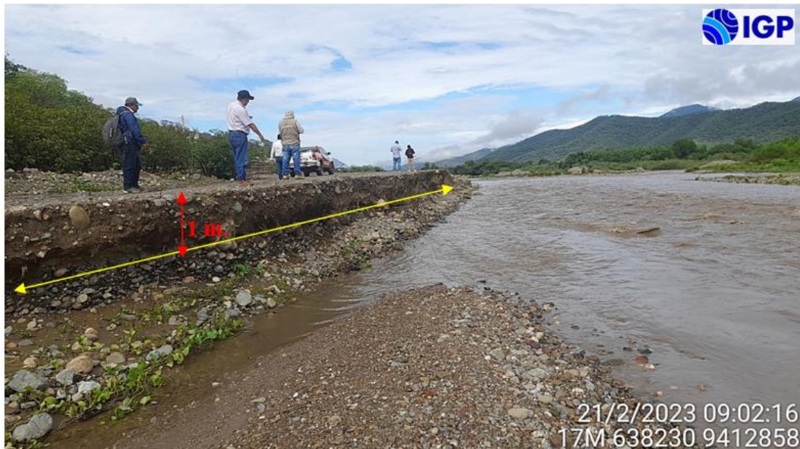
Figura 17.- Erosión fluvial (flecha amarilla) en el margen izquierdo del río Bigote donde las corrientes fluviales afectan la terraza aluvial conformado por gravas mal graduadas
