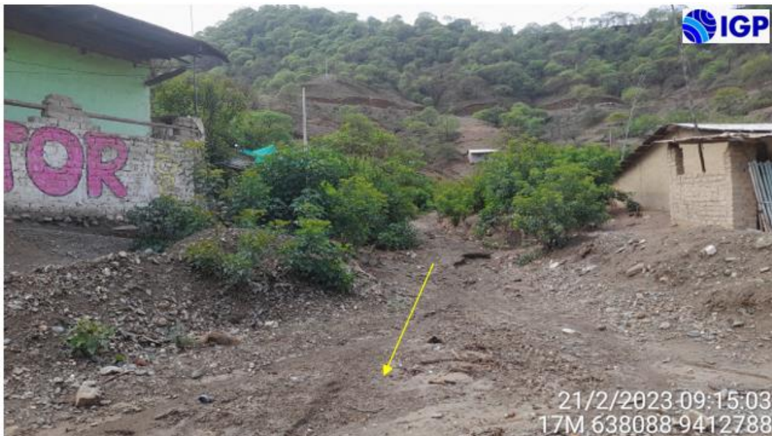
Figura 14.- Flujo de detritos en las inmediaciones de quebrada situada a 980 m al noreste del poblado Bado de Garzas, los materiales fluyen en dirección sur a norte hasta su desembocadura al río Bigote, encontrándose algunas viviendas contiguas al cauce
