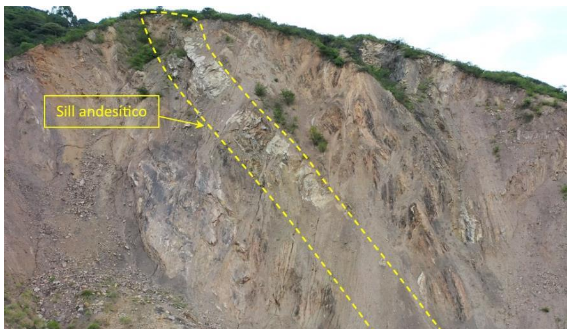
Figura 2. Talud donde se observa intrusión del sill andesítico en las calizas de la Formación Pariatambo.
