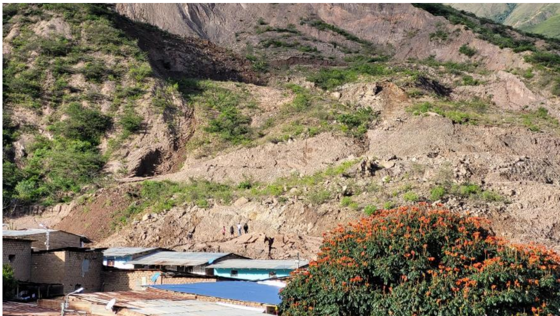
Fotografía 3. El movimiento se mantiene activo, el 09 de abril del 2023, el movimiento afectó 16 viviendas.
