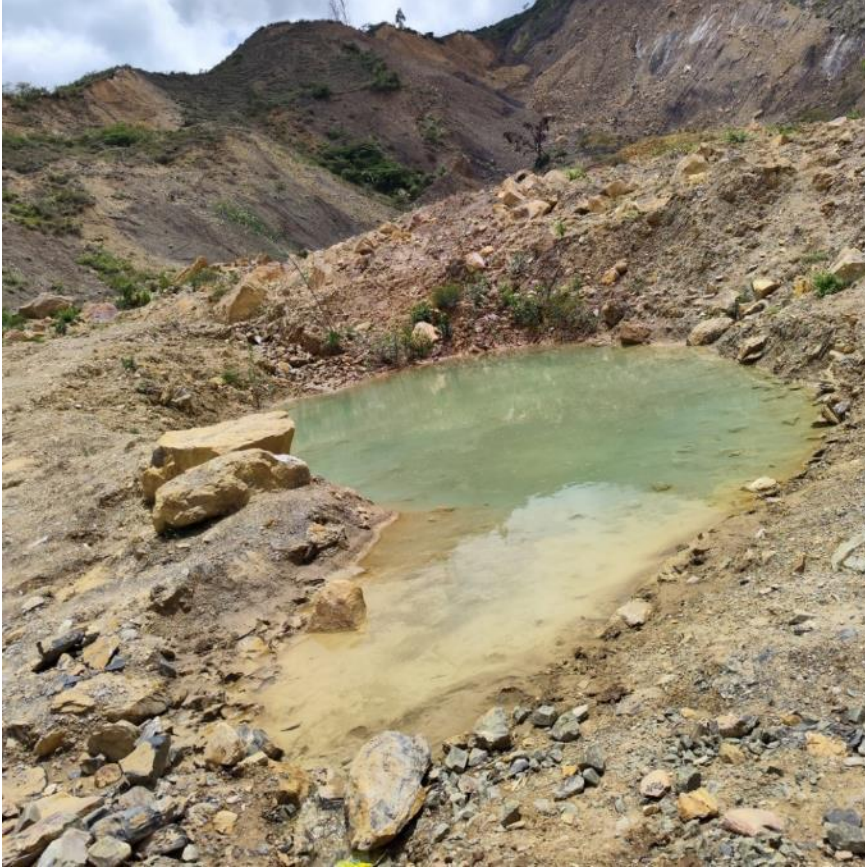
Fotografía 5. Surgencia de agua (sin drenar), dentro del cuerpo del deslizamiento, 27 de marzo del 2023 Coordenadas UTM WS-84 -17S, Norte: 9374090 – Este: 686469.
