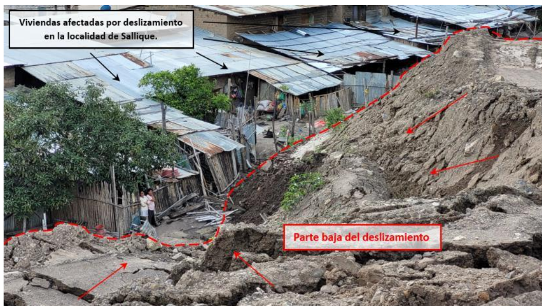
Figura 18. Vivienda muy afectada (inhabitable), ubicada en el cuerpo de deslizamiento. Coordenadas UTM WS-84 -17S, Norte: 9309119 – Este: 737411.
