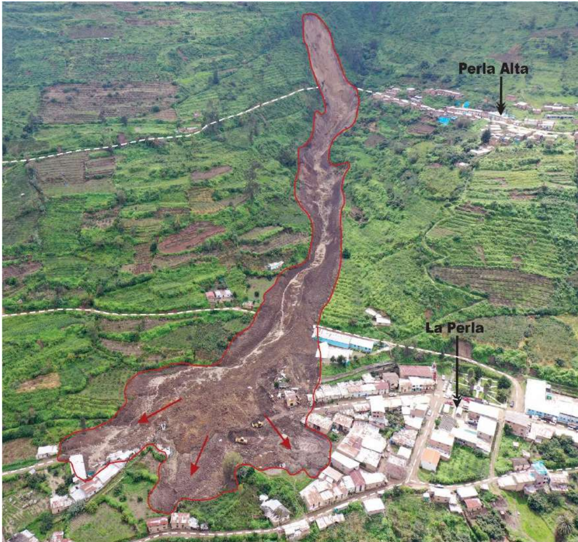
Figura 16. Vista con dirección noreste, donde se observa la avalancha de detritos (delimitado con línea de color rojo), que afectó parte del poblado La Perla, así como las trochas carrozables de acceso hacia La Perla y Perla Alta (líneas separadas de color blanco).
