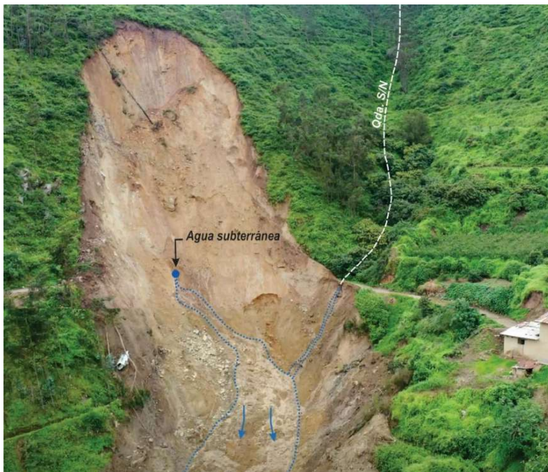
Figura 18. Vista tomada con el dron donde se observar que en medio del cuerpo de la avalancha de detritos existe afloramiento de agua (puquial), que aportó con la saturación de suelo, así como también el discurrir de agua sobre la quebrada.
