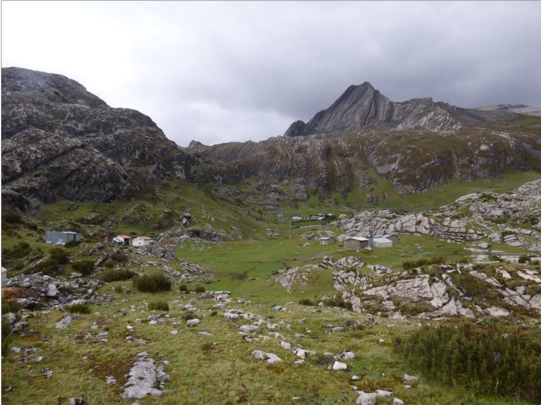
Fotografía 9. Sector Pincullo asentado sobre rocas sedimentarias tipo calizas, las cuales están sufriendo procesos de karstificación tipo hundimientos que afectarían las viviendas del sector referido. Así mismo, se observa caída de rocas de la ladera noroeste que limita el sector.
