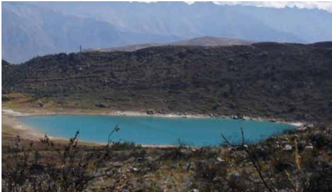
Fotografía N° 21: Laguna Keushu en Yungay, embalse antrópico precolombino para la infiltración de agua derivada por canales en tiempo de lluvias.
