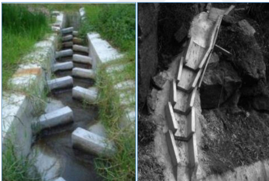
Fotografía N° 22: Fotografía 21. Medidas de ingeniería para deslizamientos que pueden ser complementadas con soluciones Eco-RRD.
