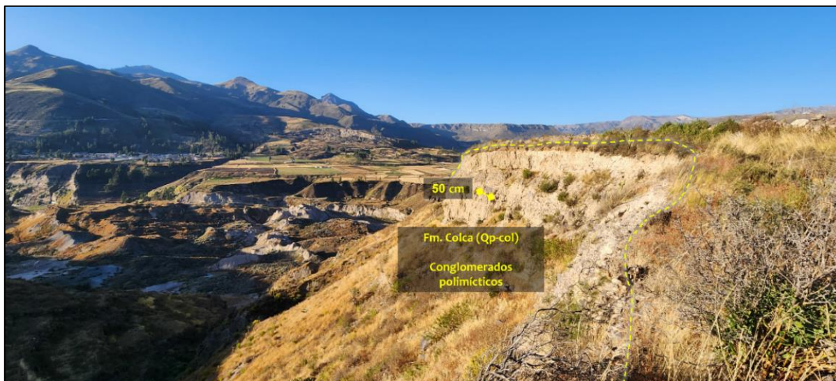
Figura 1. Unidad geológica en el deslizamiento Achoma. UTM E: 211969, N: 8266511.
