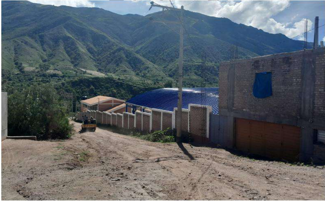
FIGURA N°03: INSTITUCION EDUCATIVA EXPUESTA A POSIBLE AFECTACION POR DESLIZAMIENTO Y/O CRECIDA DE LA QUEBRADA HUAMAN HUAYCCO
