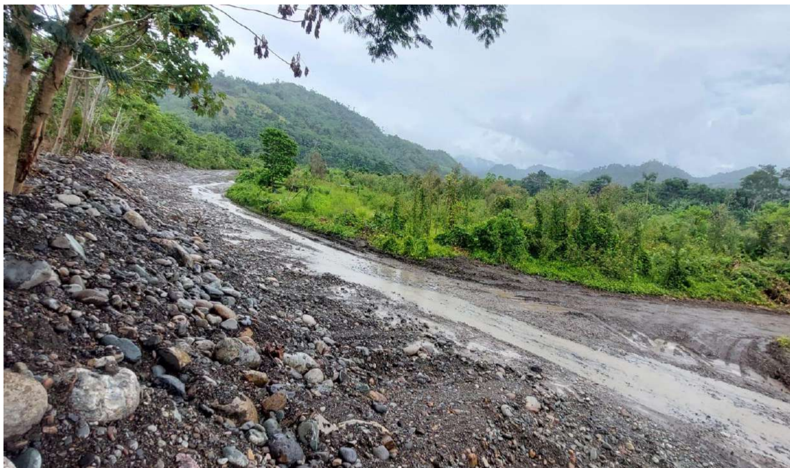
FIGURA N°02: VISTA DE TALUD DE LA MARGEN DERECHA DEL RÍO SABOGATO. ALTA VULNERABILIDAD POR LA EROSIÓN HÍDRICA.
