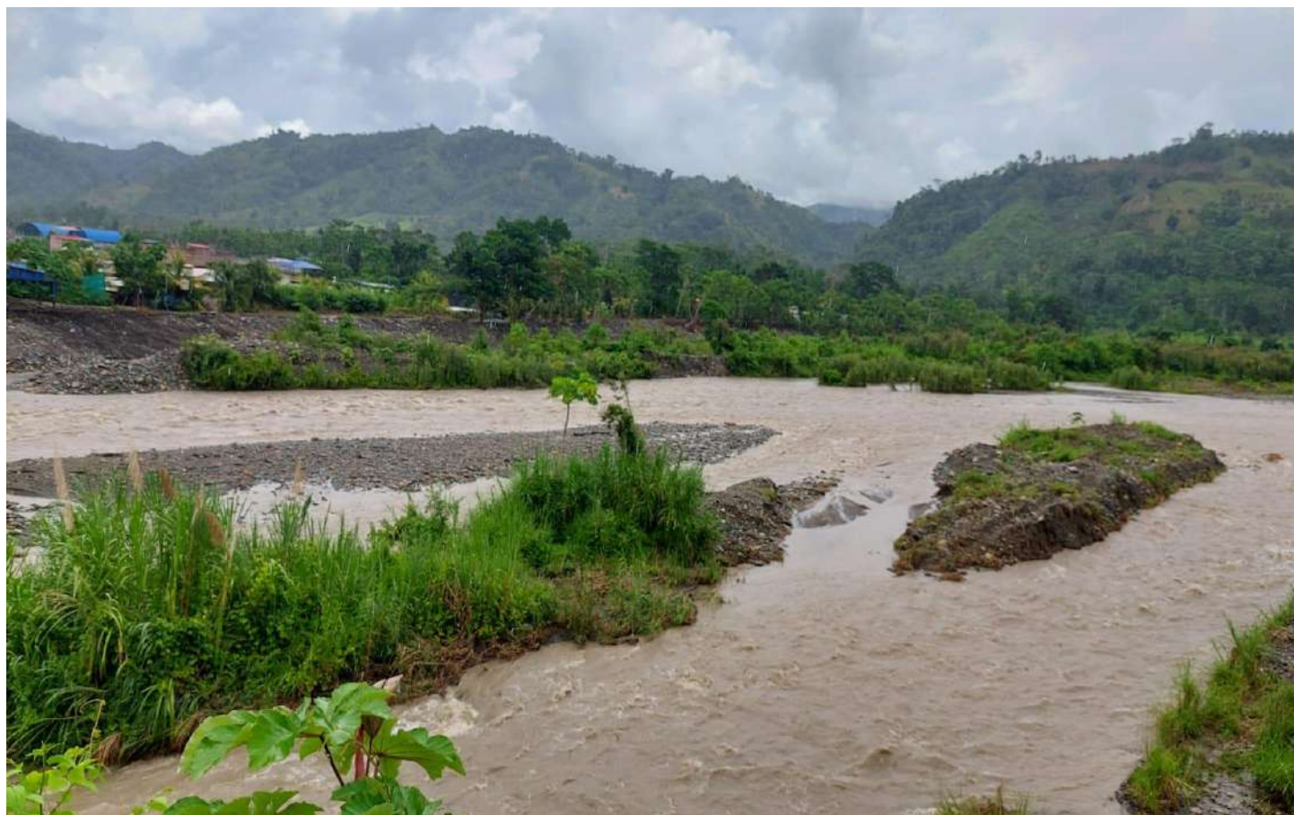
FIGURA N°03: VISTA PANORÁMICA DEL RÍO TINCUY, EN LA MARGEN DERECHA SE OBSERVAN VIVIVENDAS EN INMINENTE PELIGRO POR EROSIÓN DE TALUDES.
