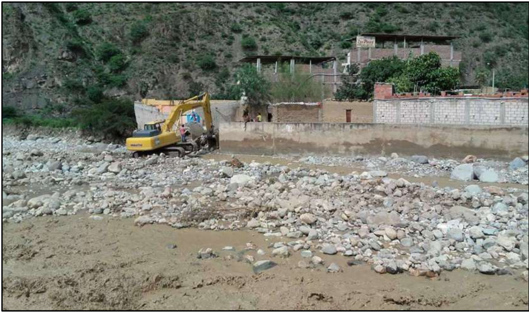
FIGURA N°02: LIMPIANDO LA COLMATACIÓN ANTE UNA CRECIDA DEL RIO HUERTAS
