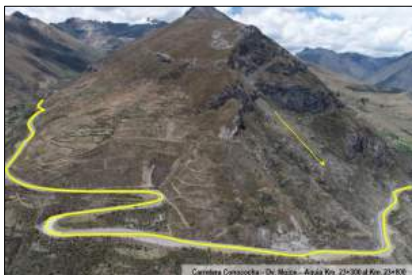
Ilustración 42. Zona de avalancha de rocas entre el Km. 23+300 al Km. 23+800 de la carretera Conococha – Dv. Mojón – Aquia – Huallanca.
