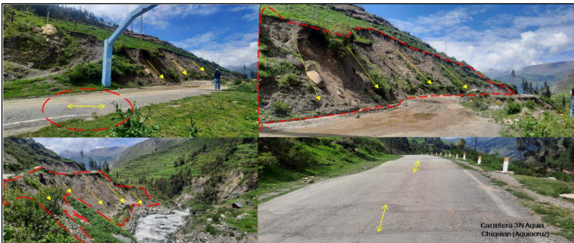
Fuente: Fotografía tomada por el ET-PPRRD-MDA, 2023.
