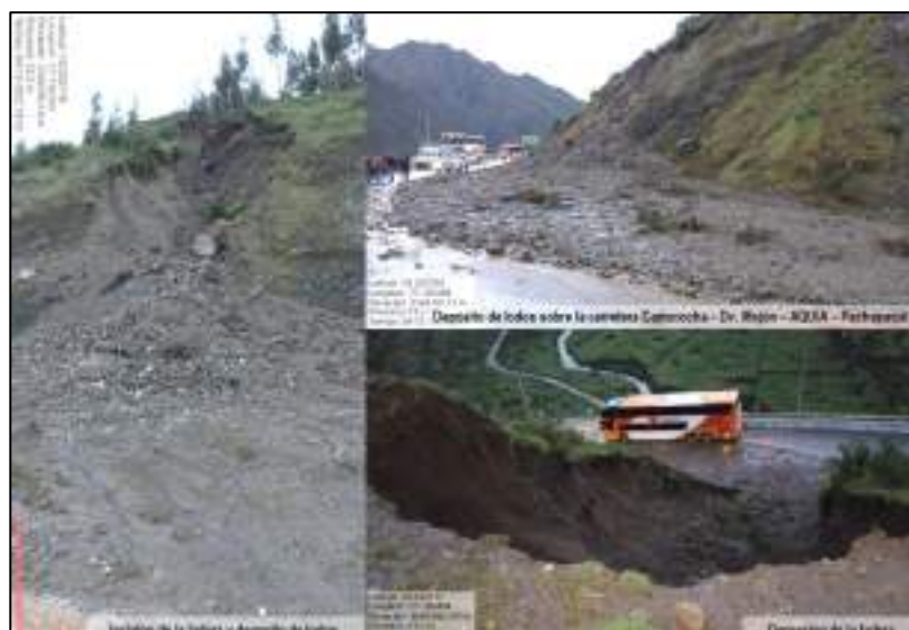
Ilustración 23. Flujo de lodos no canalizado en el Km. 28+000 de la carretera Conococha – Dv. Mojón - Aquia.
