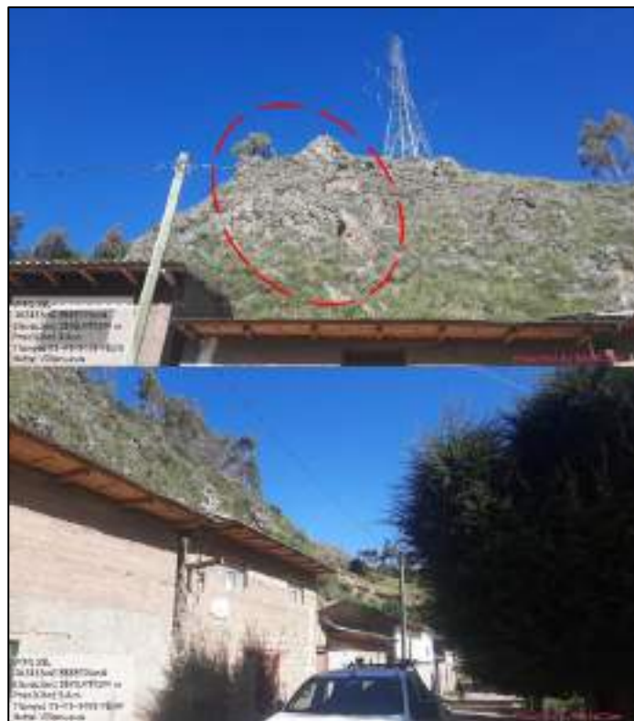
Ilustración 38. Caída de rocas sobre viviendas en el caserío de Villanueva.
