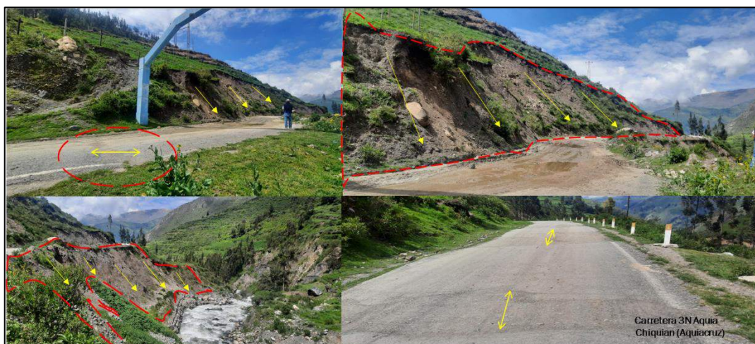
Fuente: Fotografía tomada por el ET-PPRRD-MDA, 2023.
