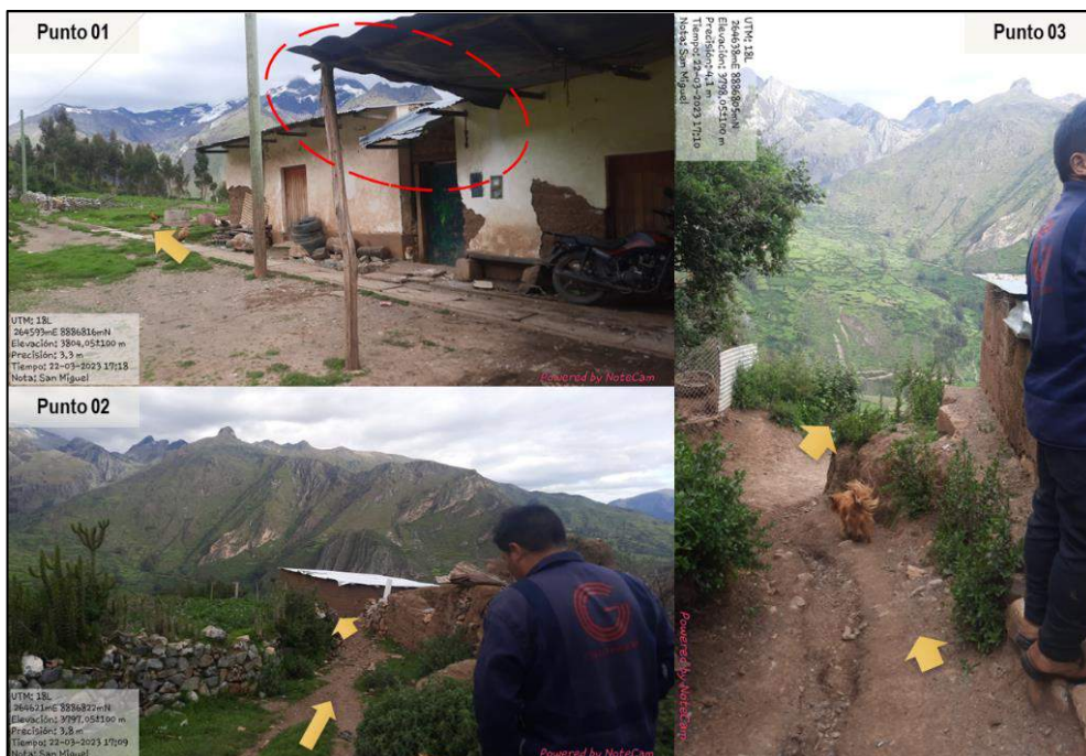
Ilustración 62. Viviendas afectadas por las lluvias intensas y flujo de agua de escorrentía pluvial.
