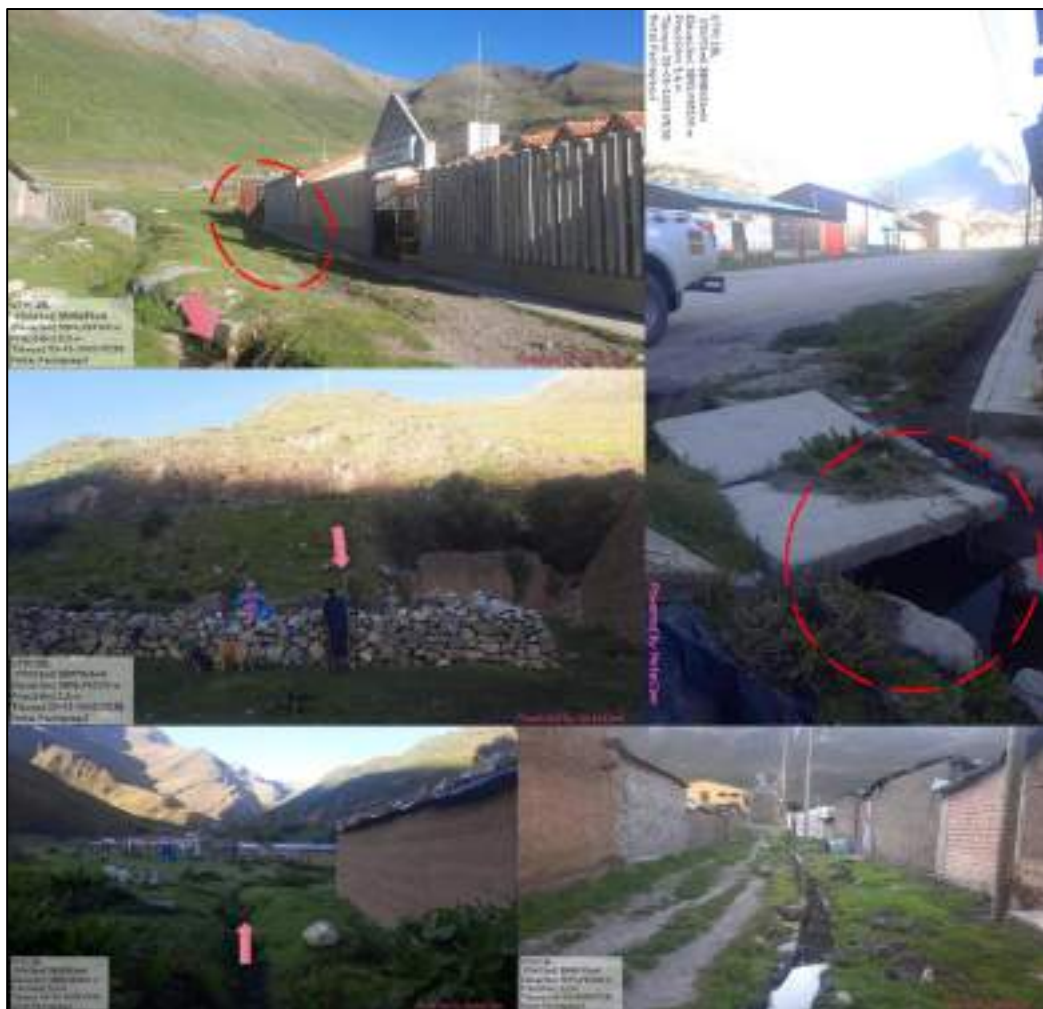
Ilustración 52. Colectores del canal de coronación y desfogue hacia Pachapaqui.
