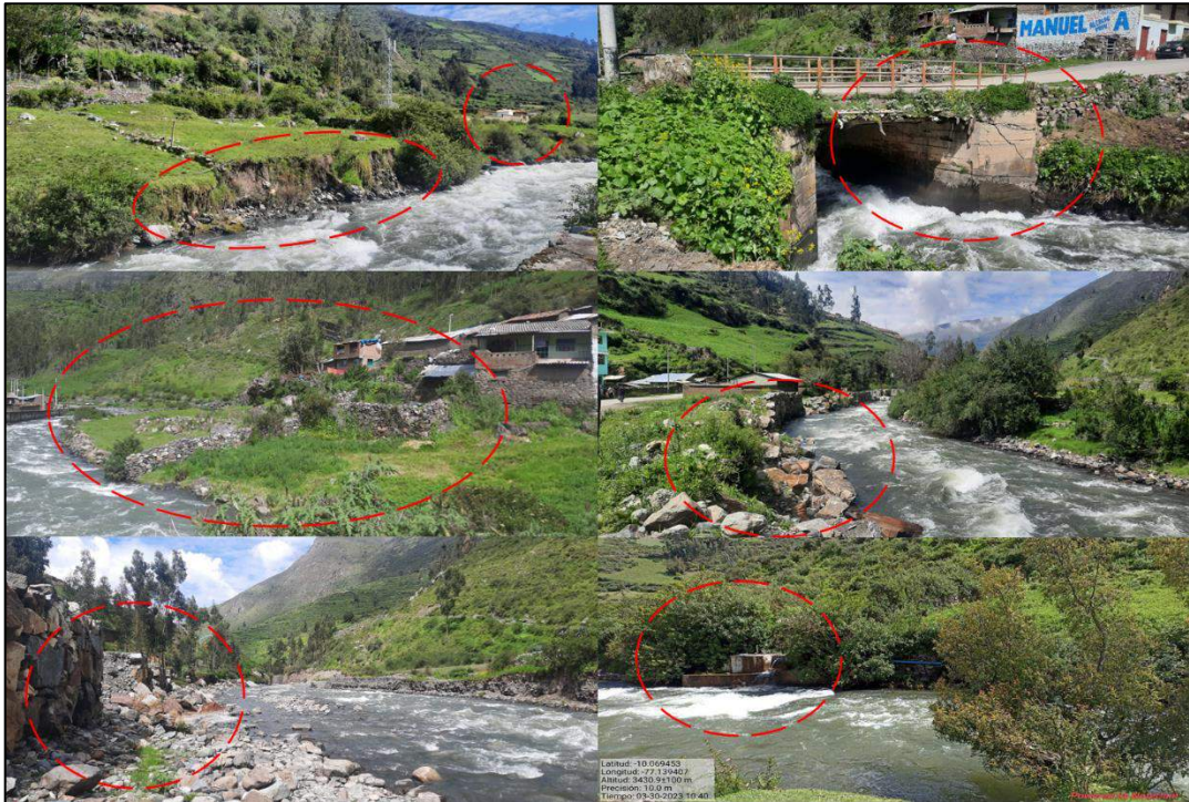
Ilustración 44. Procesos de erosión en la margen derecha, puente Aquia en mal estado, viviendas expuestas asentadas sobre áreas inundables, deterioro de la defensa ribereña y captación de agua (Cayac).
