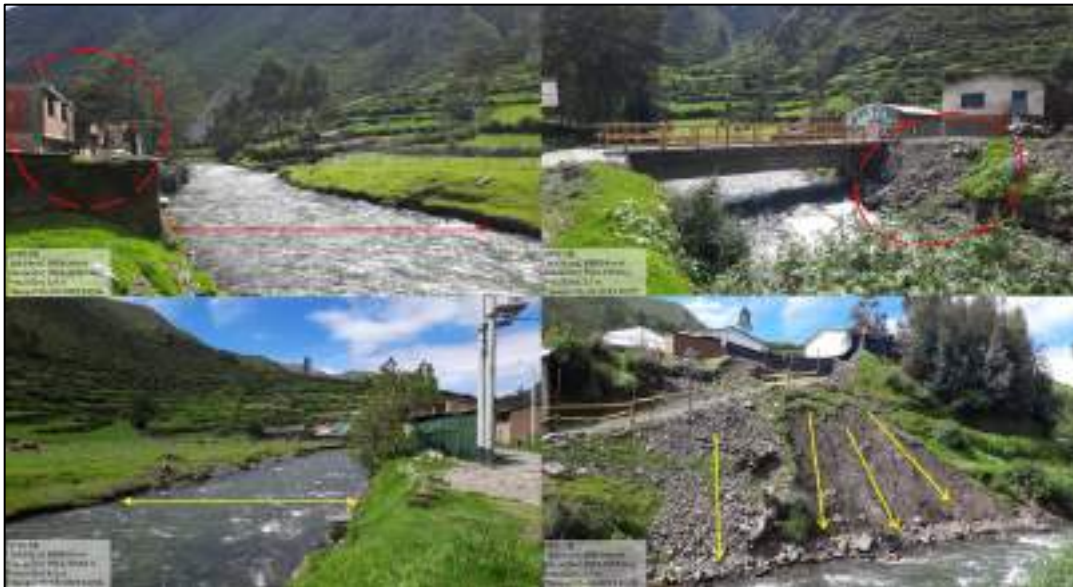
Ilustración 48. Viviendas sobre zonas inundables y márgenes del río erosionados.
