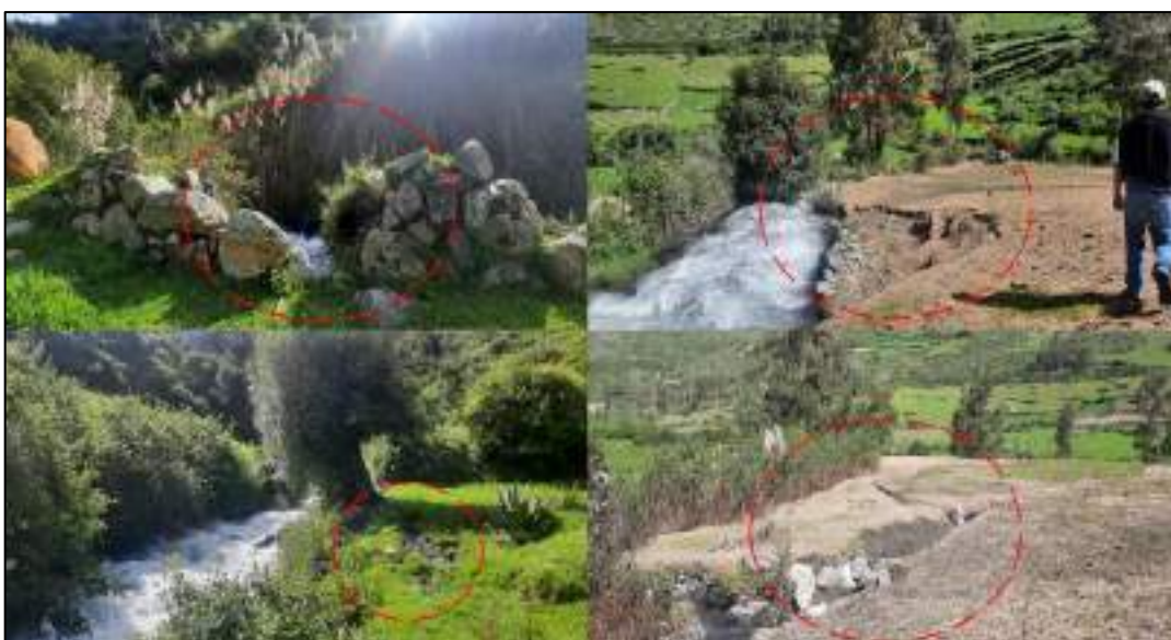
Ilustración 14. Pircas en mal estado a modo de defensa ribereña generando socavamiento de las márgenes y evidencias de filtración de agua hacia las áreas de cultivo.
