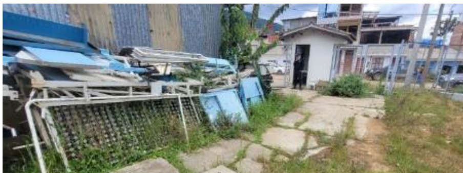
Fotografía 9. Estado de las instalaciones del establecimiento de salud afectado por reptación de suelos. Coordenada: E: 182791; N: 93309746; Z: 2367.
