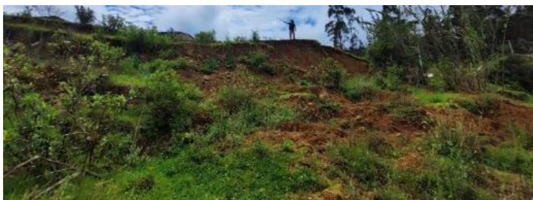
Fotografía 8. Vista del escarpe principal del deslizamiento DRA2. Coordenadas: E: 181923; N: 9309268; Z: 2284.
