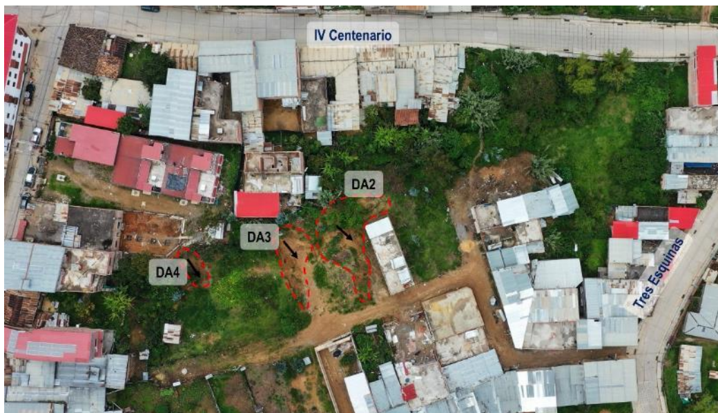
Figura 25. Vista de los derrumbes activos 2, 3 y 4 al oeste de la calle IV Centenario.
