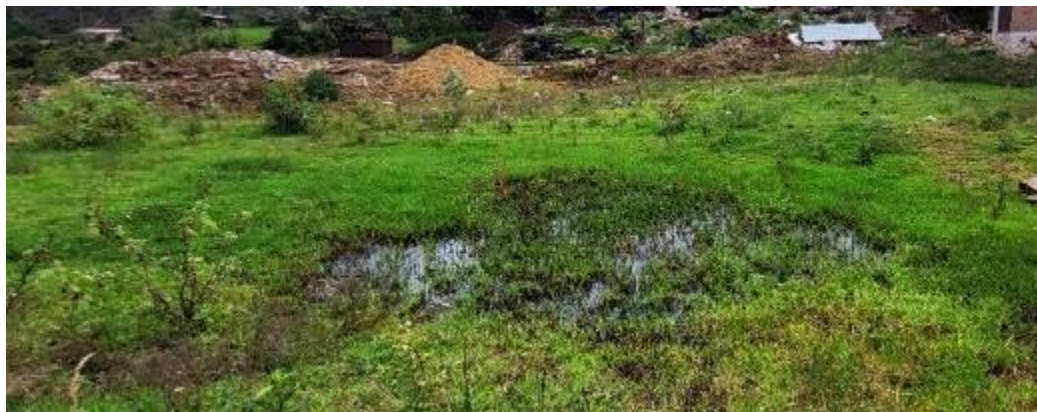
Fotografía 7. Presencia de agua en la parte superior del deslizamiento. Coordenadas: E: 181954; N: 9309267; Z: 2290.
