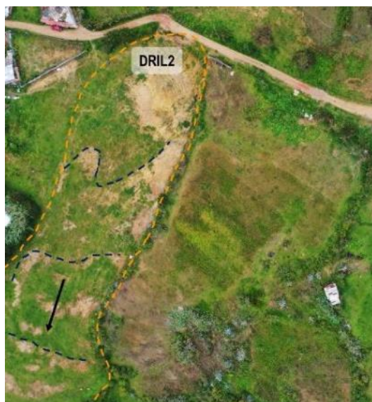
Figura 12. Vista del deslizamiento rotacional inactivo latente 2, al oeste del sector Residencial Derrama Magisterial.
