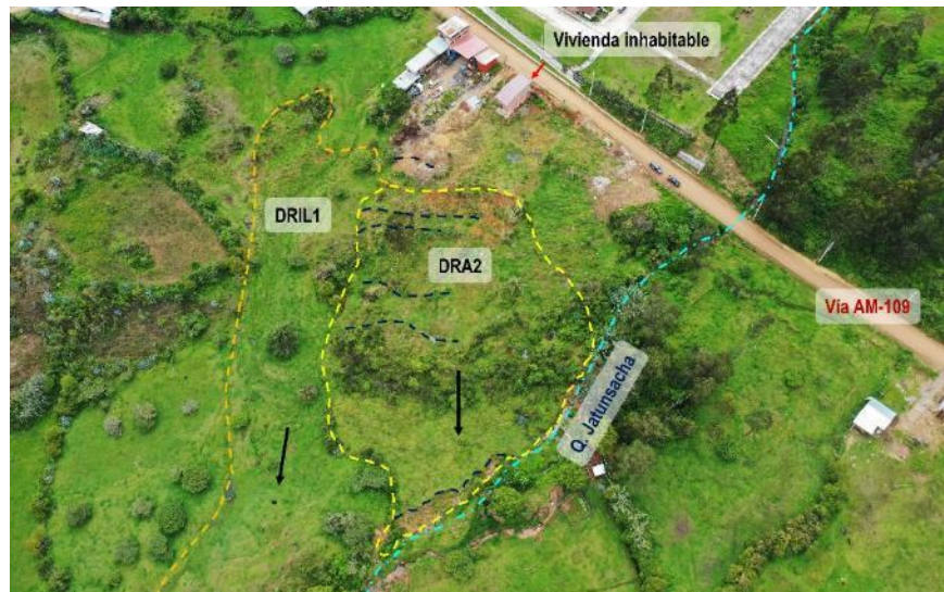
Figura 9. Vista del deslizamiento rotacional activo DRA 2 (a la derecha) y el deslizamiento rotacional inactivo DRIL 1 (a la izquierda) ubicados al oeste de la Residencial Derrama Magisterial.
