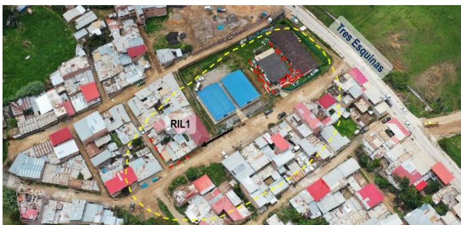
Figura 23. Vista de la zona de reptación de suelos inactiva latente 1.
