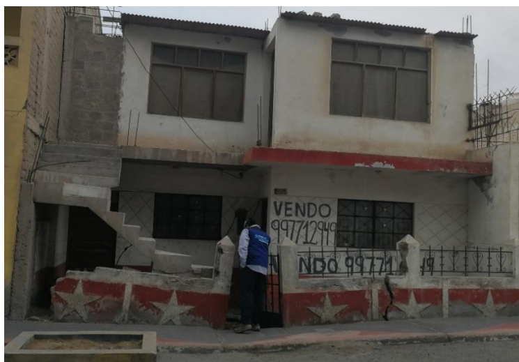
Fotografía N° 01: Visita a la casa afectada con rajaduras y un ligero hundimiento en la puerta de entrada (reja), por seguridad los habitantes desalojaron dicho domicilio.
