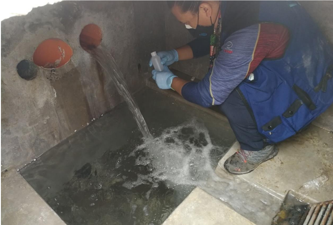
Fotografía N° 40: Interior de un sumidero, bajo las obras del sector del Parque de la Familia, el manantial del mismo nombre alcanza los 2 L/s, luego de juntarse todas las filtraciones a un ducto principal, se hicieron obras con drenes de filtración, recolección y evacuación del agua.
