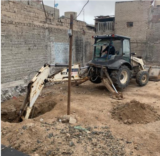
Fotografía N° 42: Momento de la ampliación de la calicata.
