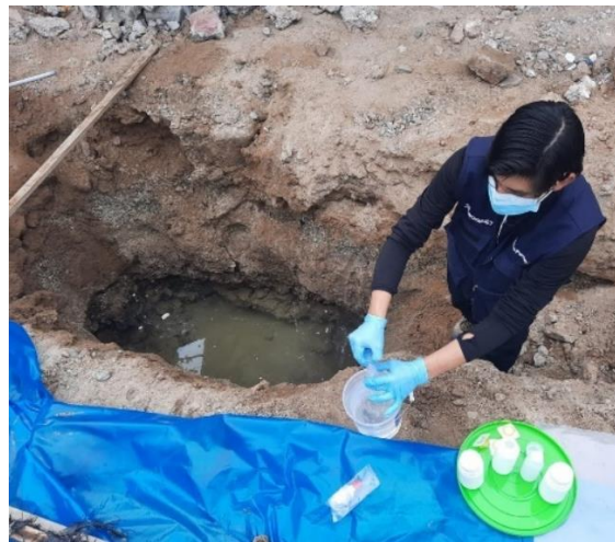
Fotografía N° 45: El nivel freático se encuentran 1.30 m de profundidad.
