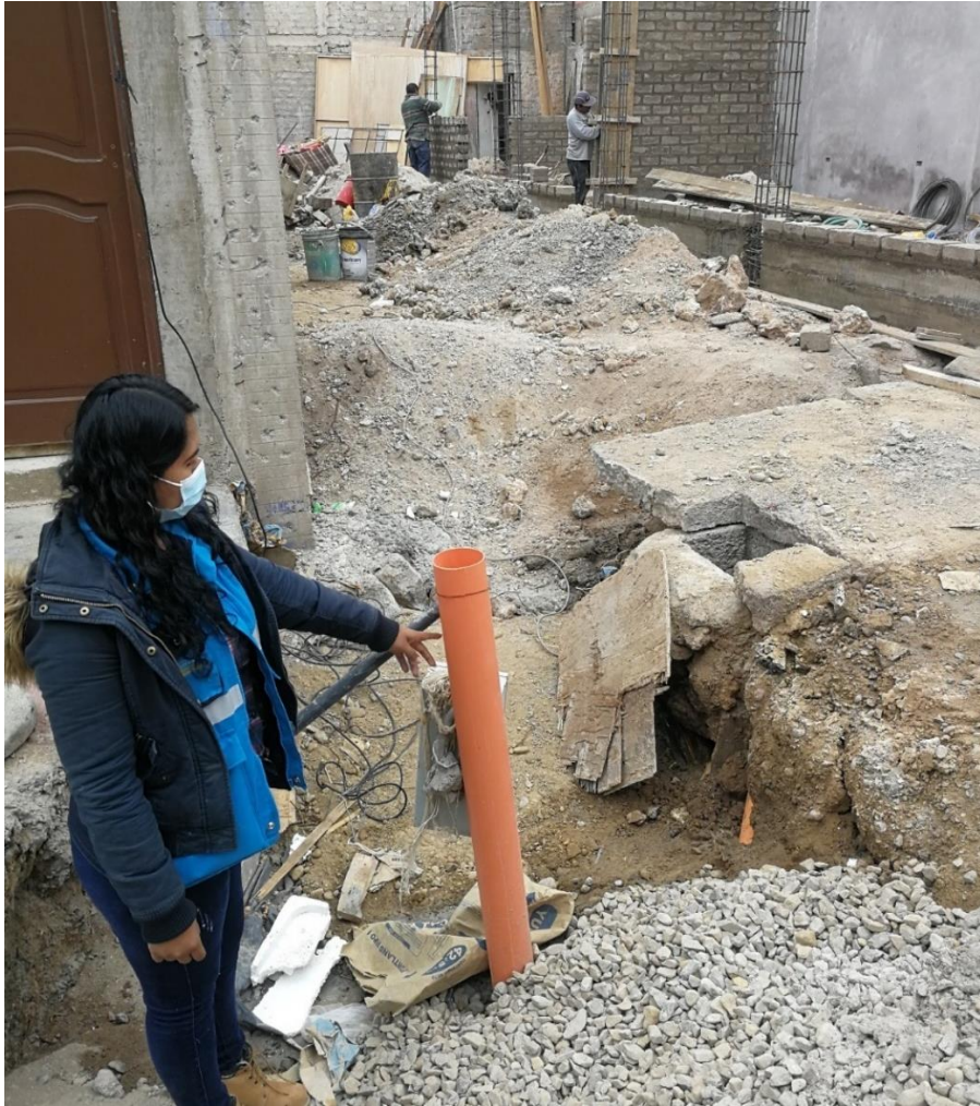
Fotografía N° 41: Construcción de la casa de la Sra. Eva, de igual forma, se están drenando los flujos de agua que aparecieron al hacer las excavaciones; en el tubo anaranjado se observó el flujo de agua que se está evacuando hacia el desagüe principal de la calle.
