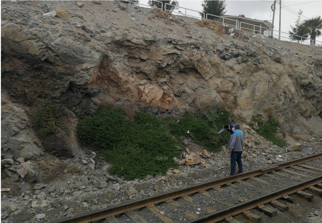
Fotografía N° 38: A pocos metros del manantial Riel, también se evidencian otras manifestaciones de agua, a través de filtraciones que siguen las ramificaciones de las fisuras abiertas, considerándola un manantial polisurgente.
