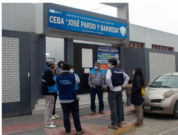
Fotografía N° 08: Visita a la institución educativa “José Pardo y Barreda”, para evidenciar los daños ocasionados.
