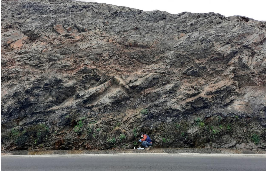
Fotografía N° 36: Manantial polisurgente Curva, se observa las surgencias a través de fisuras de muy baja escorrentía (en algunos sectores por goteo), con promedio de 0.5 L/s
