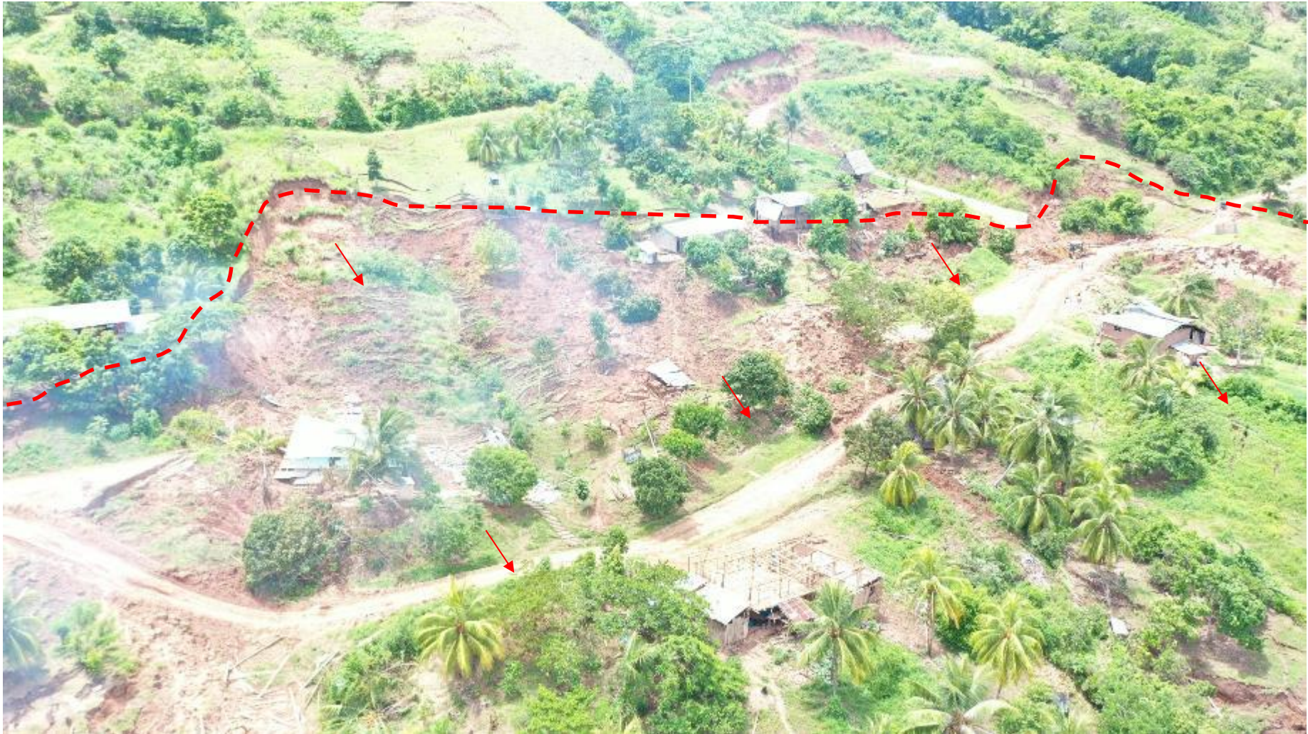
Figura 17. Viviendas afectadas y carretera hacia el C.P. de Yanayacu interrumpida.
