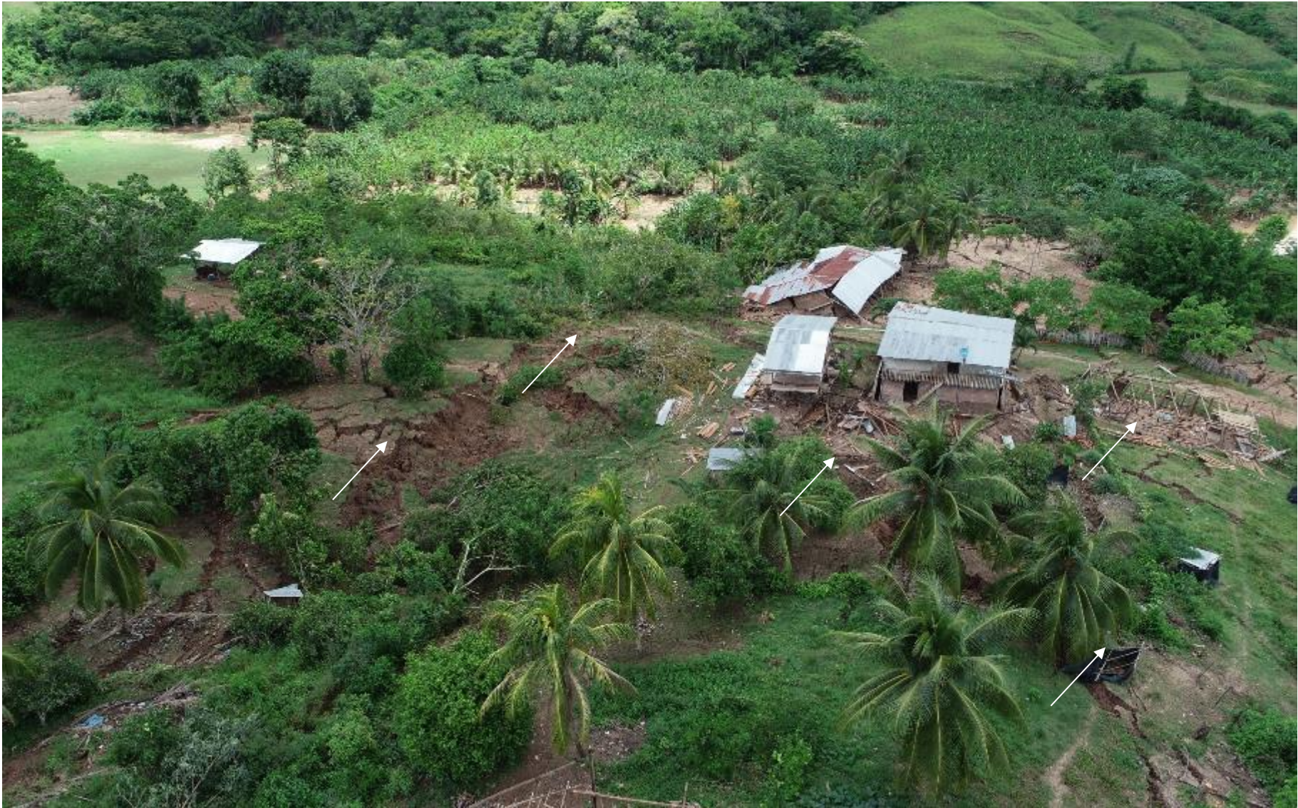
Figura 18. Viviendas afectadas por el deslizamiento. Agrietamiento del terreno.
