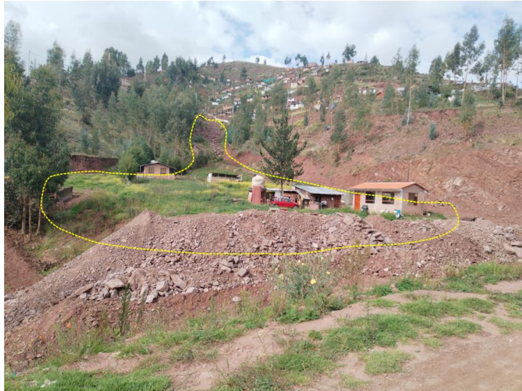
Foto 15: Posible flujo de detritos, se observa en la parte superior material de relleno disponible para ser arrastrado y depositado en la parte baja.
