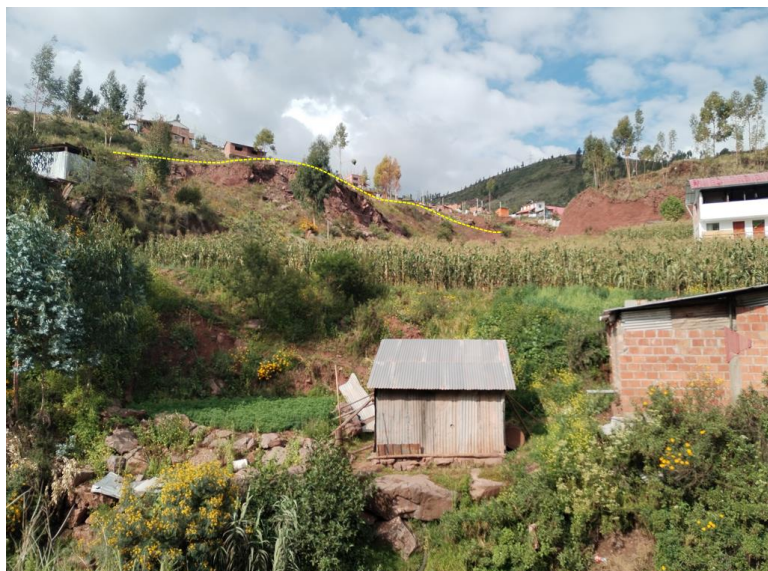
Foto 14: Pequeños derrumbes en la parte baja del sector de Reyna Belen
