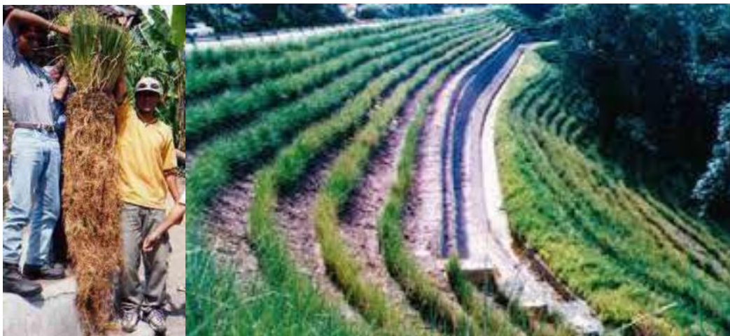
Fotografía 1. Ejemplo de bioingeniería con arbusto (vetiver) en taludes de materiales sueltos.
