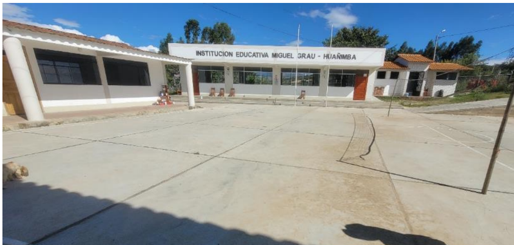
Fotografía 7. Patio de local actual no presenta ninguna fisura en paredes y patio. Coordenadas: E: 819769, N: 9158685.
