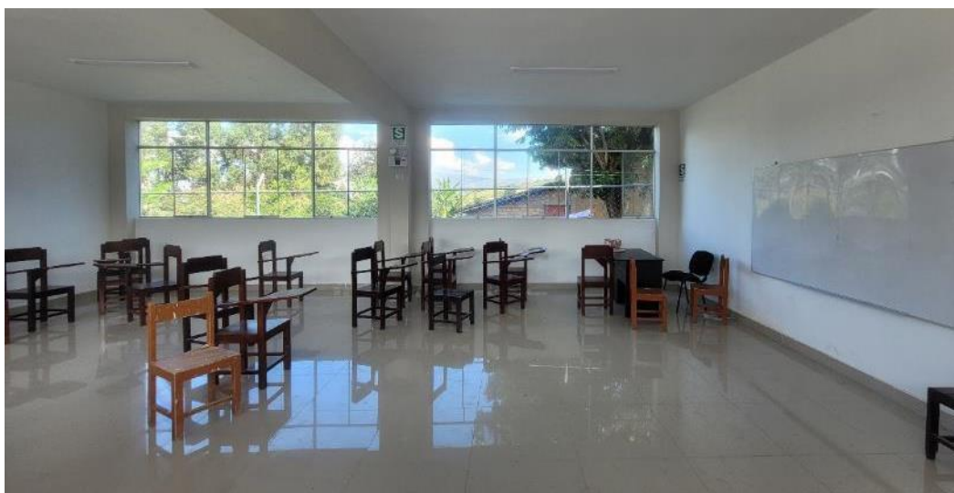
Fotografía 8. Pisos y paredes de aulas no presentan grietas. Coordenadas: E: 819762, N: 9158676.
