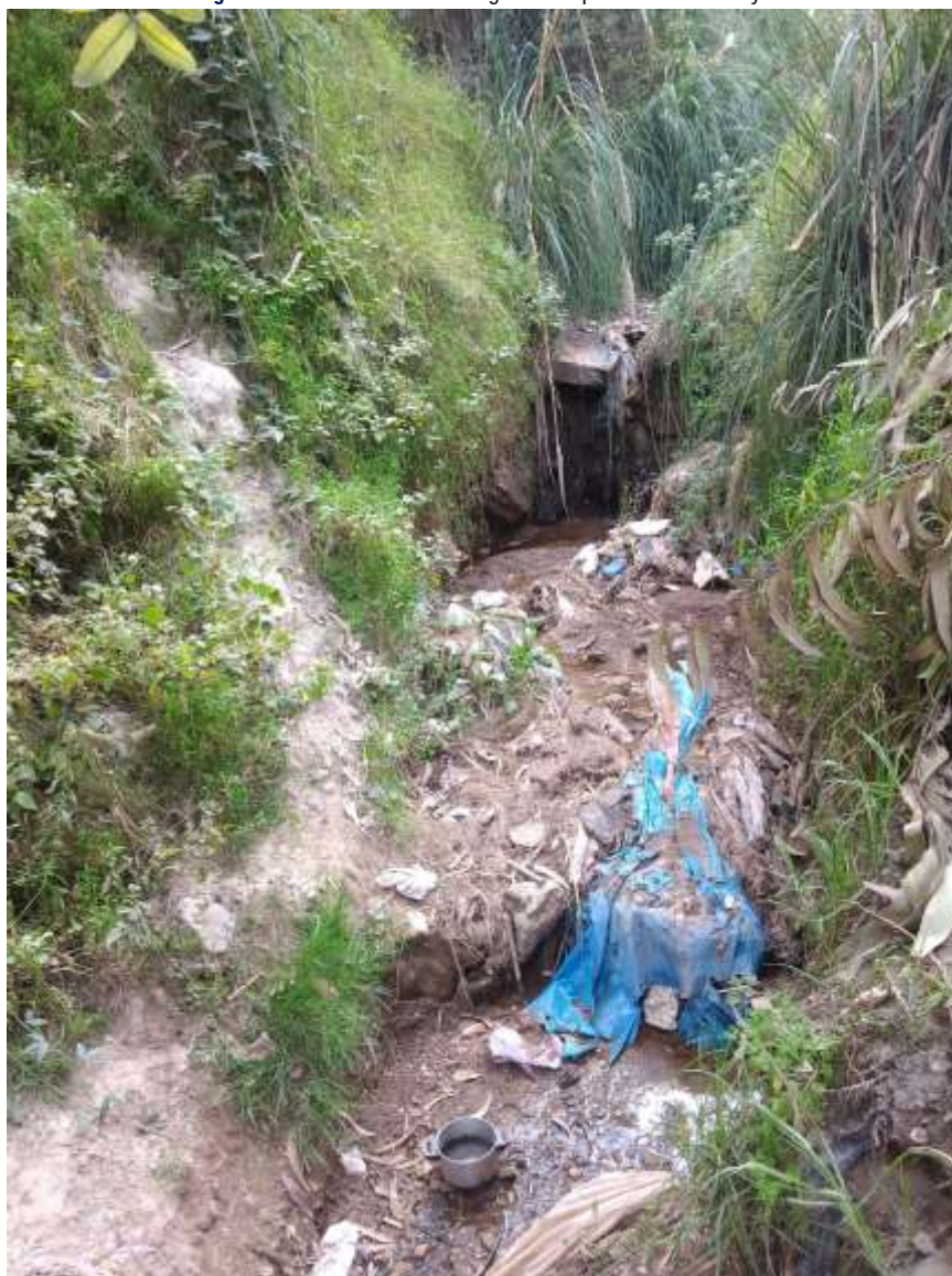
Fotografía 14: Vista del cauce de agua de la quebrada Perol Huaycco.
