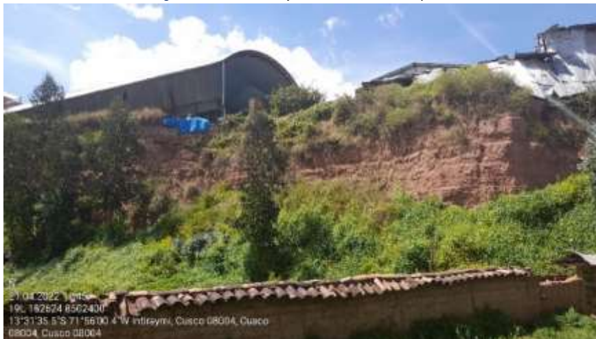
Fotografía 27: Terrazas bajas a la altura de cuarto paradero
