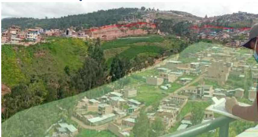
Imagen N° 27: Zonas ubicadas entre 100m a 250m de la falla.
