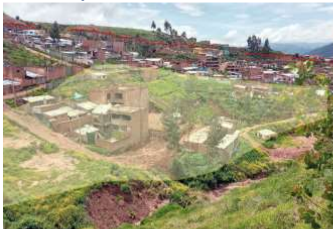
Imagen N° 26: Zonas ubicadas entre 50m a 100m de la falla.
